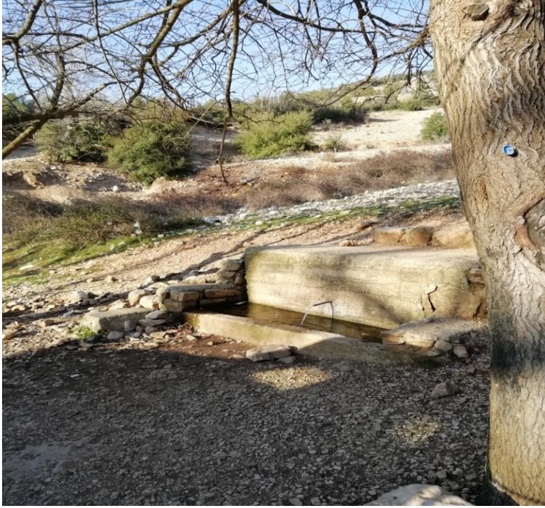
Resim 3. 9. A9 kodlu su kaynağından görünüm
