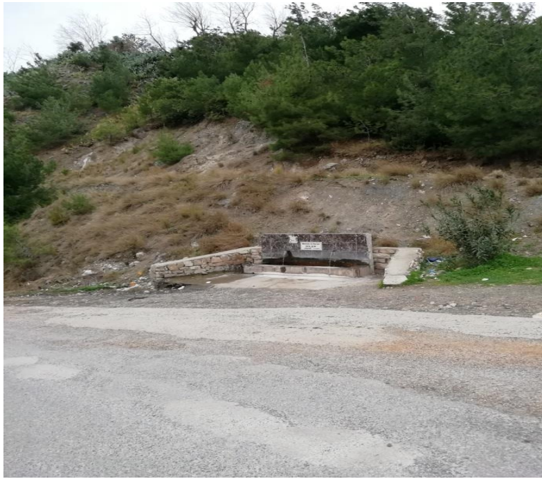
Resim 3. 12. A12 kodlu su kaynağından görünüm
