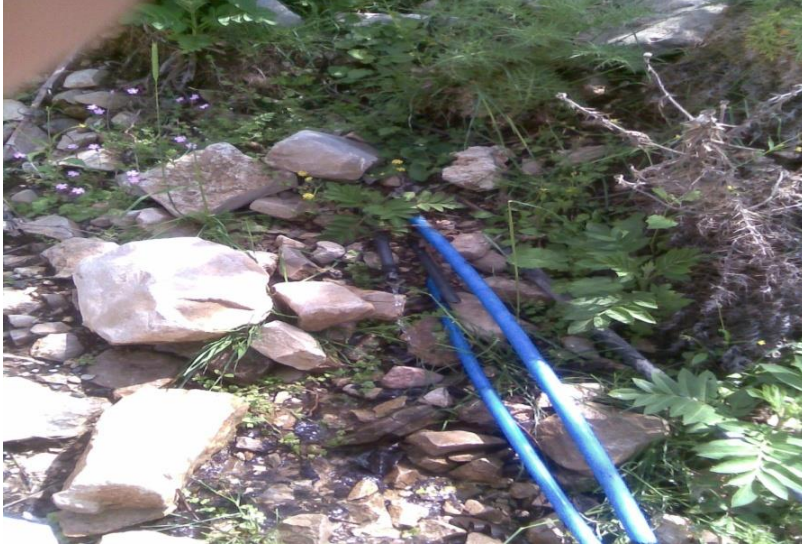
Resim 3. 7. A7 kodlu su kaynağından görünüm
