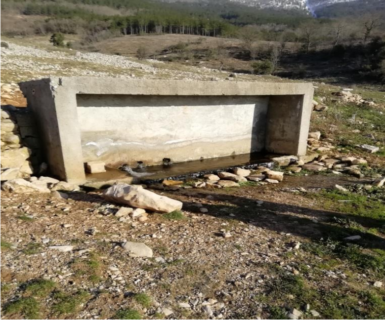
Resim 3. 11. A11 kodlu su kaynağından görünüm
