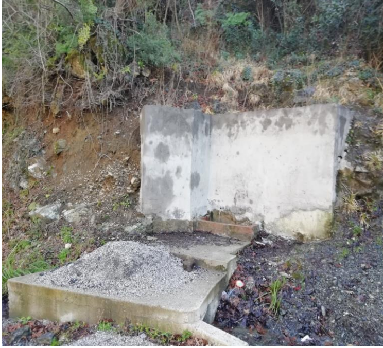
Resim 3. 3. A3 kodlu su kaynağından görünüm
