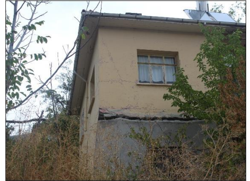
Şekil 5: Koyulhisar ilçe merkezinde heyelan aktivitesi sonucu gelişmiş yapısal hasarlar.
