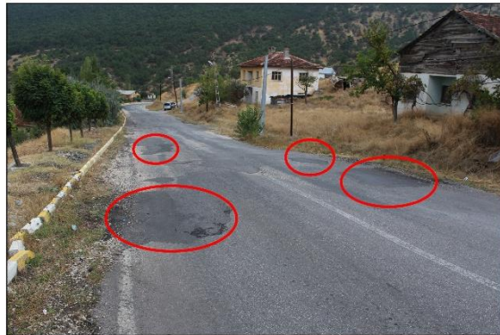
Şekil 5: Koyulhisar ilçe merkezinde heyelan aktivitesi sonucu gelişmiş yapısal hasarlar.
