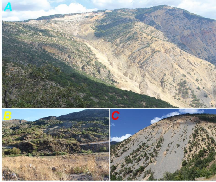
Şekil 30: Çalışma alanındaki heyelan tiplerine örnekler Sugözü'ünde meydana gelen bir akma tipi heyelan (a) (Bakış yönü GB-KD). Kelkit Çayı yan yamaçlarındaki bir kayma tipinde bir heyelan (b) (Bakış yönü K-G). Umurca Köyünün kuzeydoğusundaki kaya düşmeleri (c) (Bakış yönü GD-KB).
