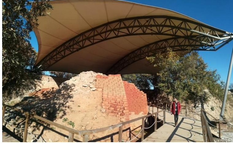
Şekil 3.30: Ön Odalı Yapı koruma çatısı
