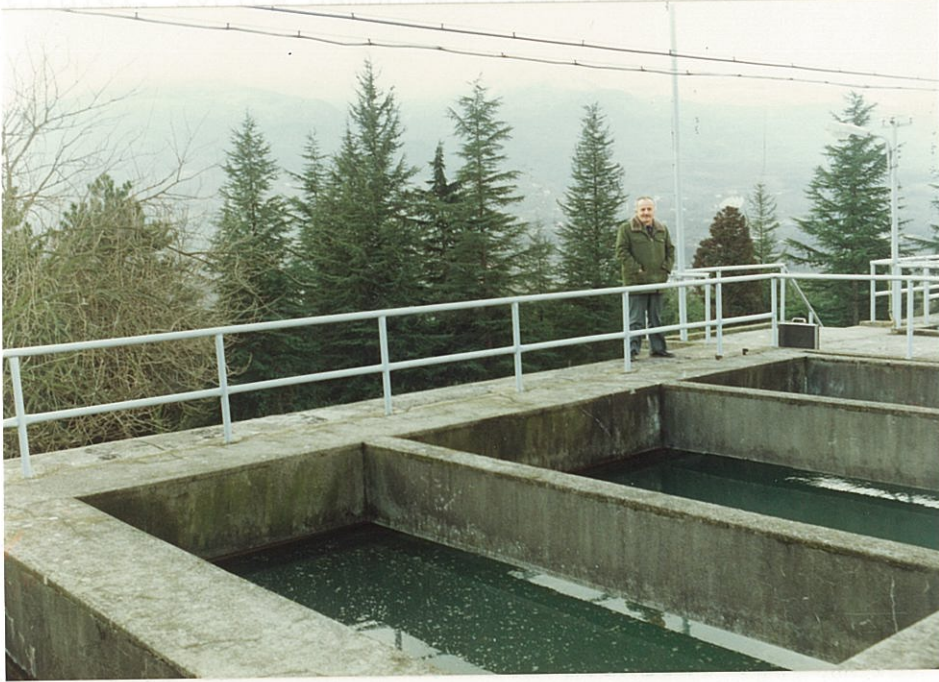
Resim 9: SEKA Ormanı ve Su Deposu İZMİT. Foto: OK
