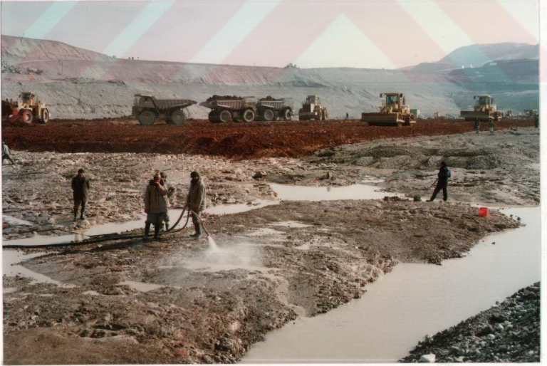
Foto-14 Kil Malzemenin Serileceği Tabanın Basıncılı Su ve Hava İle Hazırlanışı.
