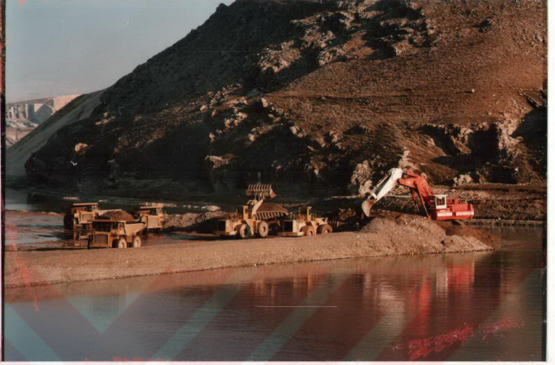
Foto 7 Nehir Yatağından Malzeme Çıkarılışı
