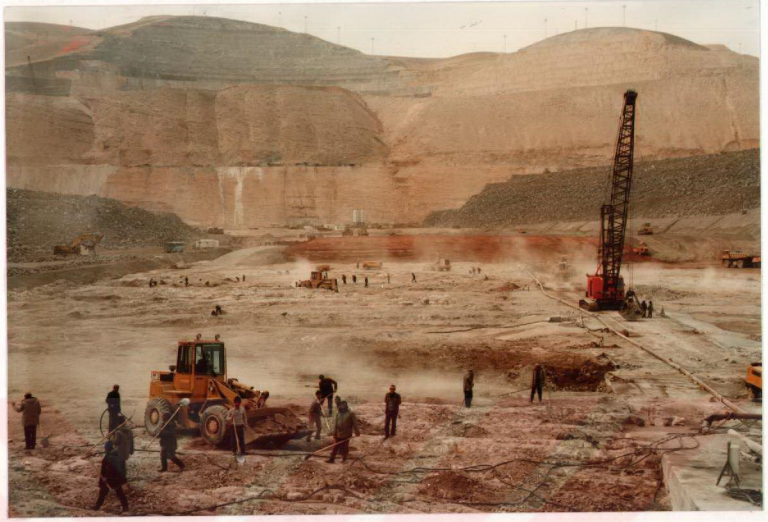
Foto-15 Cut and cover Civarında Kil Malzemesinin Serileceği Kaba Temizlik Çalışmaları
