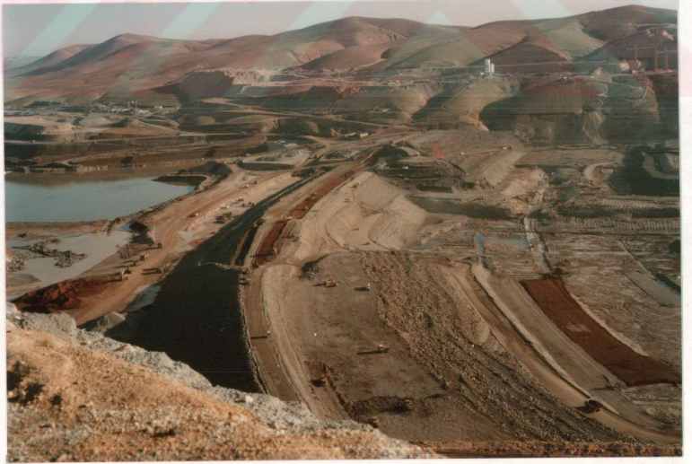
Foto 10 Batardo ve Baraj İnşaatının Başlangıcının Birlikte Görünüşü.
