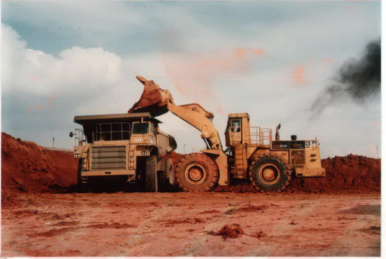
Foto-13 Limitler Dahiline Getirilen Kilin Sahada Yükleme Yapılışı.
