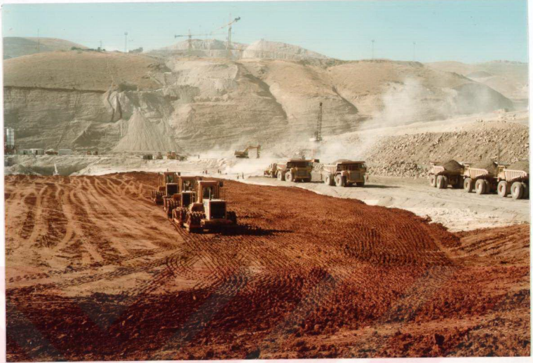
Foto-1 Temel Kazılarında Elde Edilen Killi Kireçtaşı'nın Dolguda Görünüşü
