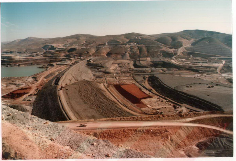
Foto 9 Tabii Nehir Alüvyonun Kullanıldığı Batardonun Genel Görünüşü.
