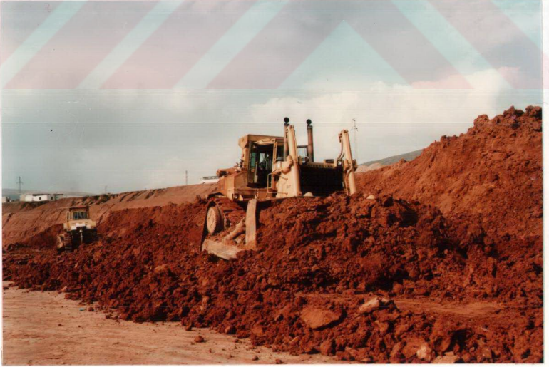
Foto-12 Yağışlı Dönemde Su Muhtevası Fazla Olan Kilin Dozerlerle Havalandırılarak Su Muhtevasının Azaltılışı.
