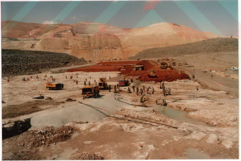
Foto-16 Cut and cover Civarında Son Temizlik, Dış Betonları Kurutma, Kil Seriliği
