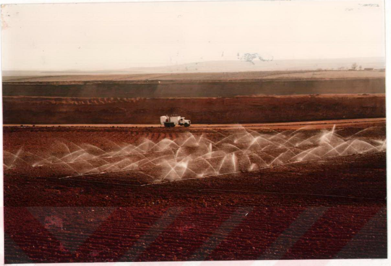
Foto-11 Optimum Su Muhtevasının Dışında Bulunan Kil Sahasının Sulama, Niperleme İle 1,5 m Derinliğinde Bir Kil Tabakasının Yerinde Hazırlanışı.
