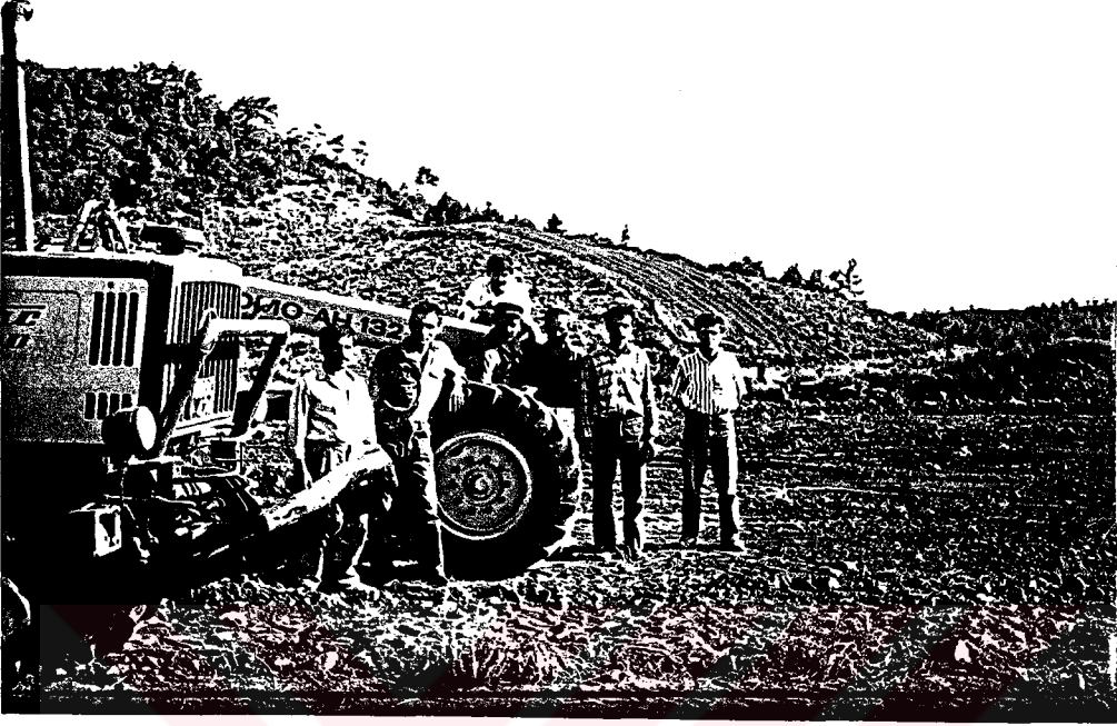
Şekil 8. Yangın Emniyet Yolu Yapım Çalışmaları.
