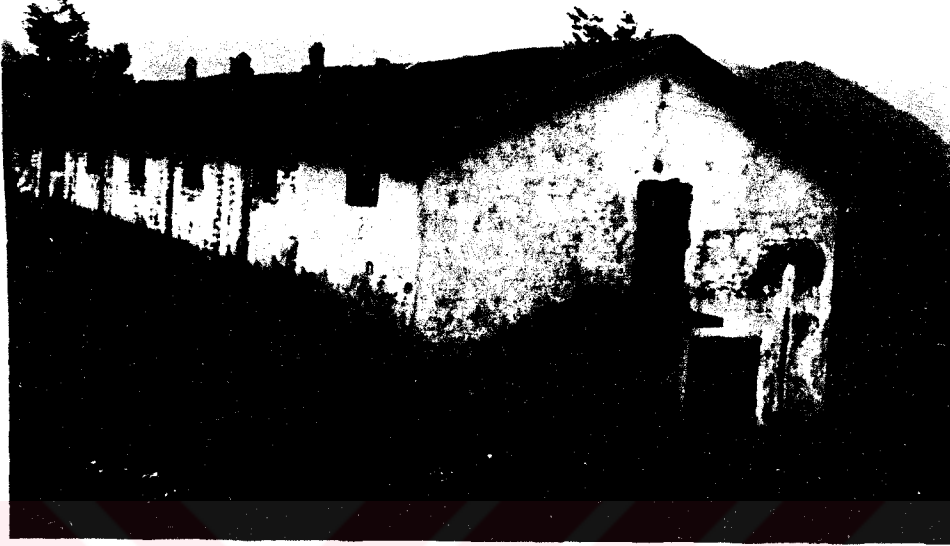
Resim 4.2. Ordu İli Ulubey İlçesinde Üretimden Vazgeçmiş Bir Besi Sığırını Barınağı
