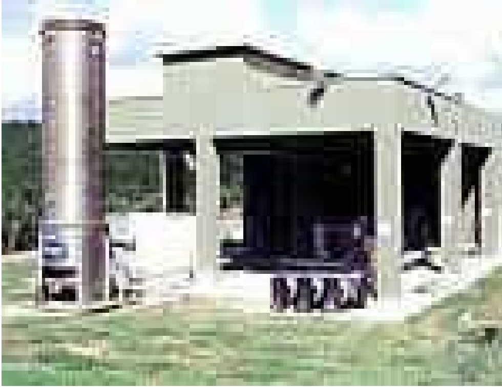
Şekil 3.1: Kemberburgaz hasdal enerji üretim tesisi [27]
