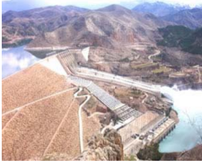
Şekil 1: :Keban barajı genel görünüşü ( http://www.dsi.gov.tr/baraj/detay.cfm?BarajID=54 )
