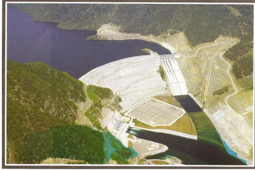
Şekil 2.10: Altinkaya Barajı genel görünüşü http://www.dsi.gov.tr/baraj/detay.cfm?BarajID=112
