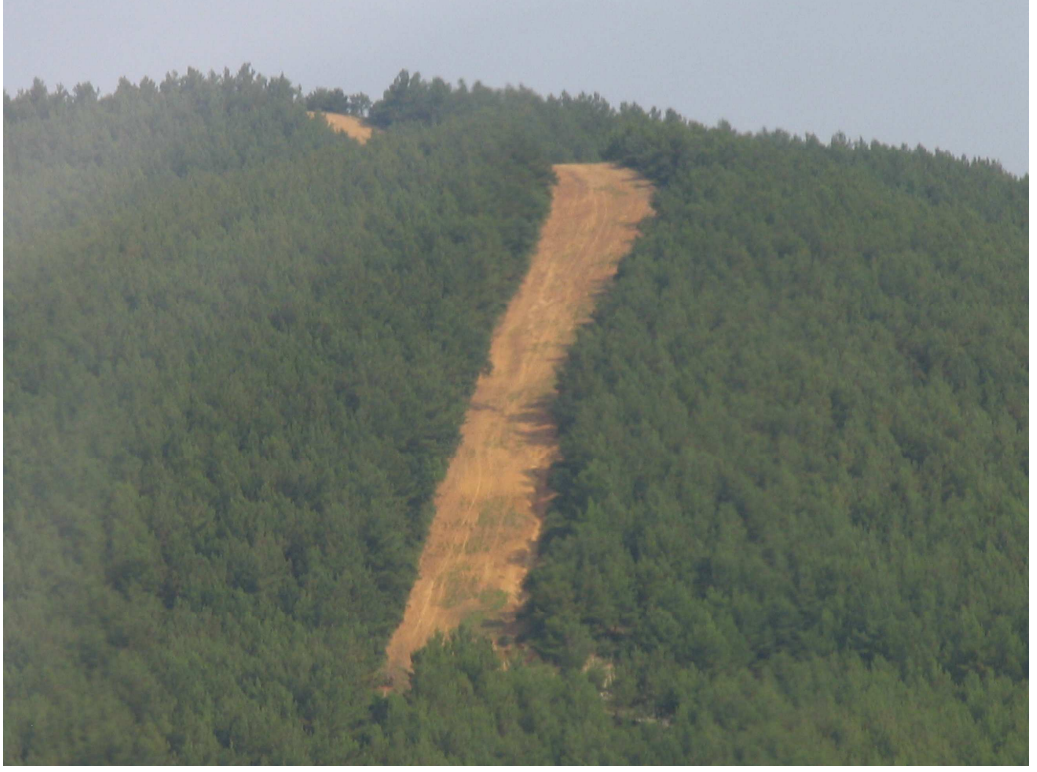
Şekil 2.7: Keşan-Korudağ Yangın Emniyet Yolu (Foto: E. Bilici, 2007)
