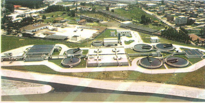
Resim 1.2: İzmit Biyolojik Atıksu Arıtma Tesisinden genel görünüm
