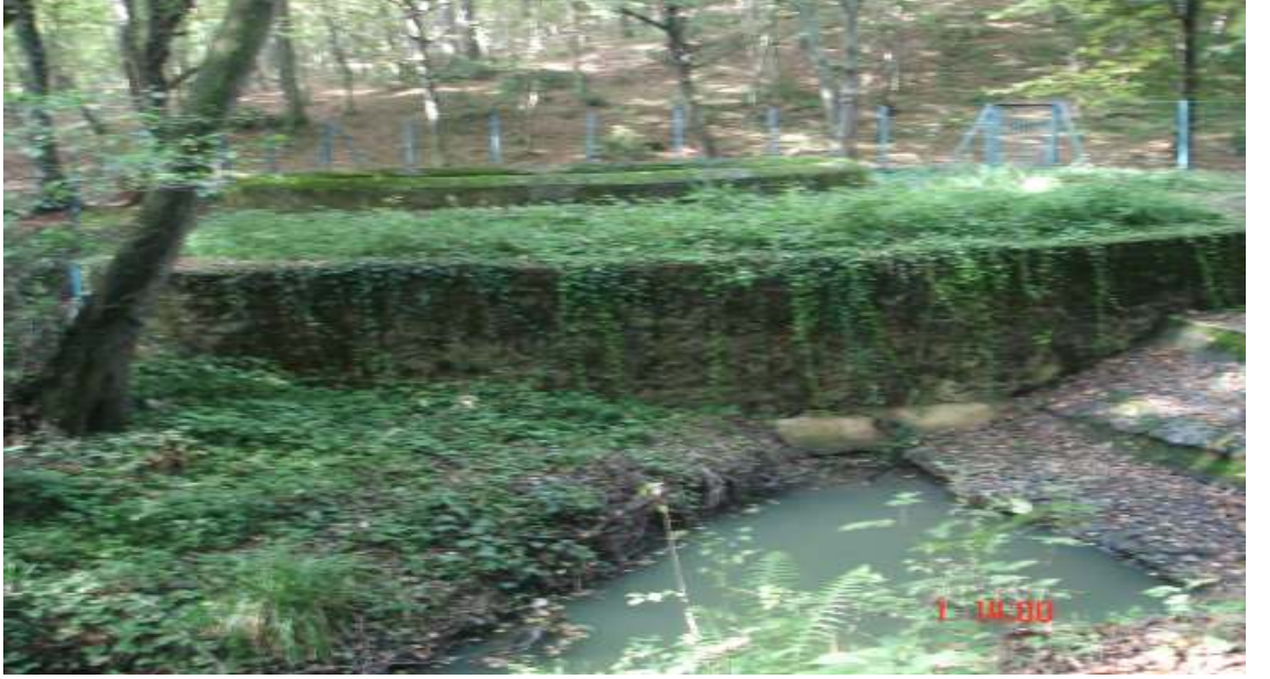
Şekil 3.16: Su toplama kaptajı (Kirazlıbent)
