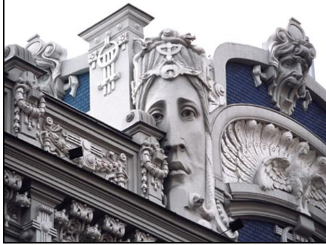
Şekil 2.14: Art Nouveau etkisinde bina mimarisi (Anonim, 14).
