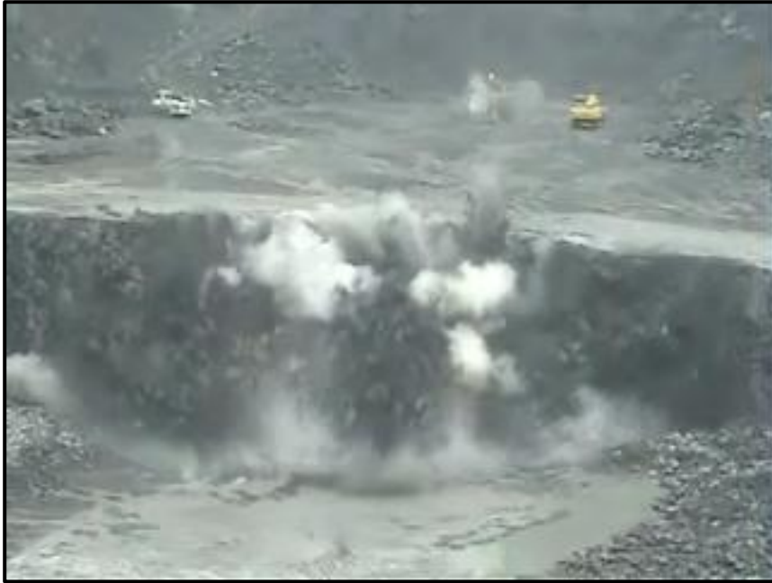
Şekil 3.14 Örnek bir patlatma faaliyetinde patlama işleminin sonuçlandığı andaki görünüm
