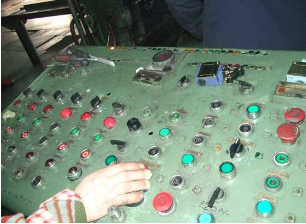
Şekil 4.2 Kumanda panosunun revizyon öncesi durumu
