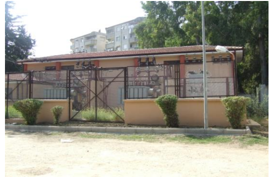
Şekil Ek-B.29 : Trafo Binası
