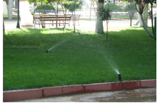
Şekil Ek-B.37 : Otomatik Sulama Sistemi
