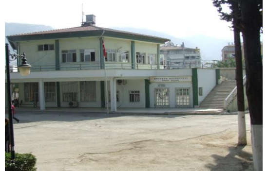
Şekil Ek-B.4 : Evlendirme Dairesi ile Park ve Bahçeler Müdürlüğü Binası
