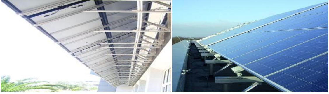
Şekil 4.5: PV panellerinin çatıda yerleştirilmesi
