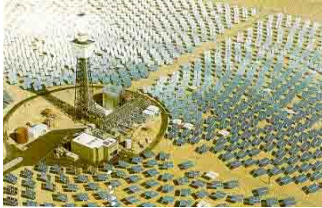
Şekil 2.11 Merkezi alıcılı güneş termoelektrik santrali
