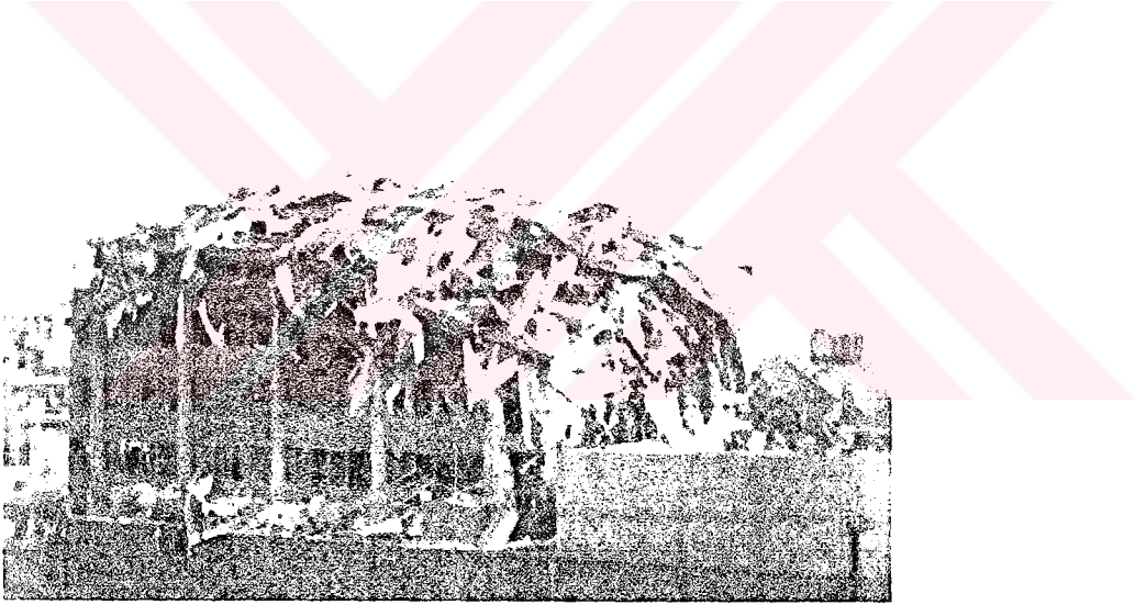
Resim 5.2. Rezonans İle Bir Katın ve Üzerindekilerin Çökmesi, Meksico, 1985
