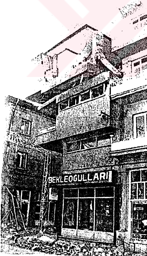
Resim 5.3. Farklı Döşeme Seviyesine Sahip İki Binanın Çarpışması, Dinar, 1995.
