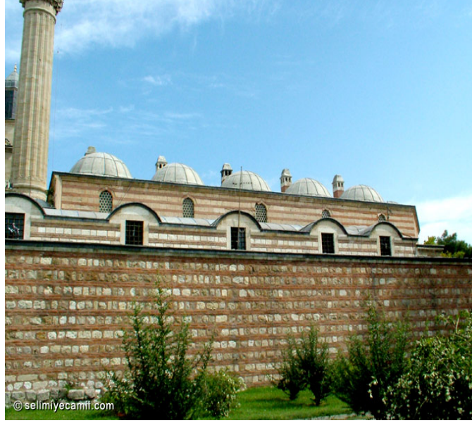
Şekil 4.3: Duvarlar arası sık hatıllar – Selimiye Cami (Edirne-Türkiye)
