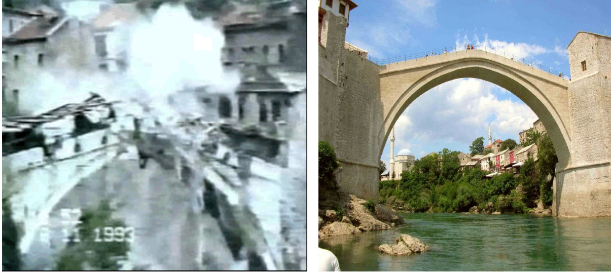
Şekil 4.15: Tarihi Mostar Köprüsü (Saraybosna-Bosna Hersek) (Foto: itusozluk.com) (Foto: itusozluk.com)
