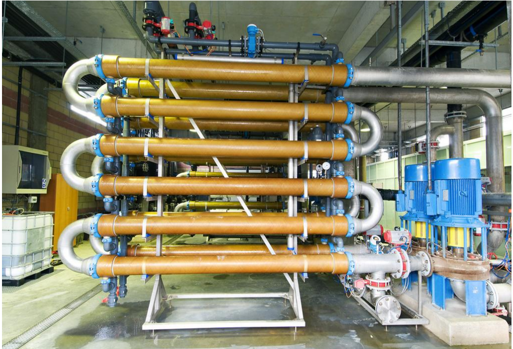
Şekil 3.7 UltraFiltrasyon Membran Ünitesi
