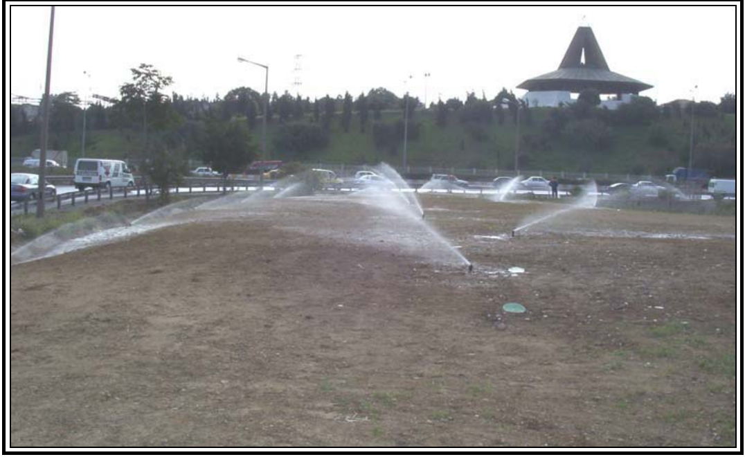
Şekil 4.30 Otomatik sulama sisteminin tesis edildikten sonra denenmesi (Anonim, 2010g)
