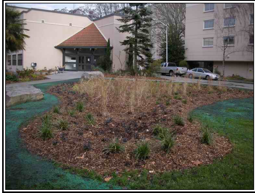
Şekil 2.43 Yağmur bahçesinin tamamlanmış hali (Anonim, 2008b).
