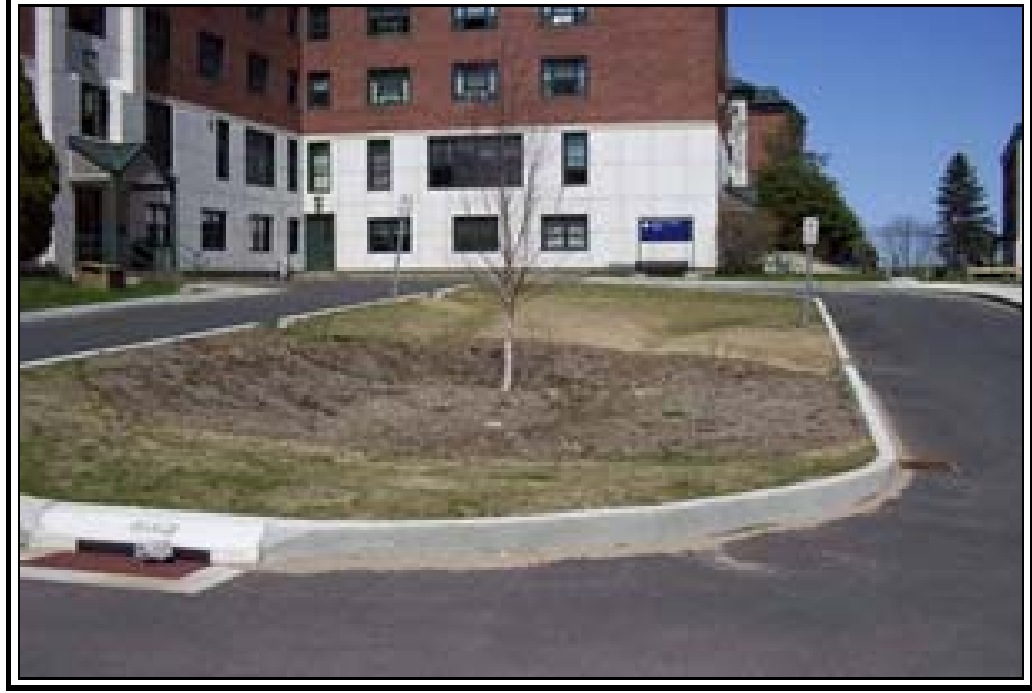
Şekil 2.28 Yol kenarında kurumuş olan bir yağmur bahçesi, yağmur sezonu ile birlikte tekrar canlanacaktır (Anonim, 2004).
