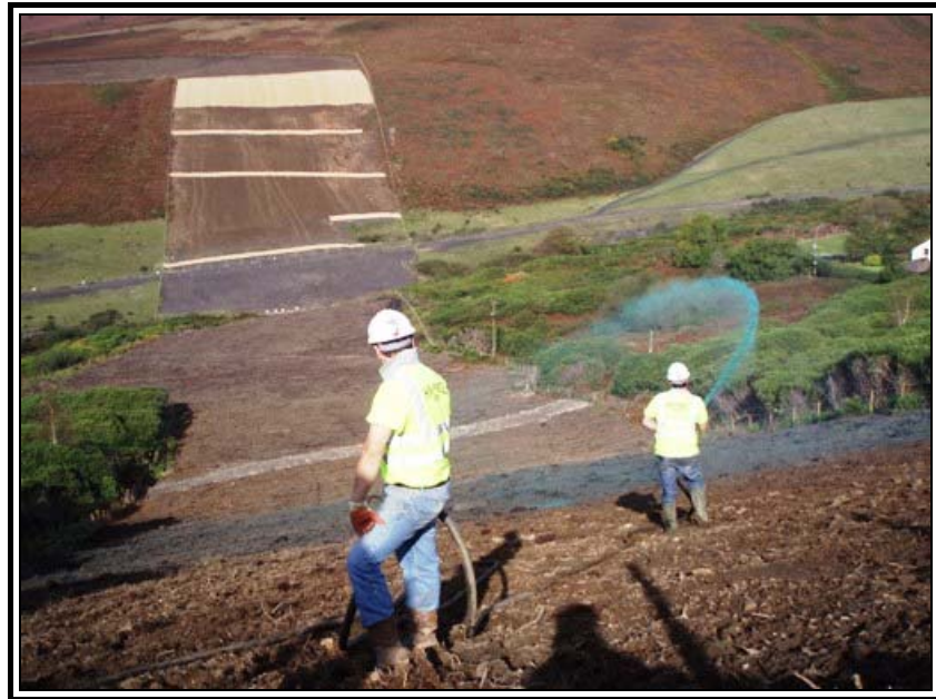
Şekil 4.23 Hydroseeding uygulaması (Anonim, 2011h).
