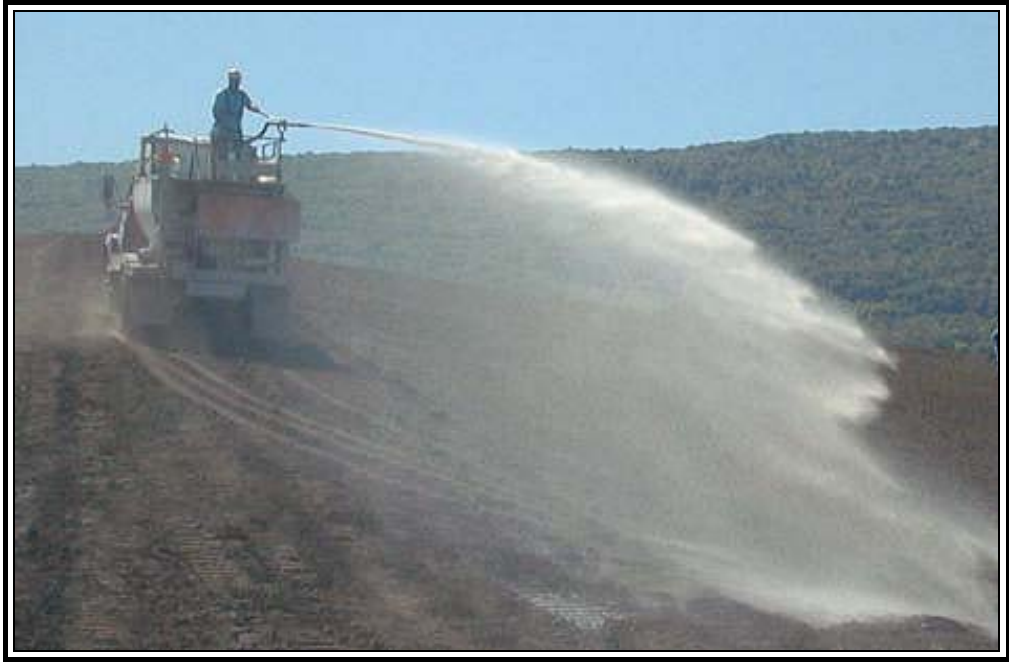
Şekil 4.25 Geniş alanlarda hydroseeding uygulaması (Anonim, 2011h).
