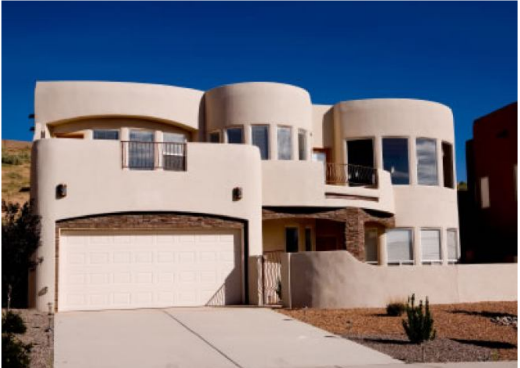
Şekil 2.10: Modern kerpiç yapı, New Mexico [23]
