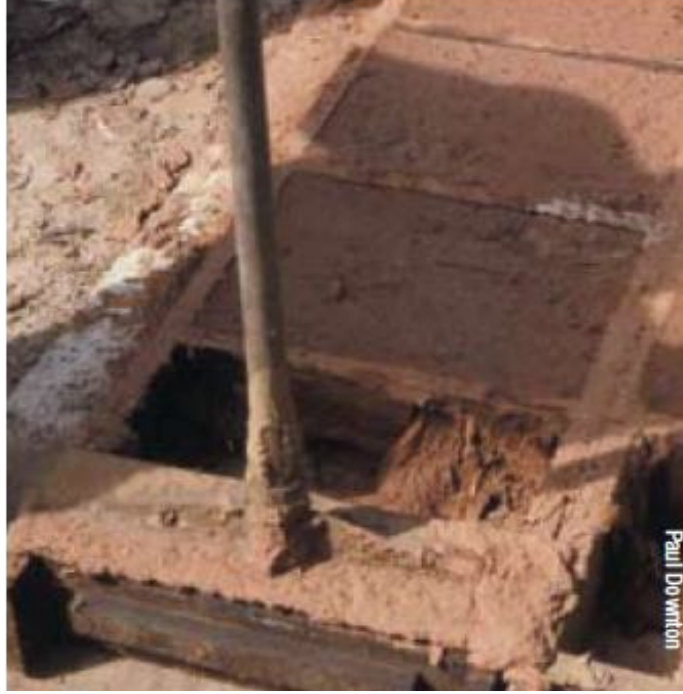
Şekil 2.6: Kerpicin kalıplanması [16]
