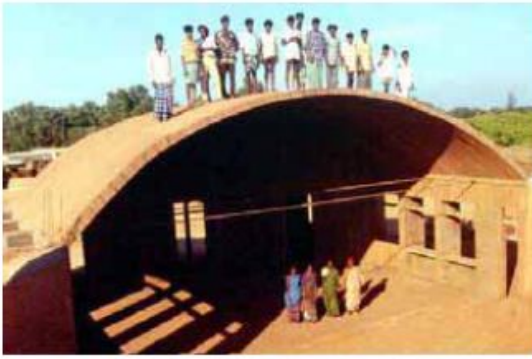
Şekil 2.14: Mirramukhi okulu, 10,35 m açıklık, 2,25 m yükseklik, 30 ton, 3 haftada inşa edilmiştir, Auroville [22]
