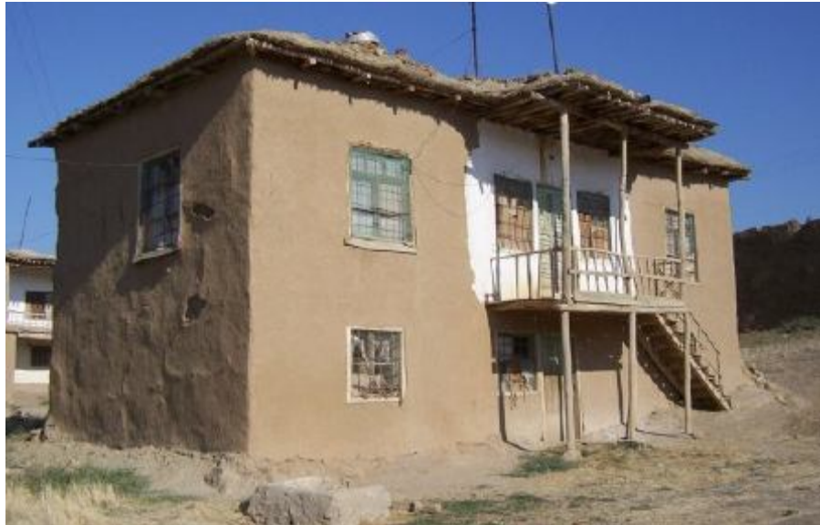
Şekil 2.18: Acıkuyu Köy Evi, Ankara, Foto: Can CÖMERT
