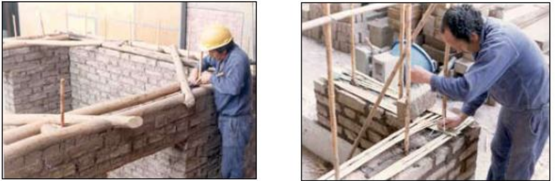
Şekil 2.9 Kerpiç duvar imalatı [3]
