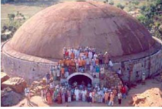
Şekil 2.13: Dhyanalingam tapınağının kubbesi, çapı 22,16 m, yüksekliği 7,90 m, 570 ton, 9 haftada inşa edilmiştir, Coimbatore [22]
