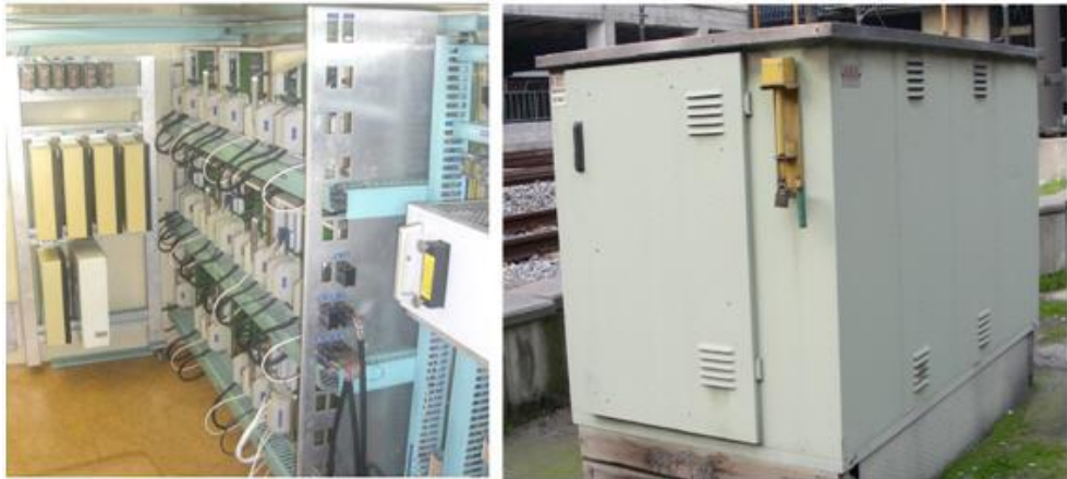
Şekil 2.21 Sinyalizasyon Saha Kabinleri
