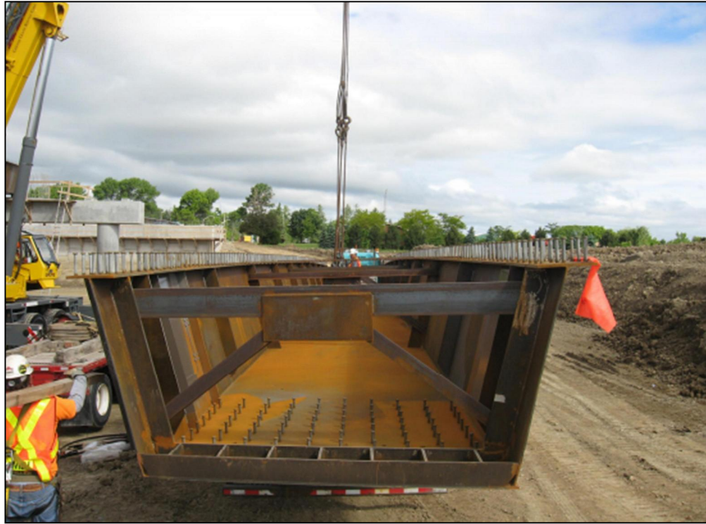
Şekil 2.3: Kompozit kutu kesitli kiriş köprü iskeleti
