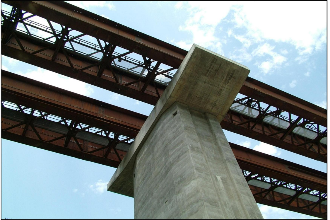
Şekil 2.5: Kompozit I kesitli kirişli köprü iskeleti
