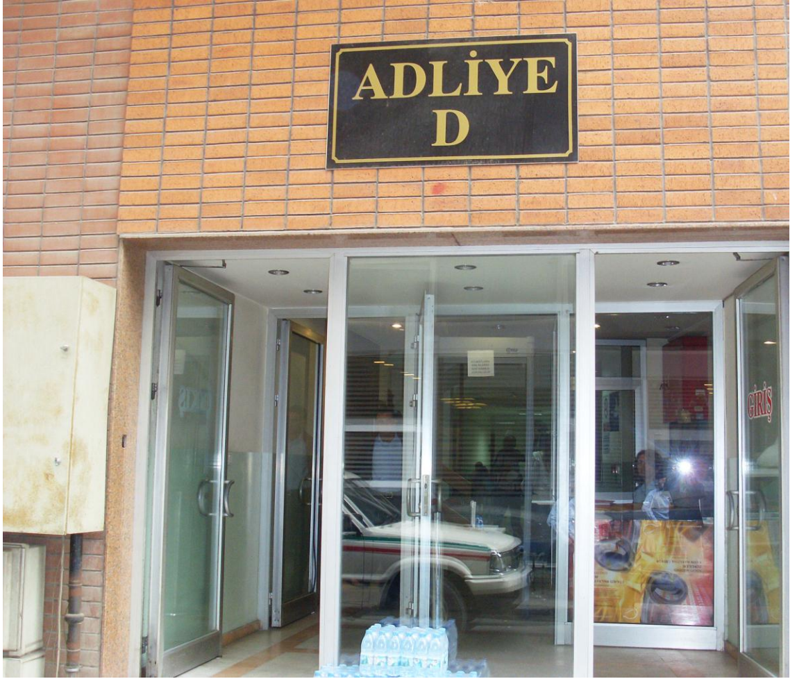
Şekil Ek.6 Kadıköy Adliyesi D Blok
