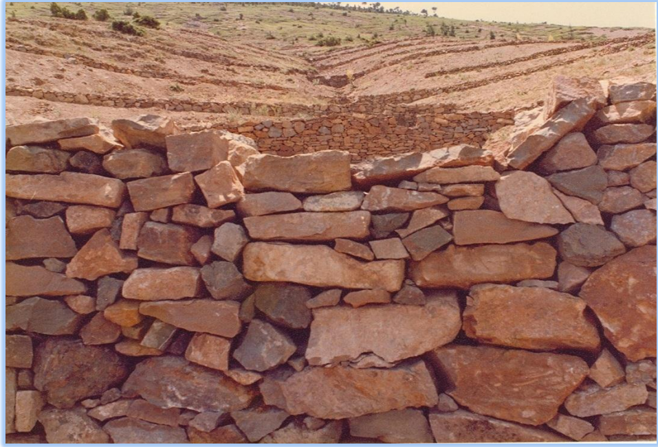
Şekil 3.4: Proje Kapsamında Yapılan Kuru Eşik Duvarlardan Bir Örnek (Fotoğraf: Niğde İl Çevre ve Orman Müd., 1983).
