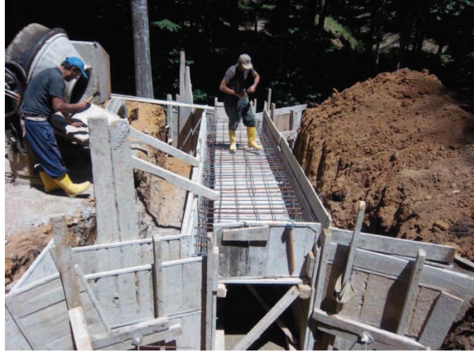
Şekil 2.17: Kutu menfezin kalıplarının çakılması ve tavan betonunun dökülmesi(Fotoğraf: KÜÇÜKDEMİR)
