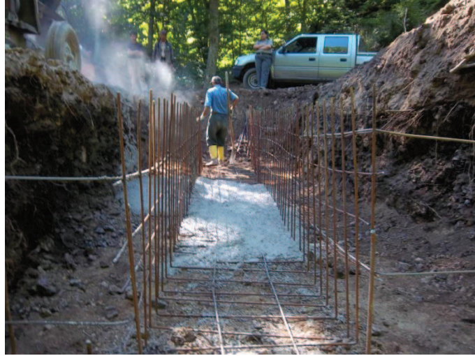
Şekil 2.15: Kutu menfezlerin taban betonunun dökülmesi(Fotoğraf: KÜÇÜKDEMİR)
