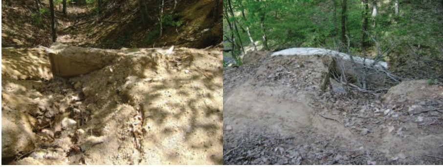
Şekil 4.15: Menba ve mansap tarafındaki toprak kaymaları (Fotoğraf: GÖRMEZ)
