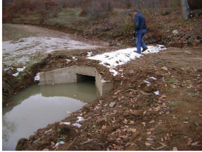
Şekil 4.10: Çalışma alanında bulunan giriş ve çıkışı kapalı menfez örneği (Fotoğraf: GÖRMEZ)
