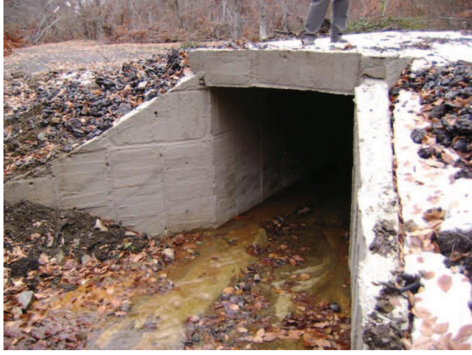
Şekil 2.13: Menfez girişlerindeki baş duvarlar (mema tarafı) (Fotoğraf: GÖRMEZ)
