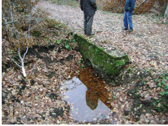
Şekil 2.10: Kenar hendeğinde toplanan suyu yolun diğer tarafına aktaran büz örneği (Fotoğraf: GÖRMEZ)
