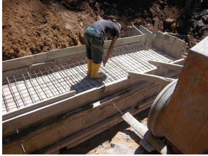
Şekil 2.14: Betonarme menfezlerin yapımında demir işçiliği(Fotoğraf: KÜÇÜKDEMİR)
