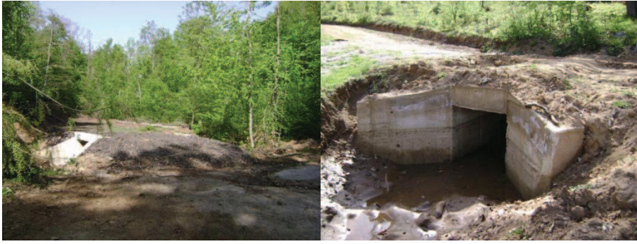
Şekil 4.11: Yol üst kotundan yüksek inşa edilen menfez örnekleri (Fotoğraf: GÖRMEZ)
