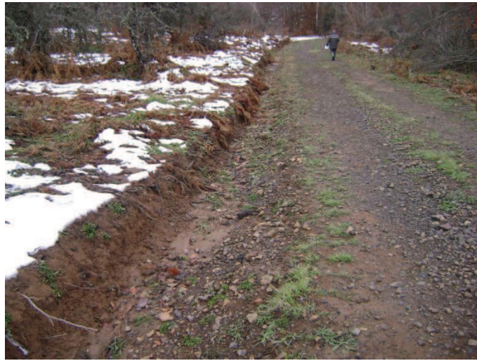
Şekil 2.8: Orman yolları kenar hendekleri (Fotoğraf: GÖRMEZ)
