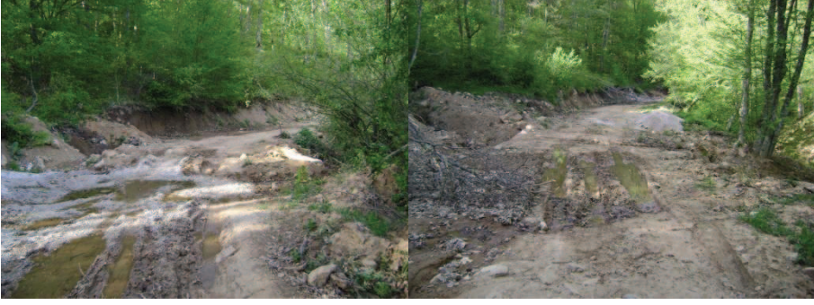
Şekil 4.13: Drenaj sorunlu menfez örnekleri (Fotoğraf: GÖRMEZ)
