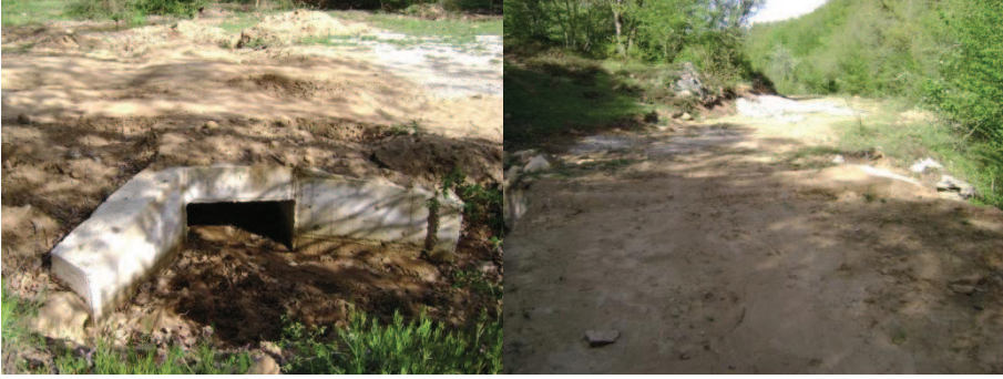
Şekil 4.14: Sağında ve solunda dolgu çökmesi olan menfez örnekleri (Fotoğraf: GÖRMEZ)
