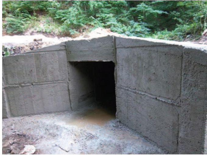
Şekil 2.19: Kutu menfezlerde kanat duvarları (Fotoğraf: GÖRMEZ)
