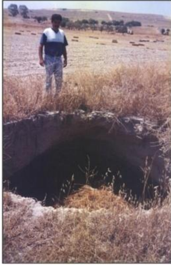
Şekil 4.63. Akıncılar bölgesinde gelişmiş göçme boşluğu (Necdet,2002).
