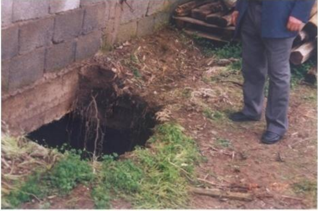
Şekil 4.62. Cihangir köyü'nün batısında bulunan Minareliköy'de oluşmuş göçme boşluğu (Necdet,2002).
