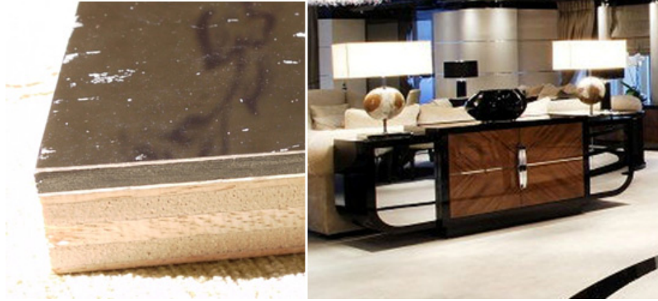
Şekil 2. 16: Alpolitic levha yapısı (solda) ve Talisman C yatı büfesindeki uygulaması.
