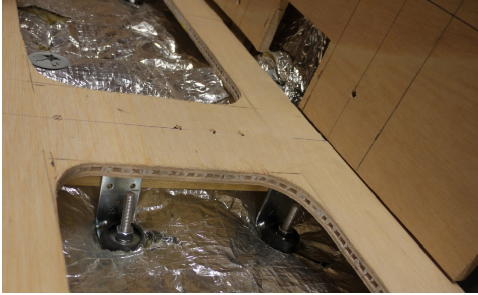
Şekil 2. 12: PVC ve Balsa çekirdekli sandviç duvar ve tavan panelleri.
