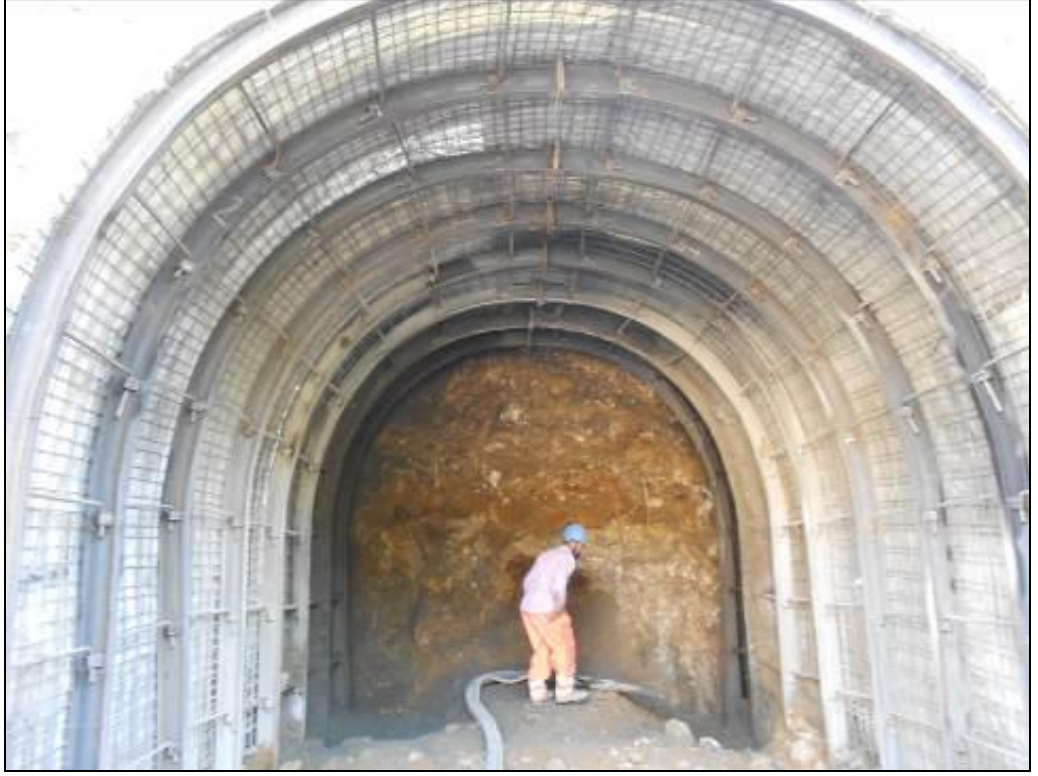
Şekil 3. 13 Püskürtme beton (shotcrete) hazırlığı
