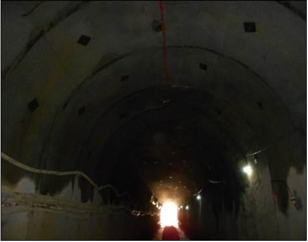
Şekil 3. 14 Çakılmış haldeki enjeksiyonlu kaya bulonu
