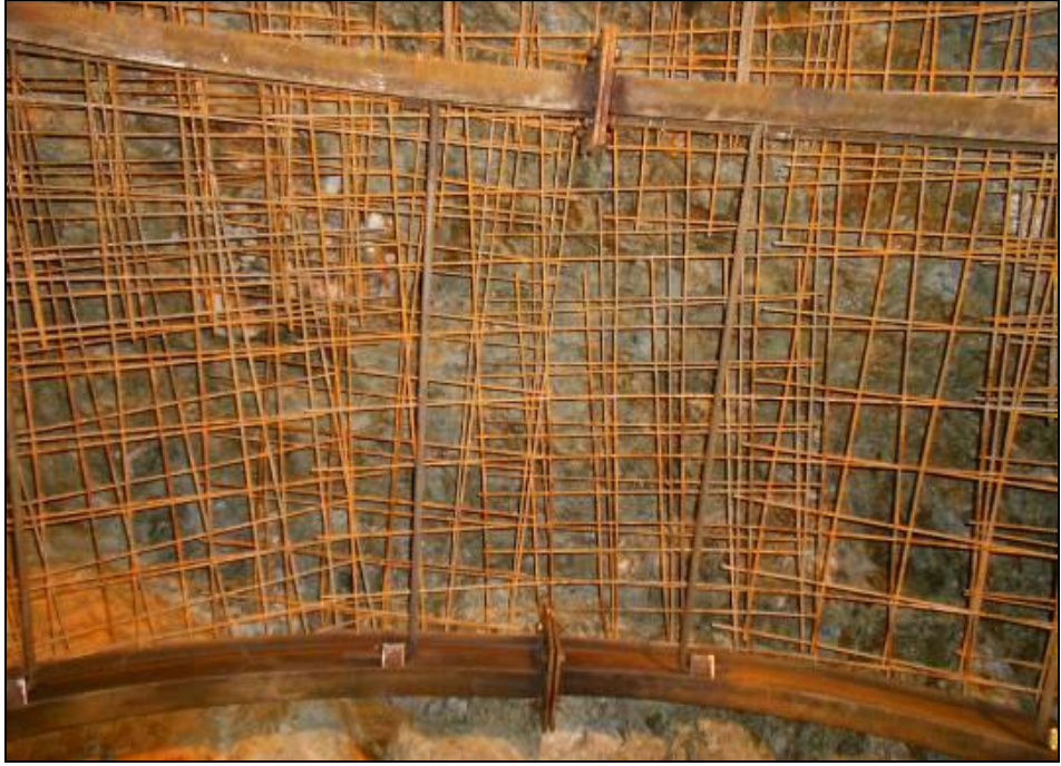
Şekil 3. 10 Çelik hasır montajı
