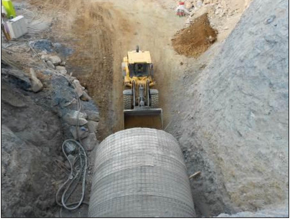
Şekil 2. 11 Yükleyici (loder) ile pasa taşınırken
