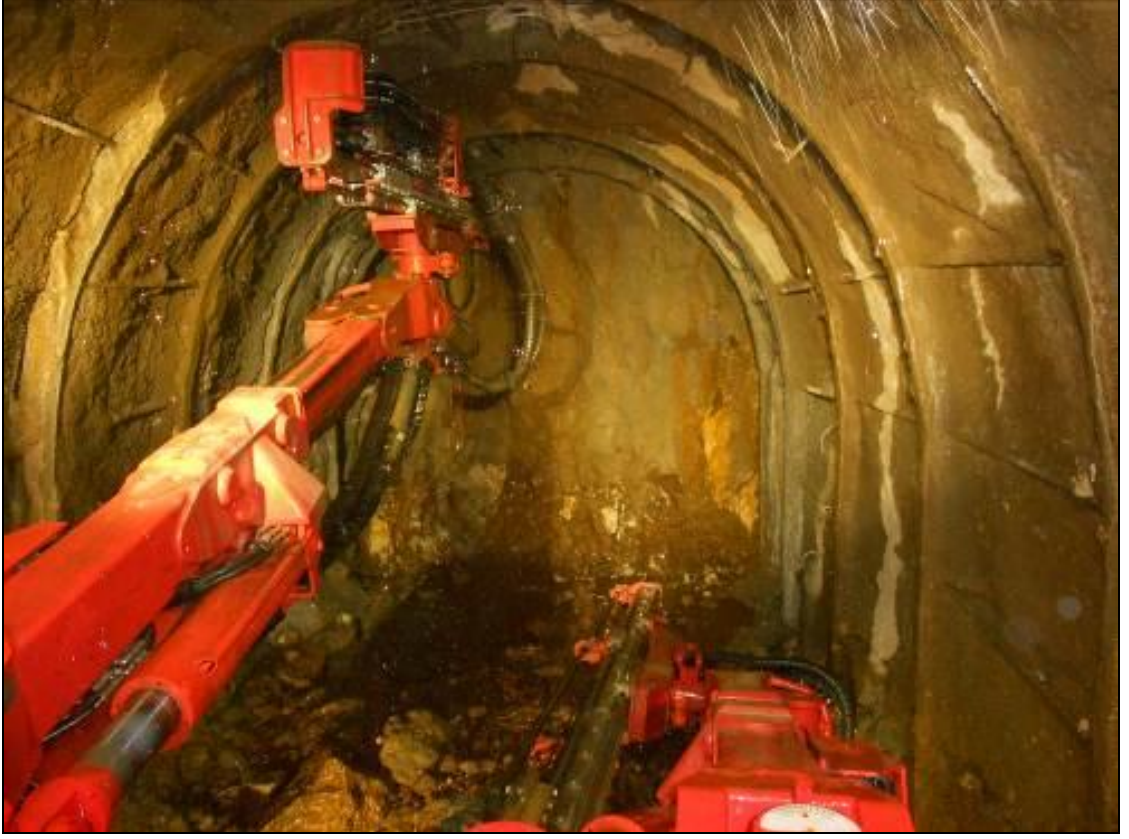
Şekil 2. 14 Jumbo ile patlatma deliklerinin açılması
