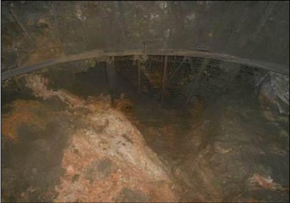
Şekil 4. 7 Göçük sonucu süren uygulaması
