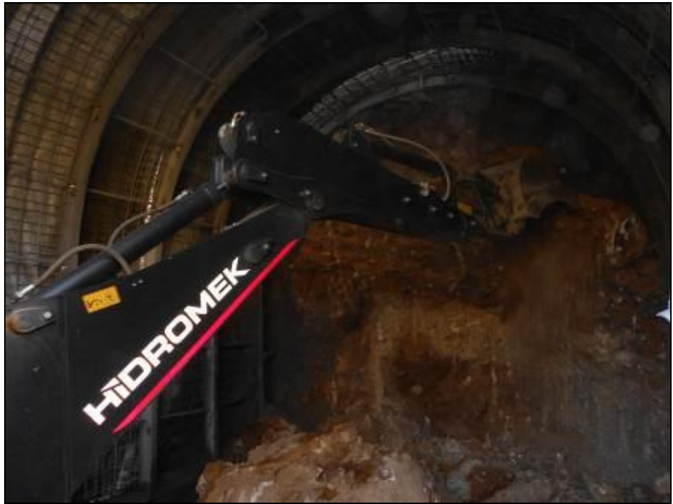
Şekil 2. 10 Kazıcı- yükleyici (Beko-loder) ile kazı yapılırken
