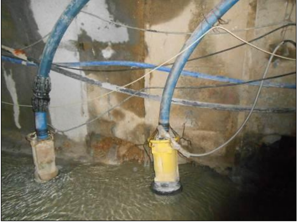
Şekil 4. 2 Suyun dalgıç pompa ile dışarı pompalanması
