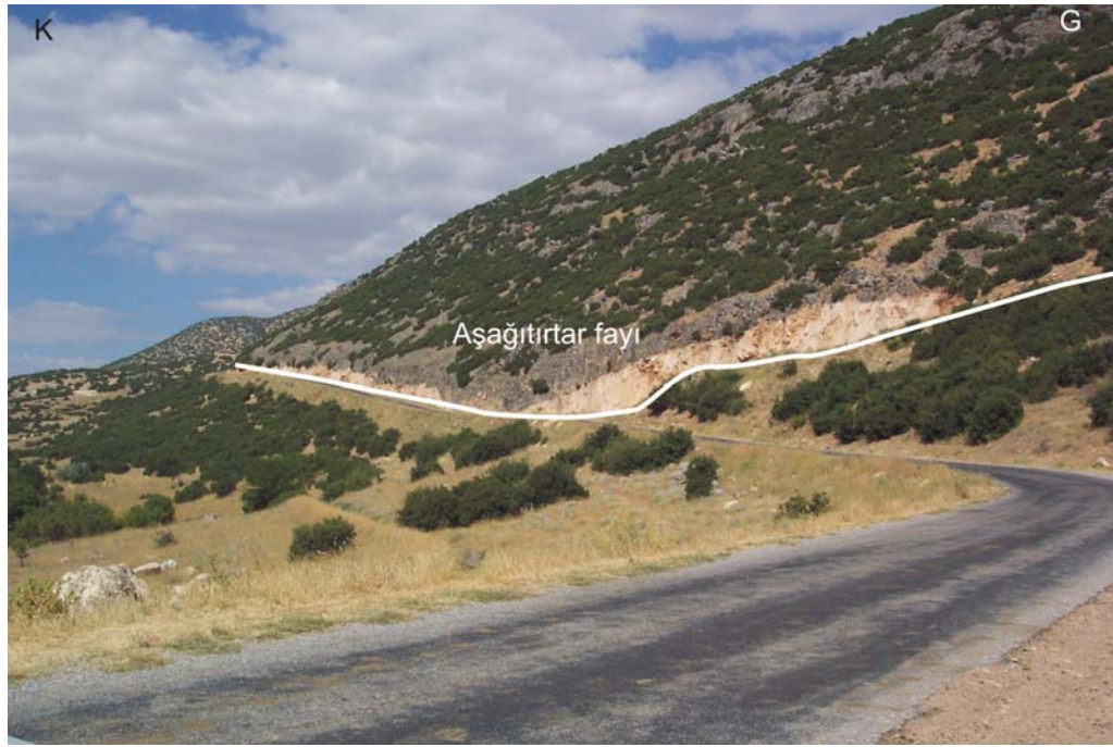
Şekil 4.33. Aşağıtirtar fayı (Aşağıtirtar köyü kuzeyi).
