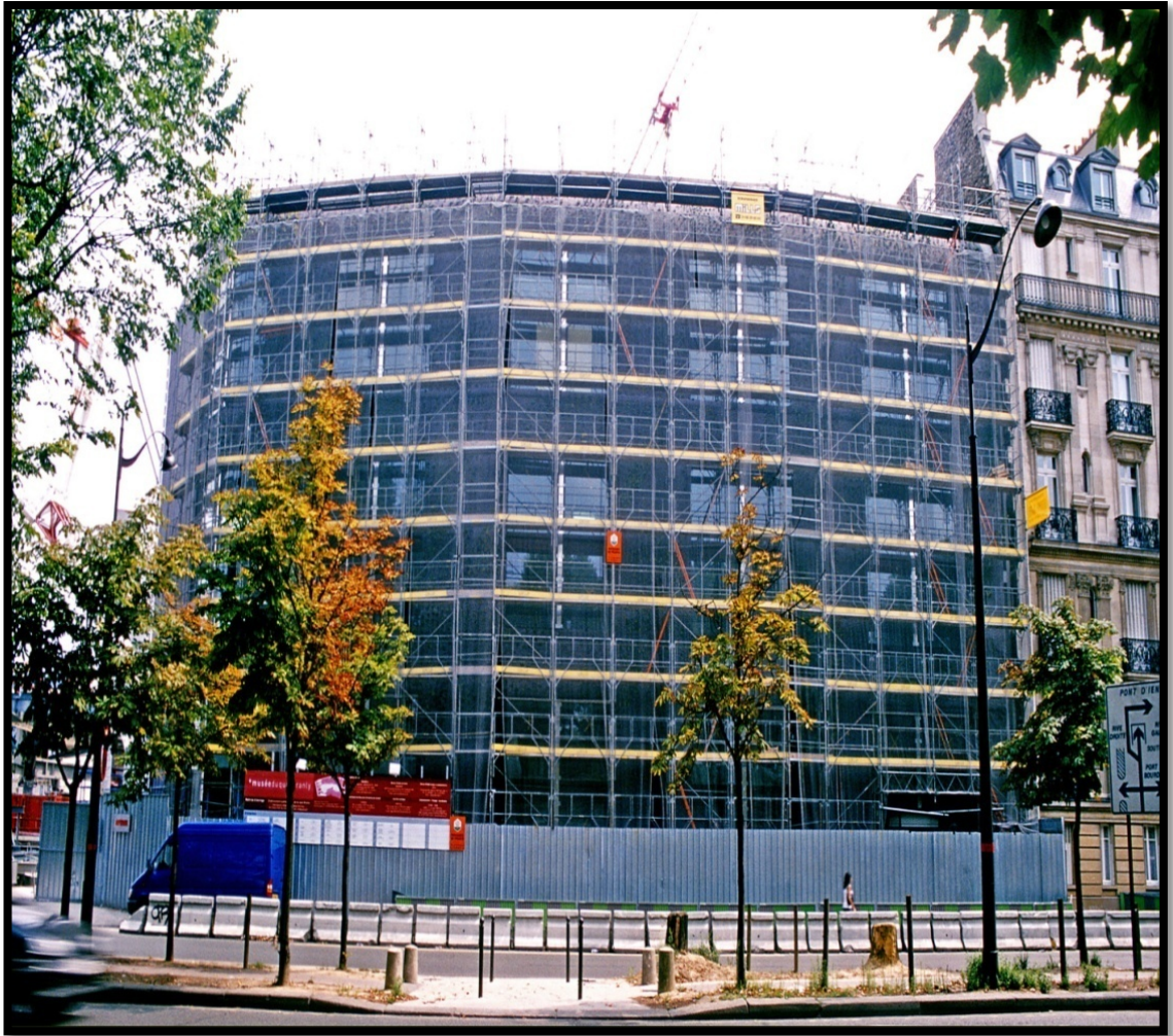
Şekil 3.12: Quai Branly Müzesi Dış Mekan Dikey Bahçe Uygulaması için tesis öncesi yapı iskelesinin kurulması Temmuz 2005 34 .
