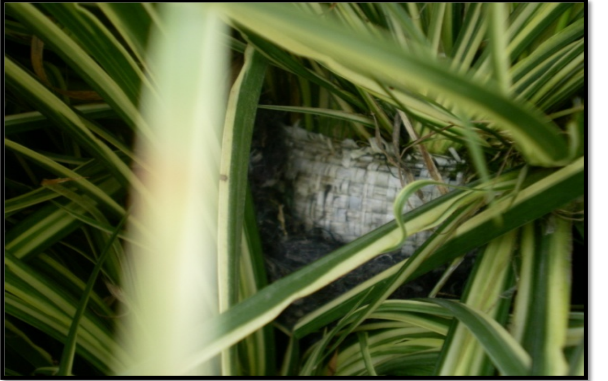
Şekil 3.67: Gebze Belediyesi Kent Meydan Parkı Dış Mekan Dikey Bahçe Uygulamasında bitkinin yetiştirme ortamı olarak jeotekstil keçe katmanı.
