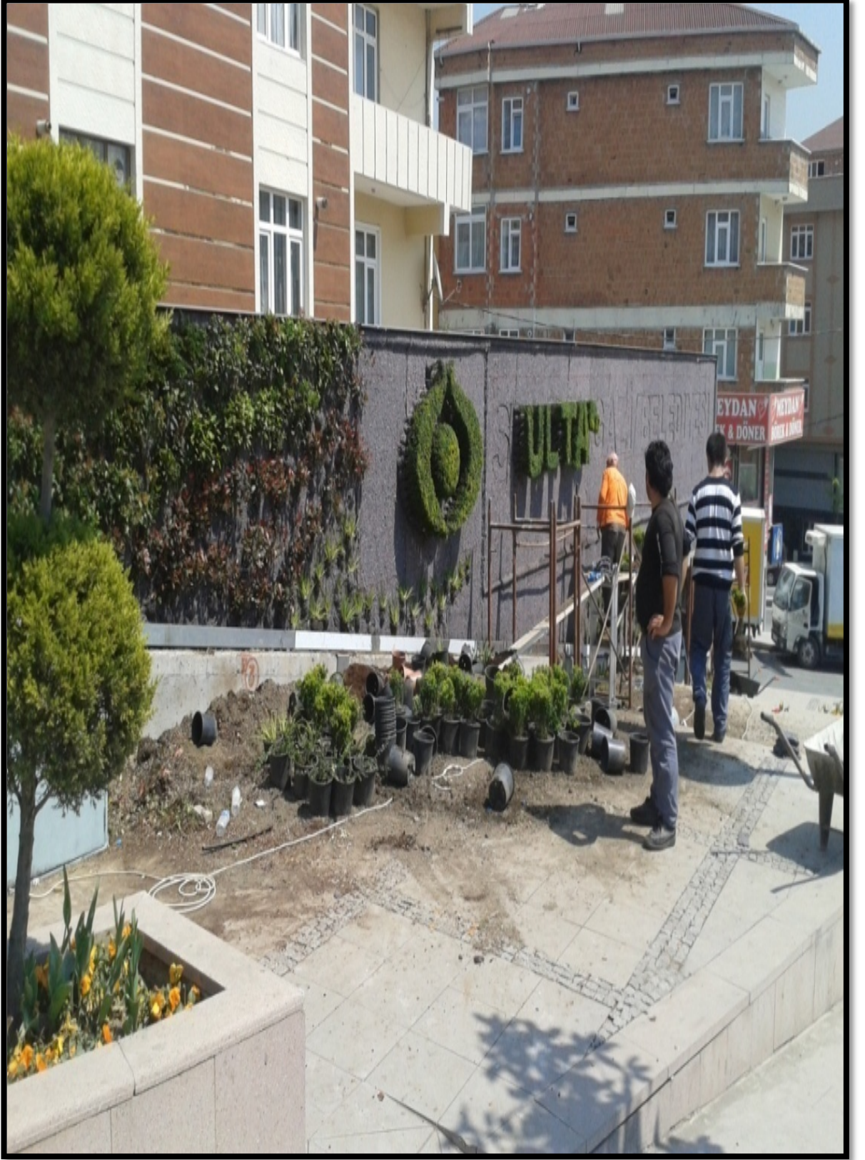
Şekil 4.19: Sultangazi Belediyesi Adem Yavuz Meydan Parkı Dış Mekan Dikey Bahçe Uygulamasında 2. kat keçe katmanının zimbalarla 1. kat keçe katmanına tutturulduktan sonra bitkilendirme işlemine geçilmesi.
