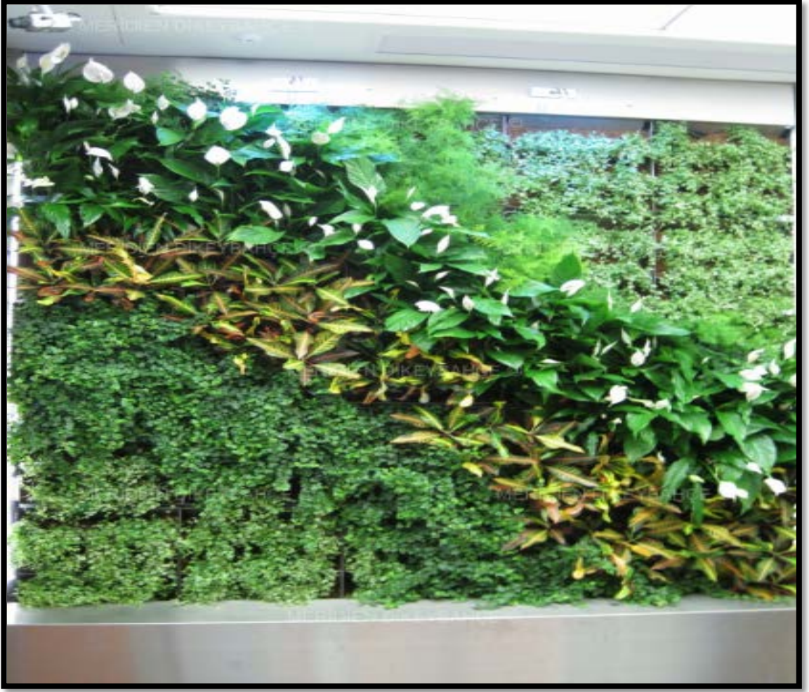
Şekil 2.49: Glaxo Smith Kline İç Mekan Modüler Yaşayan Duvar Sistemi 13 .
