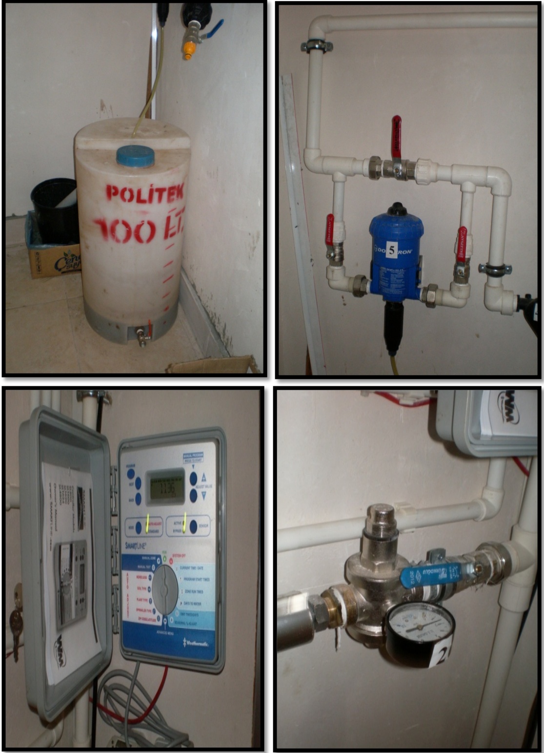
Şekil 4.26: Körfez Belediyesi İç Mekan Dikey Bahçe Uygulamasında otomatik sulama ve gübreleme sistemi yukarıdan aşağıya soldan sağa sırayla; gübre tankı, dozatron, timer, basınç regülatörü, filtre, sisleme pompası, selenoid vanalar, kireç iyonozeri.
