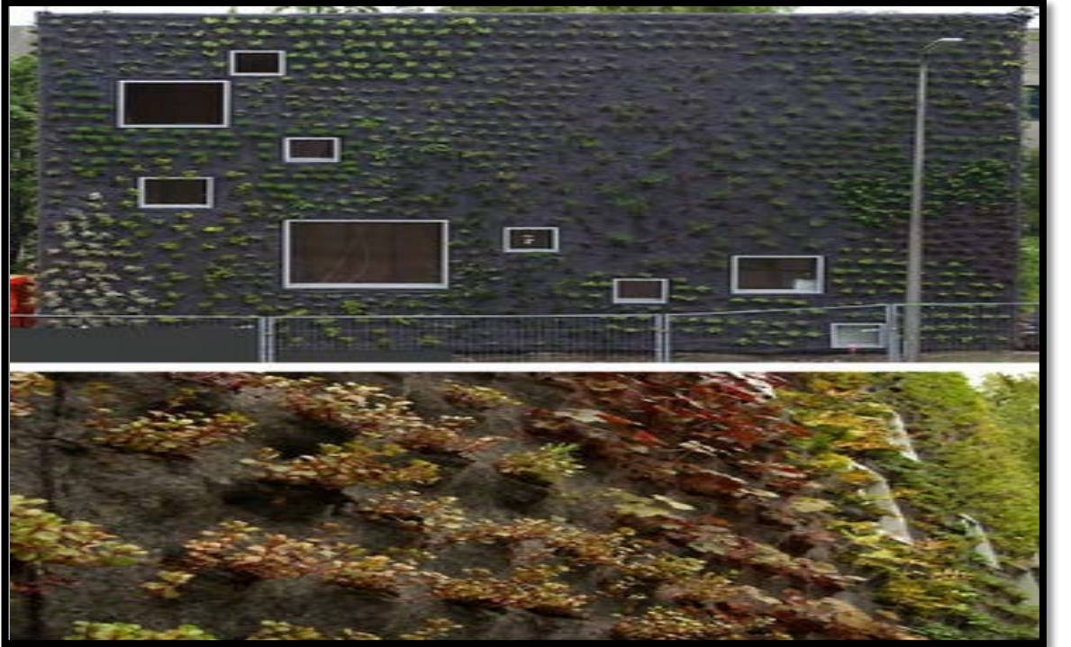
Şekil 3.26: Blackbox Köşkü Dış Mekan Dikey Bahçe Uygulamasında bitkiler doğal hindistan cevizi lifinden cepler içerisinde yetişmektedir 42 .
