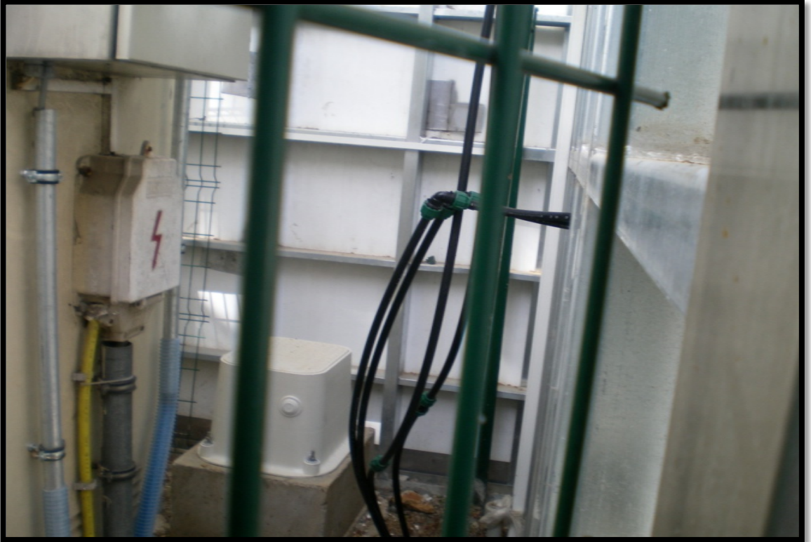
Şekil 3.76: Göztepe 60. Yıl Parkı Bağdat Caddesi Girişinde Dış Mekan Dikey Bahçe Uygulamasında 1. kat geotekstil keçe katmanına belirli aralıklarla döşenen sulama boruları (üstte) ve aynı dikey bahçenin sulama sistemi ağı (altta).
