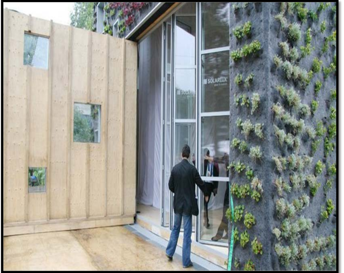
Şekil 3.24: Düşük teknolojide tesis edilen Blackbox Köşkü Dış Mekan Dikey Bahçe Uygulaması 42 .
