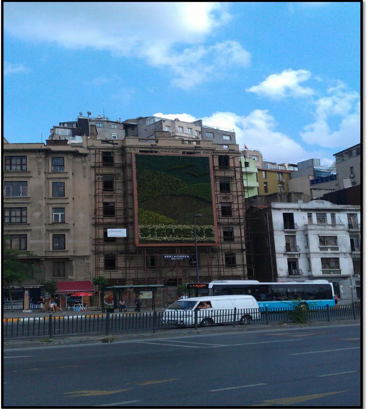
Şekil 3.93: Tarlabası Dış Mekan Dikey Bahçe Uygulaması.
