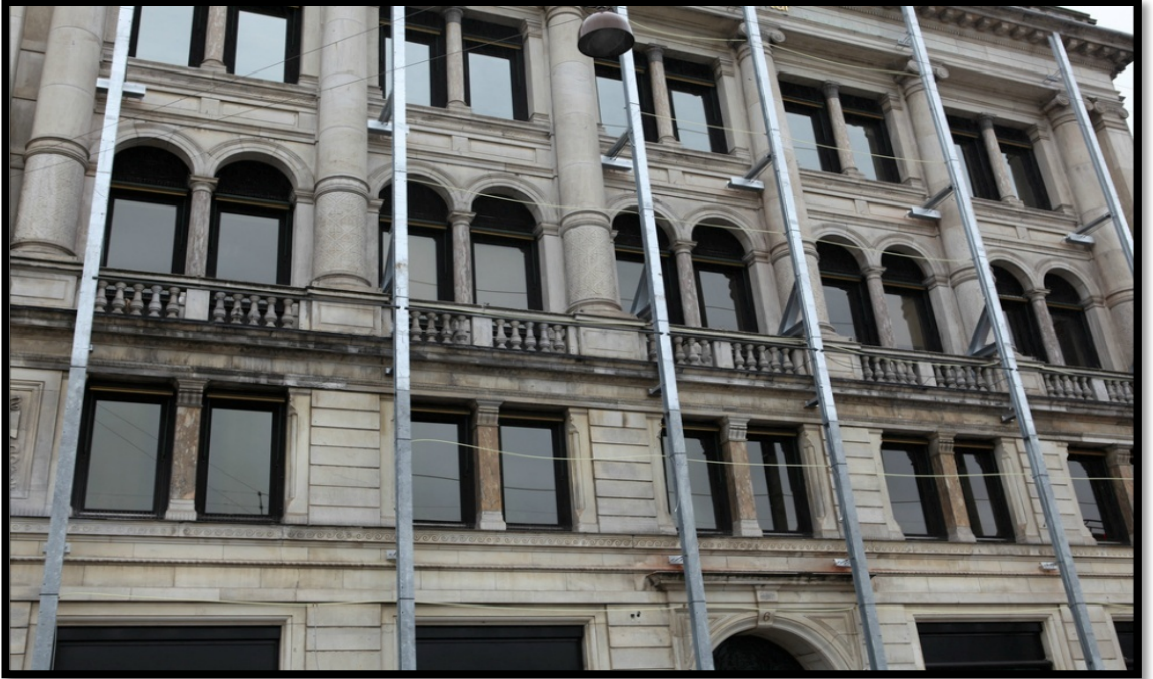
Şekil 3.7: Danimarka'da Kopenhag'daki Avrupa Çevre Ajansı Binasının Dış Mekan Dikey Bahçe Uygulamasında çelik konstrüksiyon taşıyıcı malzemelerin kullanılması 33 .
