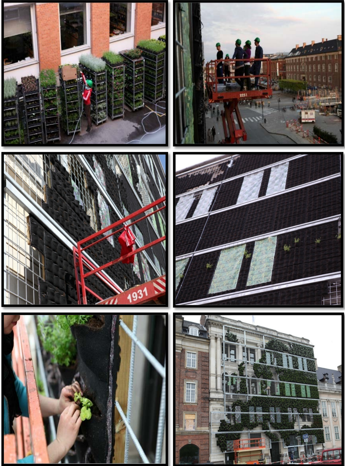
Şekil 3.10: Danimarka'da Kopenhag'daki Avrupa Çevre Ajansı Binasının Dış Mekan Dikey Bahçe Uygulamasında keçe tabakalarının üzerinin bitkilendirilmesinin aşama aşama fotoğrafları 33 .
