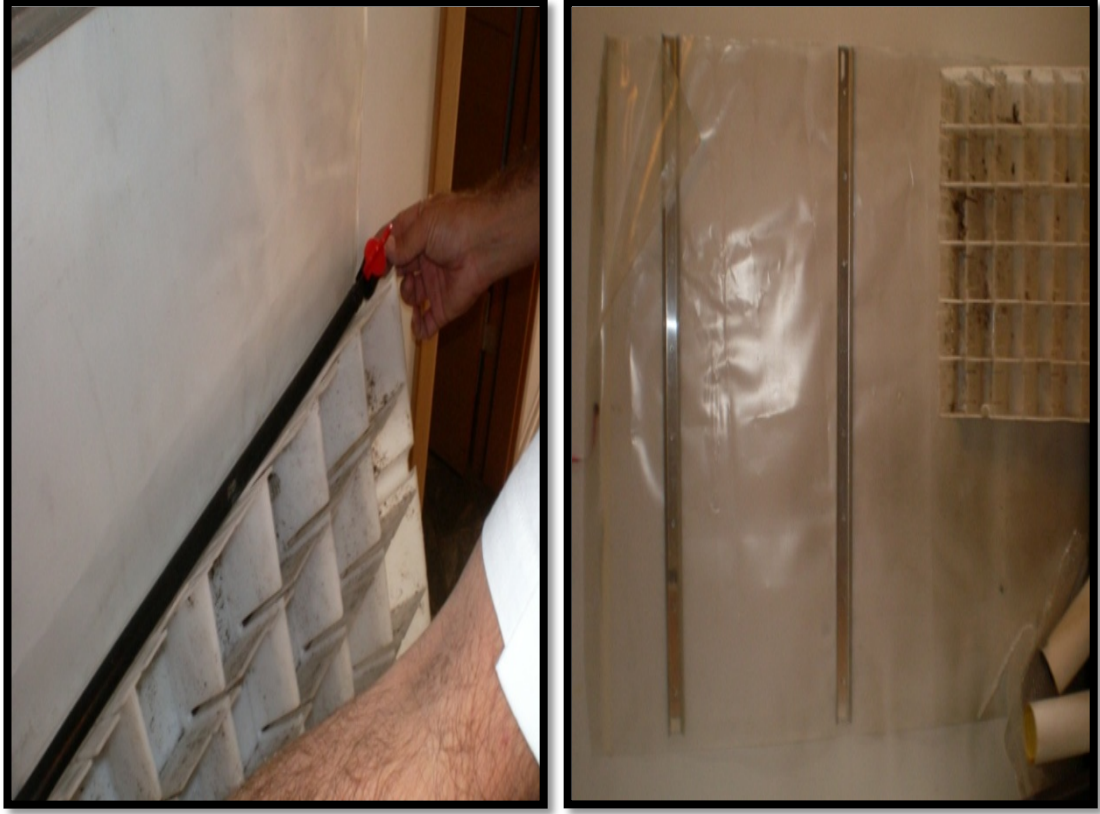
Şekil 2.66 (devam): Modüler yaşayan duvar sistemlerinde plastik çiçek panellerinin görünüşleri, paneller monte edilen sulama boruları, plastik çiçek panelleri taşıyan sistem.
