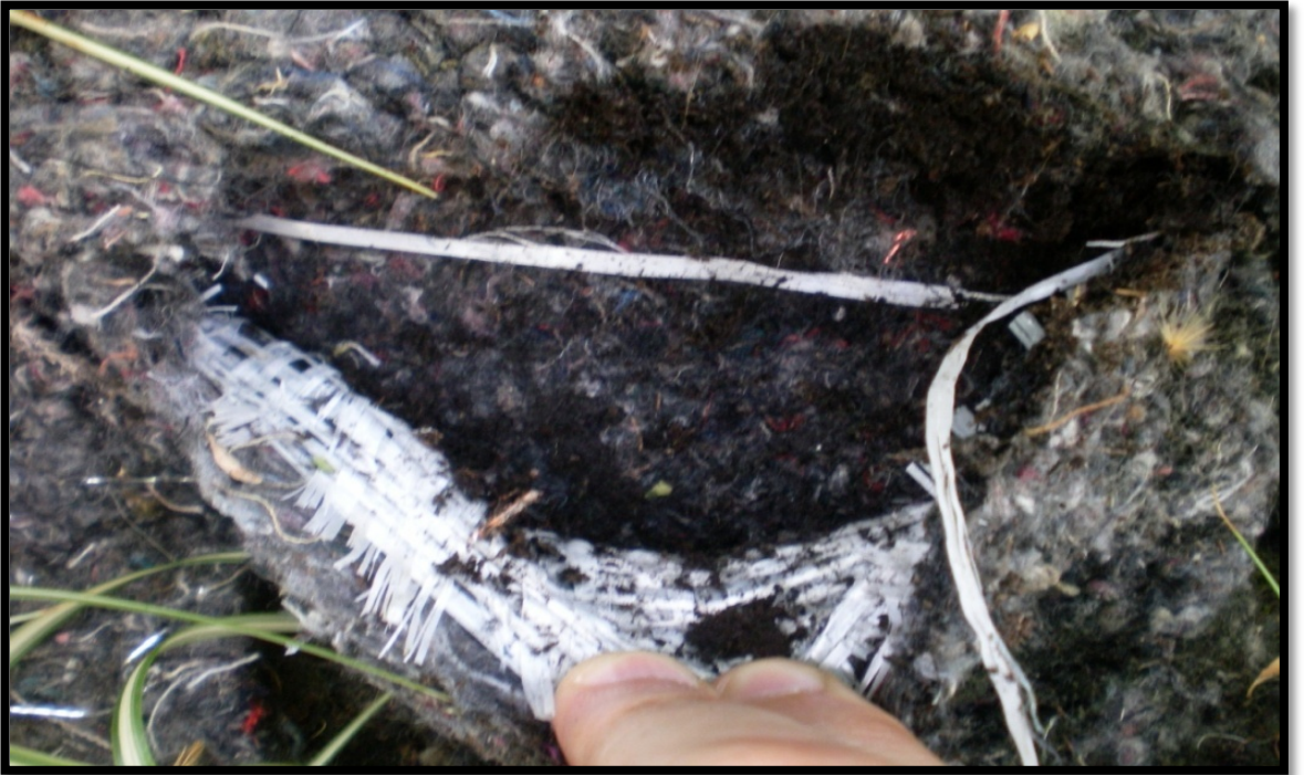
Şekil 3.75: Göztepe 60. Yıl Parkı Bağdat Caddesi Girişinde Dış Mekan Dikey Bahçe Uygulamasında bitkilerin yetiştirme ortamını oluşturan 2. kat jeotekstil keçe katmanındaki bitkinin konumlandırıldığı cepler.
