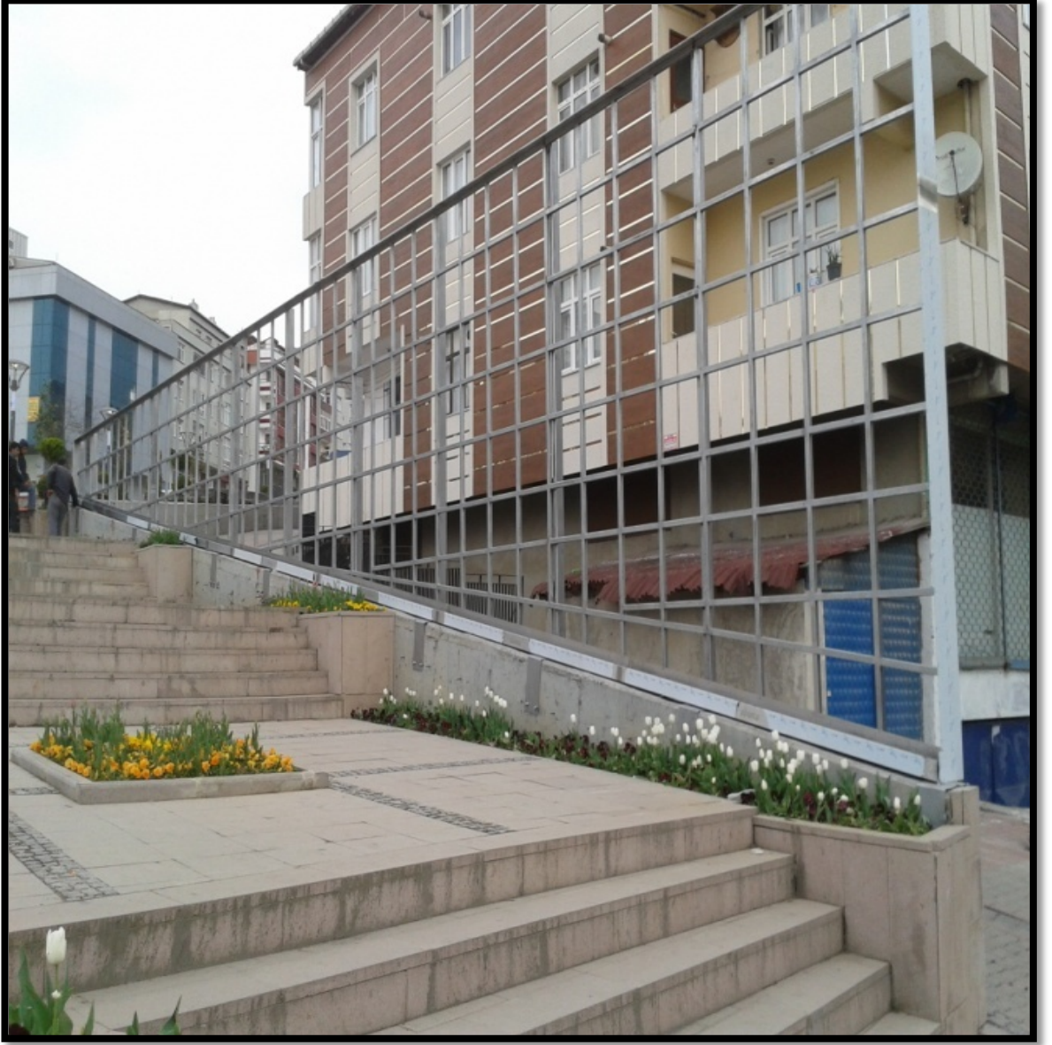
Şekil 4.13: Sultangazi Belediyesi Adem Yavuz Meydan Parkı Dış Mekan Dikey Bahçe Uygulamasında ilk olarak taşıyıcı profiller oluşturulmuştur.
