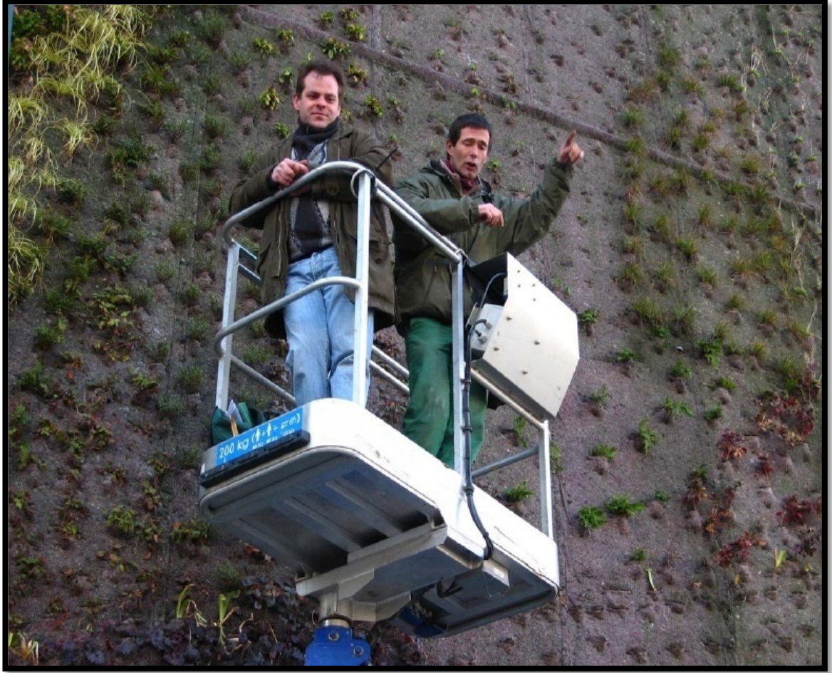
Şekil 4.34: Dikey bahçelerde bitkilerin adaptasyon sürecinin gözlenmesi ve büyüme ortamını oluşturan jeotekstil keçe örtüsünün nem kontrolü (Blanc, 2010).
