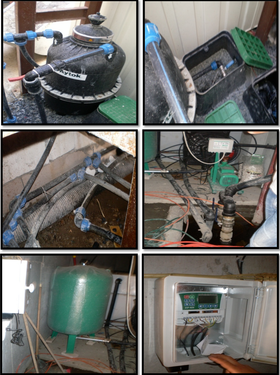
Şekil 3.86: Beşiktaş Shangri-La Bosphorus Otel Dış Mekan Dikey Bahçe Uygulaması'nın sulama Sistemi sırayla; gübre tankı, selenoid vanalar, sulama boruları, hidrofor, timer cihazı.
