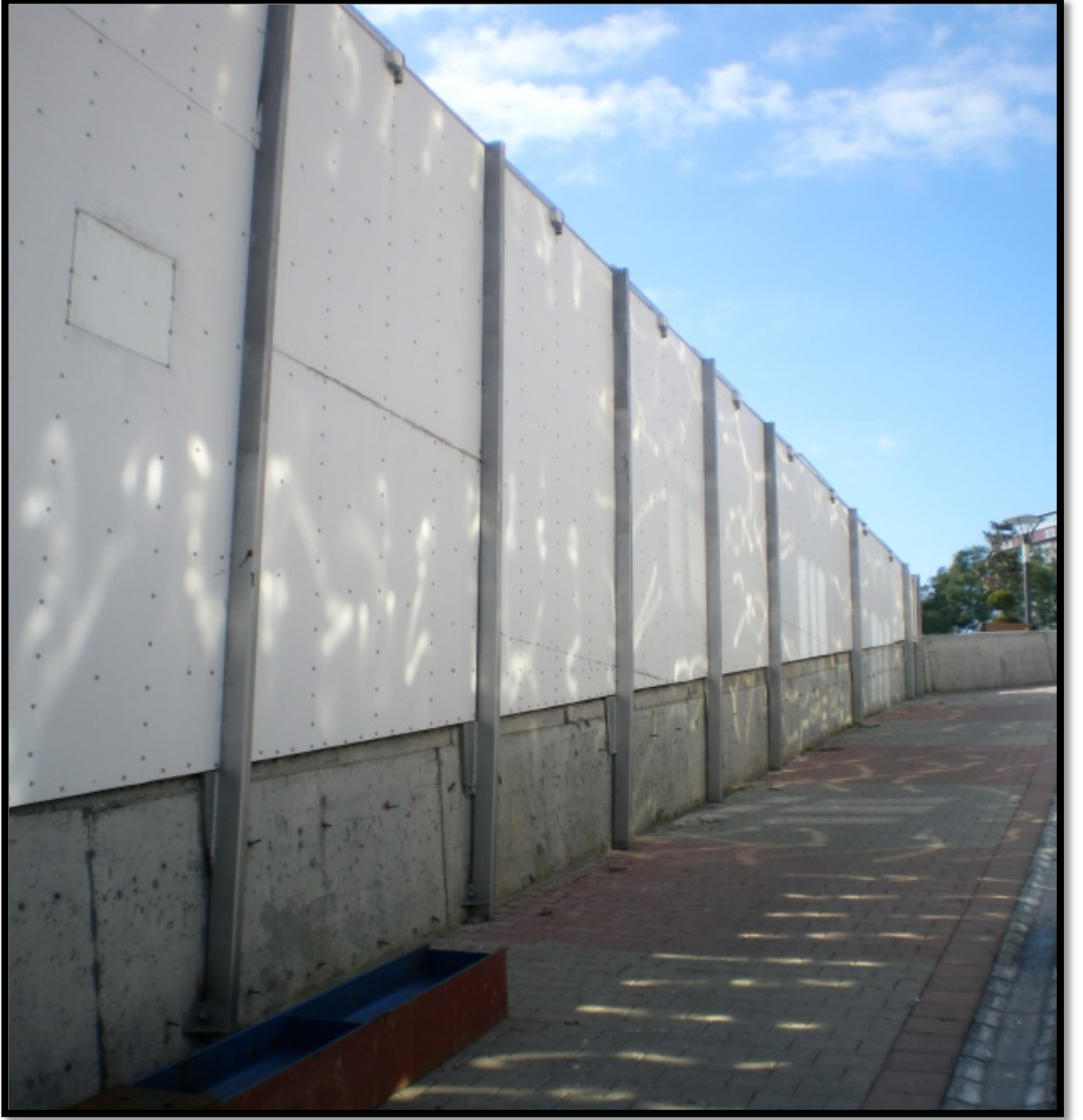
Şekil 4.15: Sultangazi Belediyesi Adem Yavuz Meydan Parkı Dış Mekan Dikey Bahçe Uygulamasında taşıyıcı malzemenin üzerine PVC panellerin vidalarla tutturulması.
