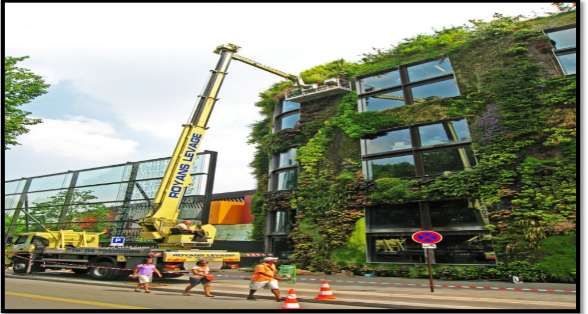
Şekil 3.16: Quai Branly Müzesi Dış Mekan Dikey Bahçe Uygulamasında alt kısımda yer alan su toplama kanalı (üstte) 35 , Quai Branly Müzesi Dış Mekan Dikey Bahçe Uygulamasının düzenli olarak yapılan bakımından bir görüntü (altta) 34 .
