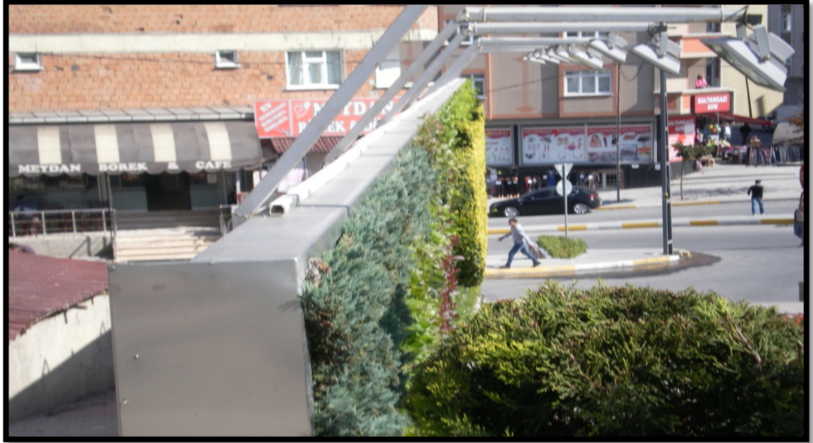
Şekil 4.20: Sultangazi Belediyesi Adem Yavuz Meydan Parkı Dış Mekan Dikey Bahçe Uygulamasında üst ve her iki yanında kenarlardan su akışını yönlendirme amaçlı yönlendirici kanallar mevcuttur.
