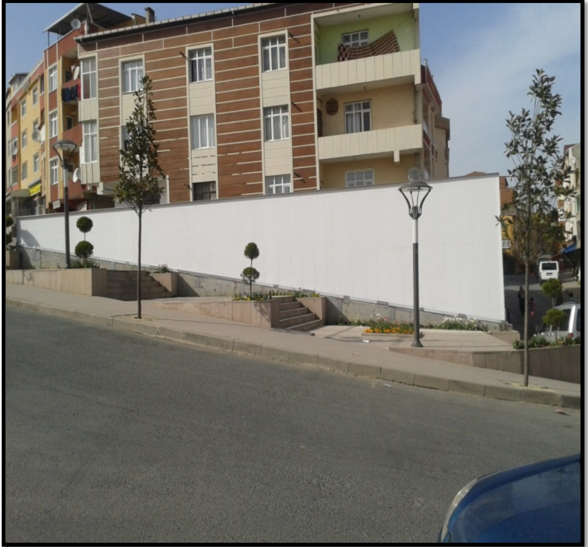
Şekil 4.14: Sultangazi Belediyesi Adem Yavuz Meydan Parkı Dış Mekan Dikey Bahçe Uygulamasında taşıyıcı sistemi üzerine PVC Panelin montajı.
