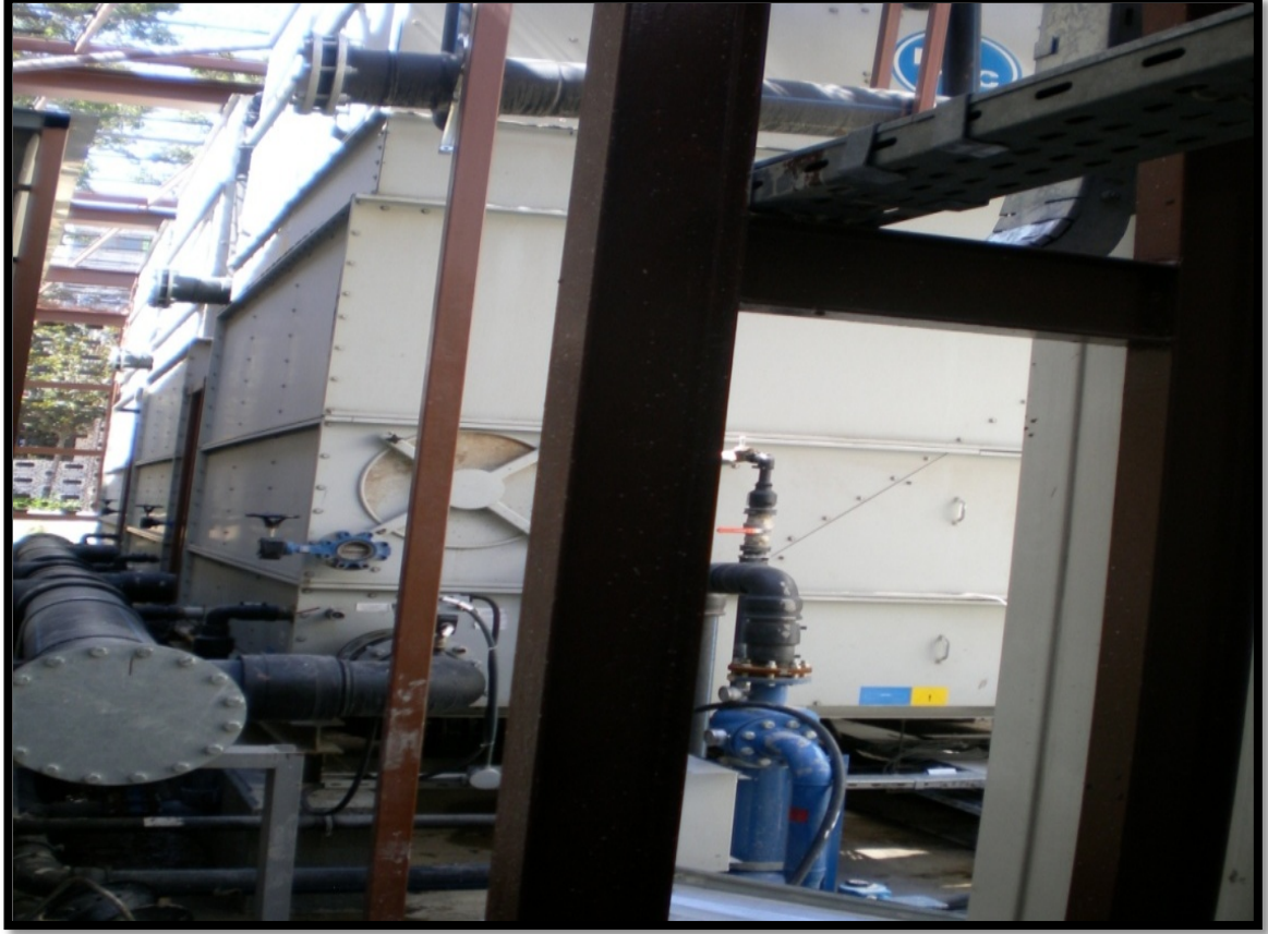
Şekil 3.81: Beşiktaş Shangri-La Bosphorus Otel Dış Mekan Dikey Bahçe Uygulamasının arkasındaki görüntü.
