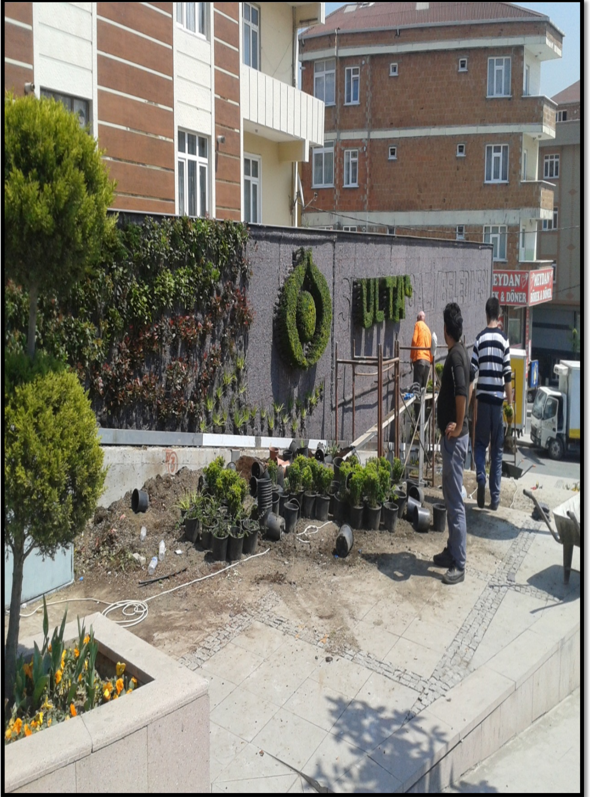
Şekil 4.35: Sultangazi Belediyesi Adem Yavuz Meydan Parkı Dış Mekan Dikey Bahçe Uygulamasında bitkilendirmenin gerçekleştirilmesi.
