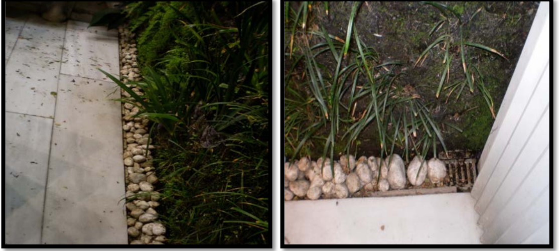
Şekil 3.47: Galata Art House Eczacıbaşı Malikanesi İç Mekan Dikey Bahçe Uygulamasında suyun drene edilmesi.
