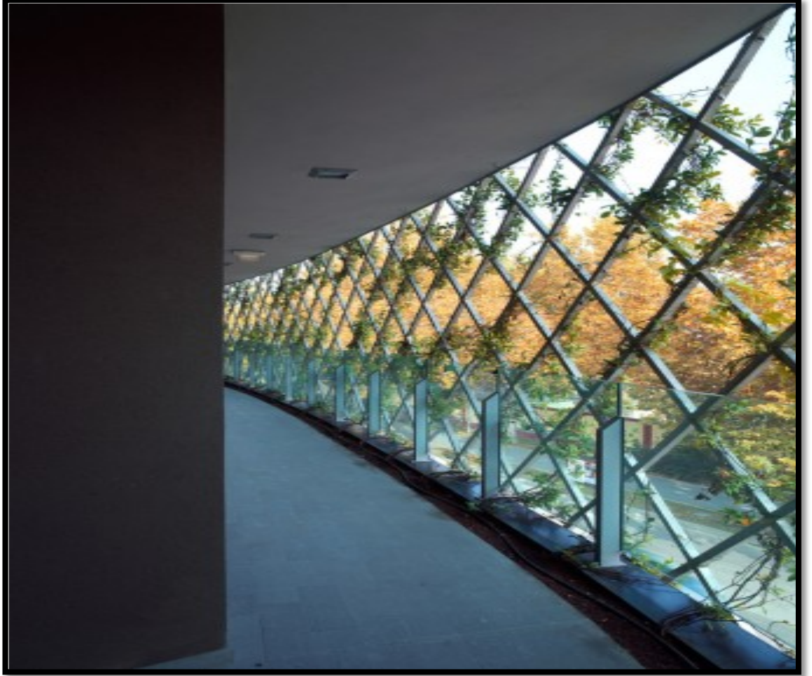
Şekil 2.27: Ex Ducati Kafes Sistem Yeşil Cephe Uygulaması damlama sulama sistemi (Lambertini, 2007).
