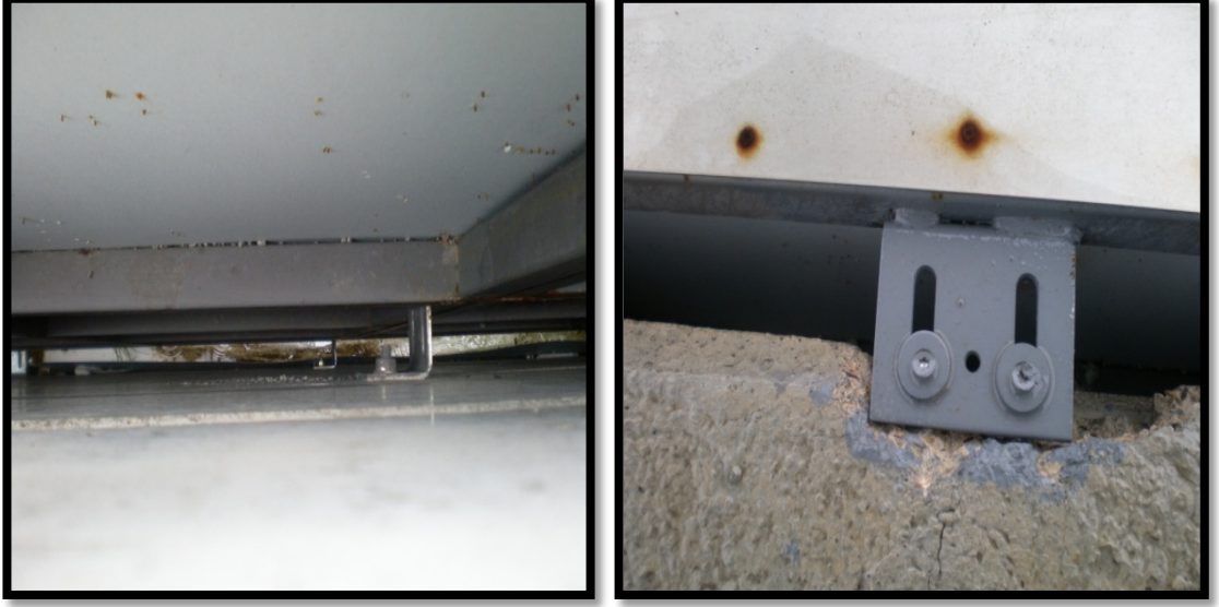
Şekil 3.64: Gebze Belediyesi Kent Meydan Parkı Dış Mekan Dikey Bahçe Uygulaması Polivinil Klorür (PVC) Panel ve taşıyıcı profil.
