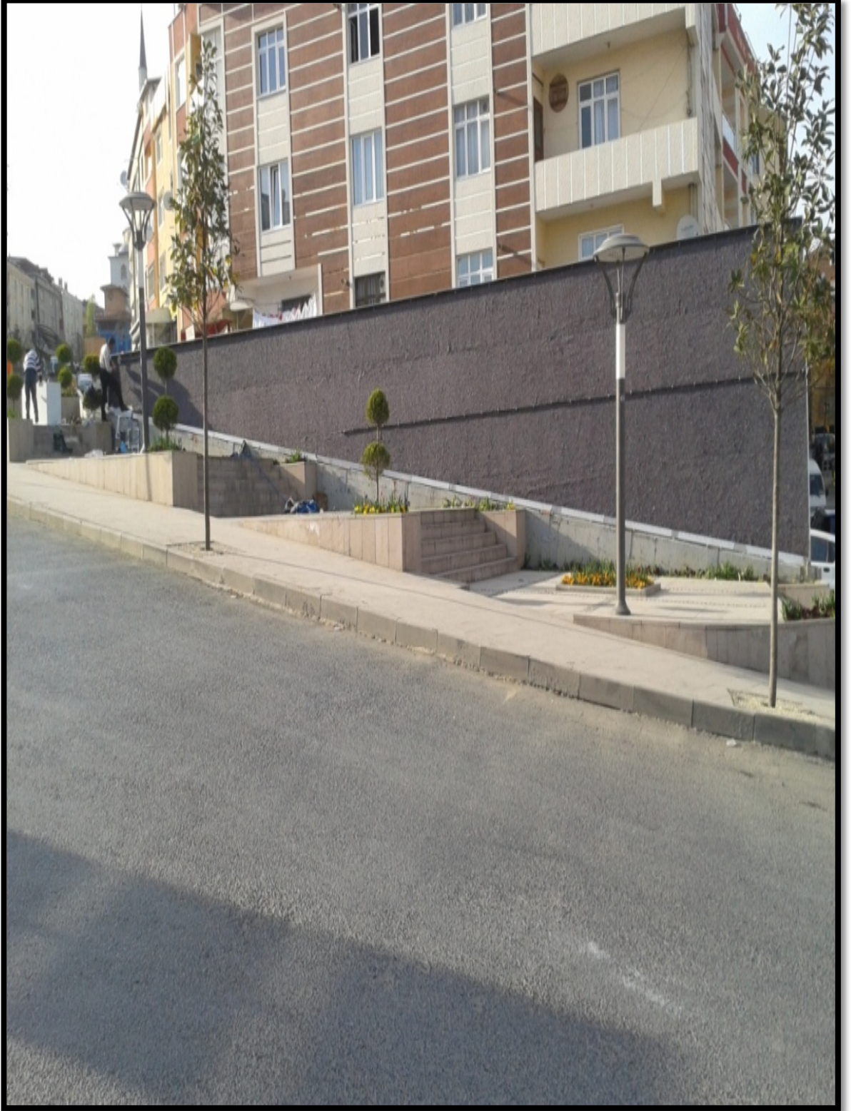
Şekil 4.17: Sultangazi Belediyesi Adem Yavuz Meydan Parkı Dış Mekan Dikey Bahçe Uygulamasında PVC panellerin üzerine 1. kat keçe katmanının zimbalarla tutturulması.
