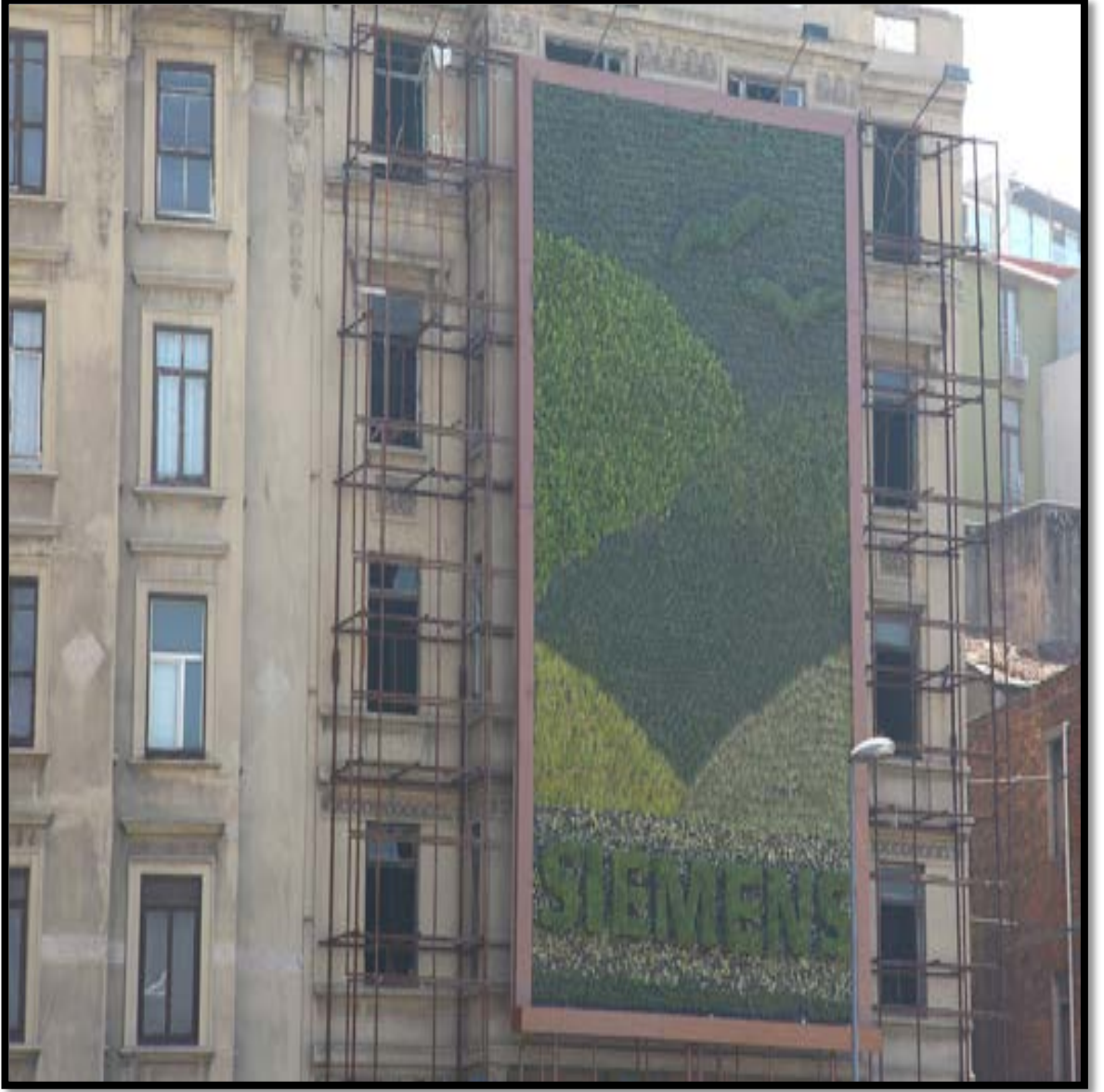
Şekil 3.99: Tarlabası Dış Mekan Dikey Bahçe Uygulamasında bitki dikiminin tamamlanması 13.04.2012 50 .
