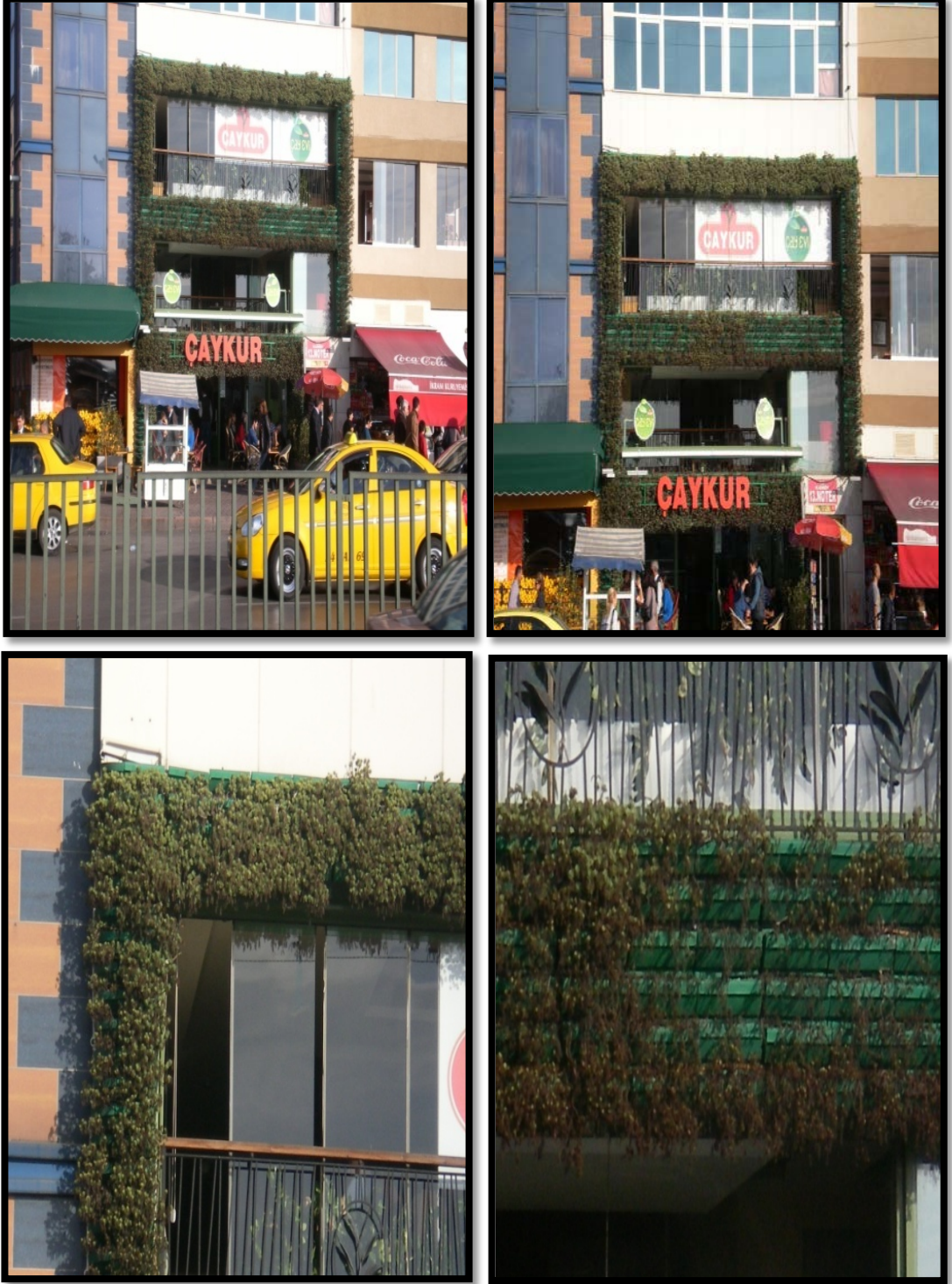
Şekil 2.83: Kadıköy'de Çaykur Çayevi Modüler Yaşayan Duvar Sistemi.
