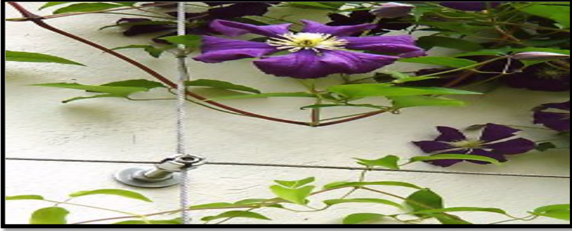
Şekil 2.33: Kablo ve Tel Örgü Ağ Sistemi Yeşil Cephelerde ASS Sistem (Yapı Stili Halat Sistemi) 12 .
