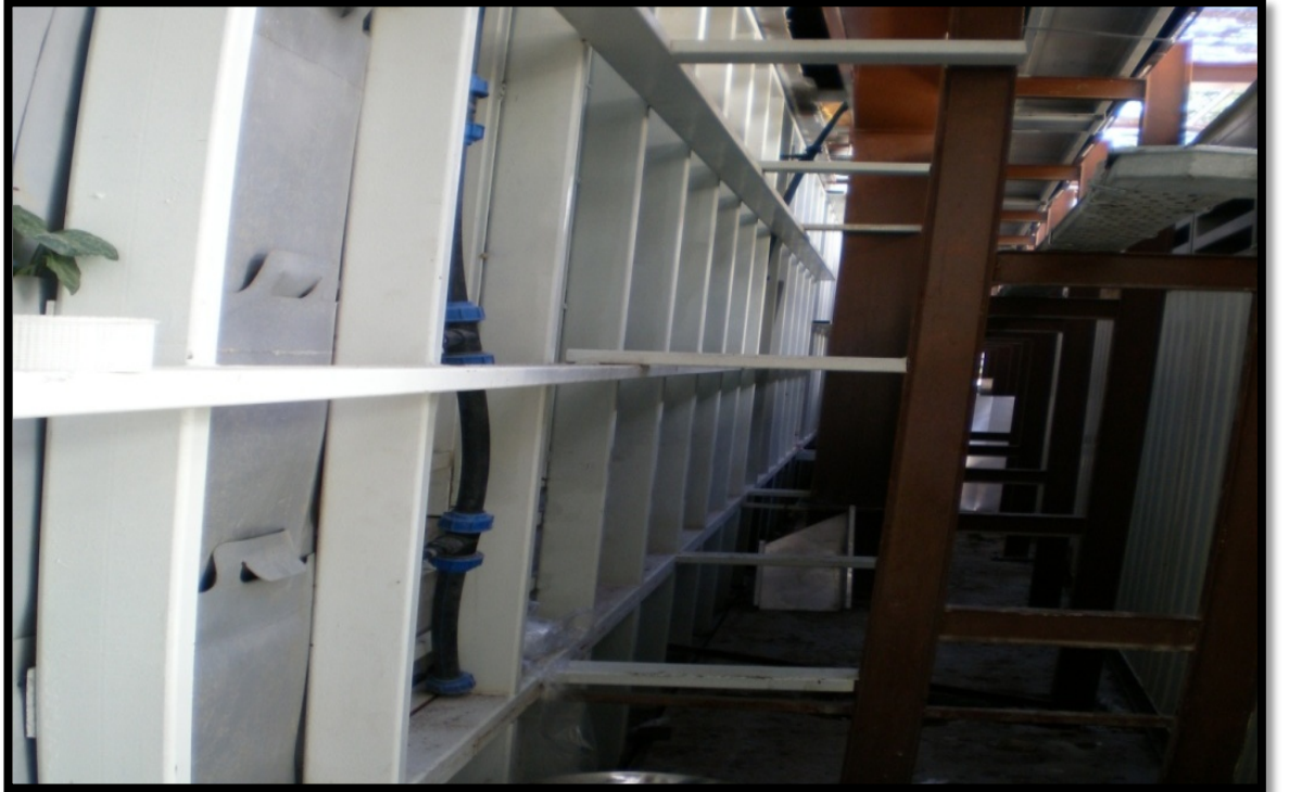
Şekil 3.82: Beşiktaş Shangri-La Bosphorus Otel Dış Mekan Dikey Bahçe Uygulaması'ndaki paslanmaz çelik karkas sistem.
