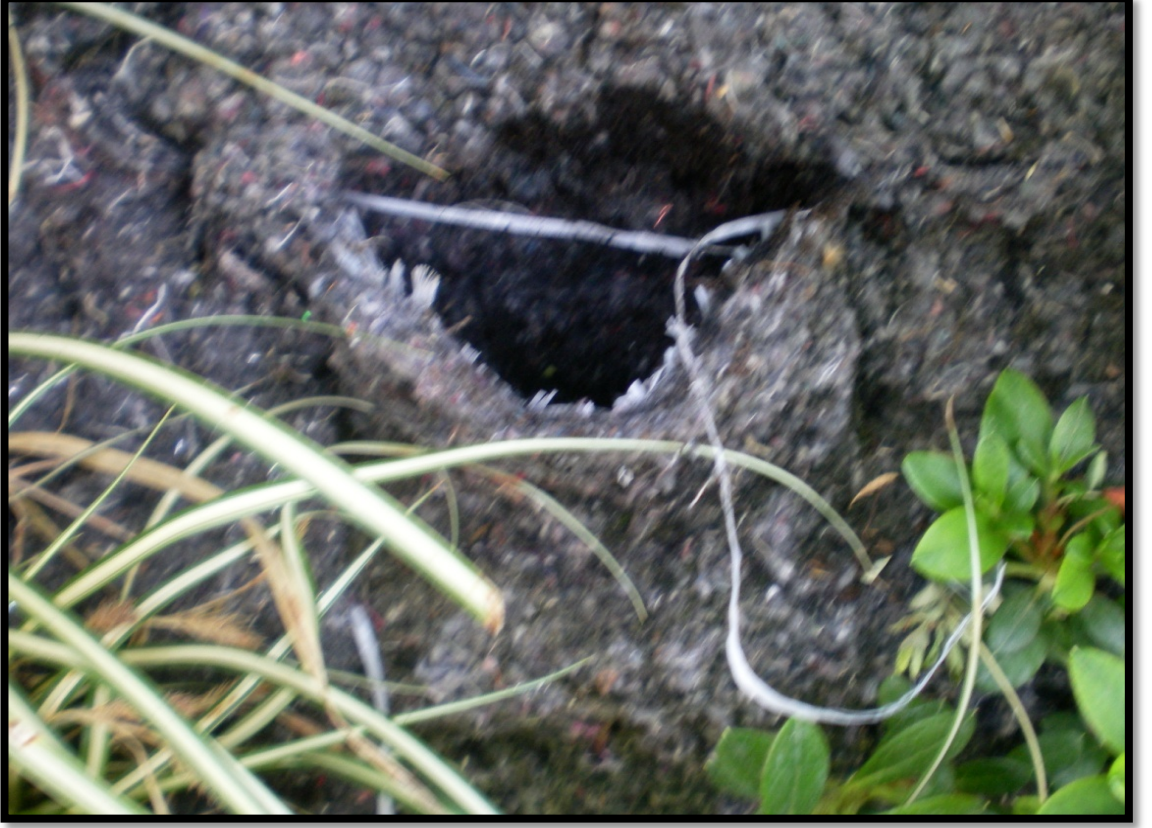
Şekil 4.75: Göztepe 60. Yıl Parkı Bağdat Caddesine bakan Dış Mekan Dikey Bahçe Uygulamasında vandalizm sonucu bazı bitki kayıpları yaşanmaktadır kaybolan bitkilerin yerine yenisi dikilmiştir.
