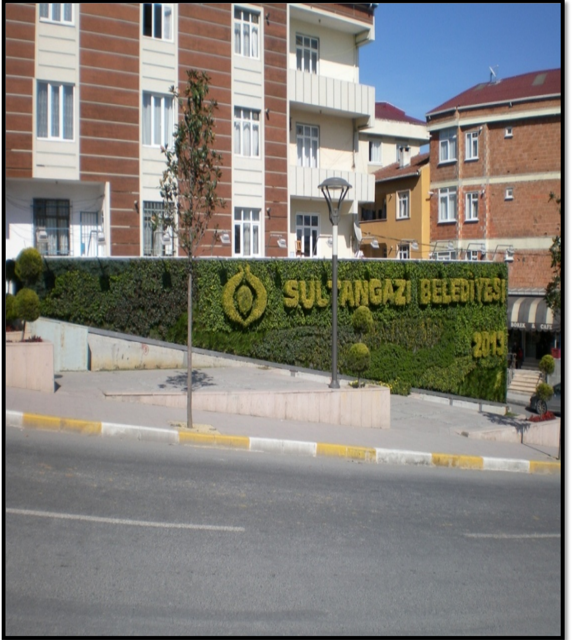
Şekil 3.52: Sultangazi Belediyesi Adem Yavuz Meydan Parkı Dış Mekan Dikey Bahçenin bitmiş hali (07.10.2013).
