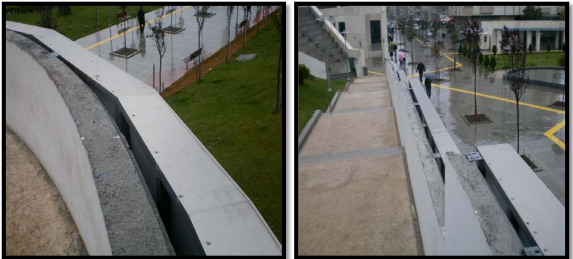
Şekil 3.65: Gebze Belediyesi Kent Meydan Parkı Dış Mekan Dikey Bahçe Uygulaması mevcut duvar ve metal çerçeve (yönlendirici kanal).
