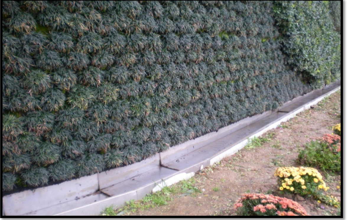
Şekil 3.66: Gebze Belediyesi Kent Meydan Parkı Dış Mekan Dikey Bahçe Uygulaması su toplama kanalı.
