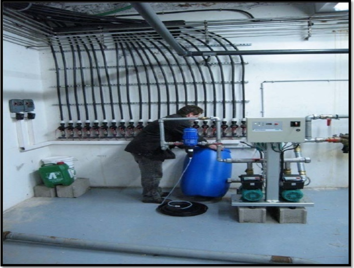
Şekil 4.33: Dikey bahçeler otomatik sulama ve gübreleme sistemlerinin, sisleme sisteminin bakımı (Blanc, 2010).
