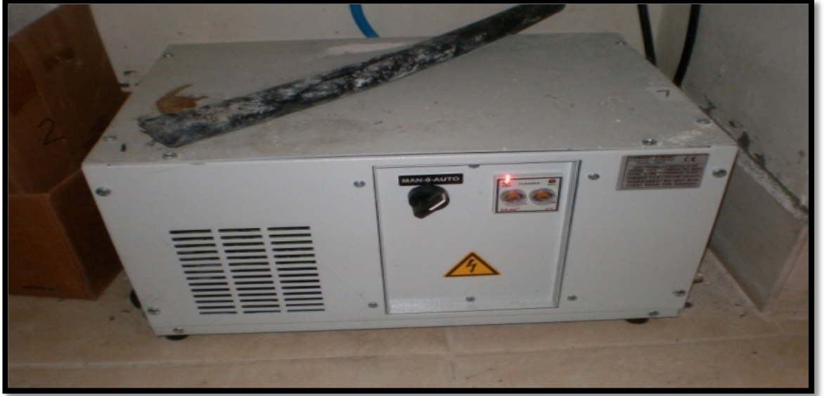
Şekil 4.27: Körfez Belediyesi İç Mekan Dikey Bahçe Uygulaması sisleme sisteminde sisleme pompası.
