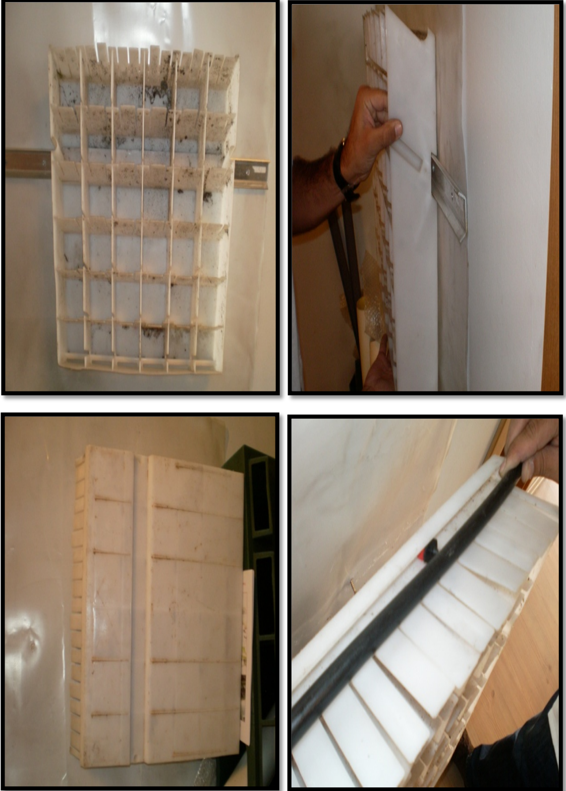
Şekil 2.66: Modüler yaşayan duvar sistemlerinde plastik çiçek panellerinin görünüşleri, paneller monte edilen sulama boruları, plastik çiçek panelleri taşıyan sistem.
