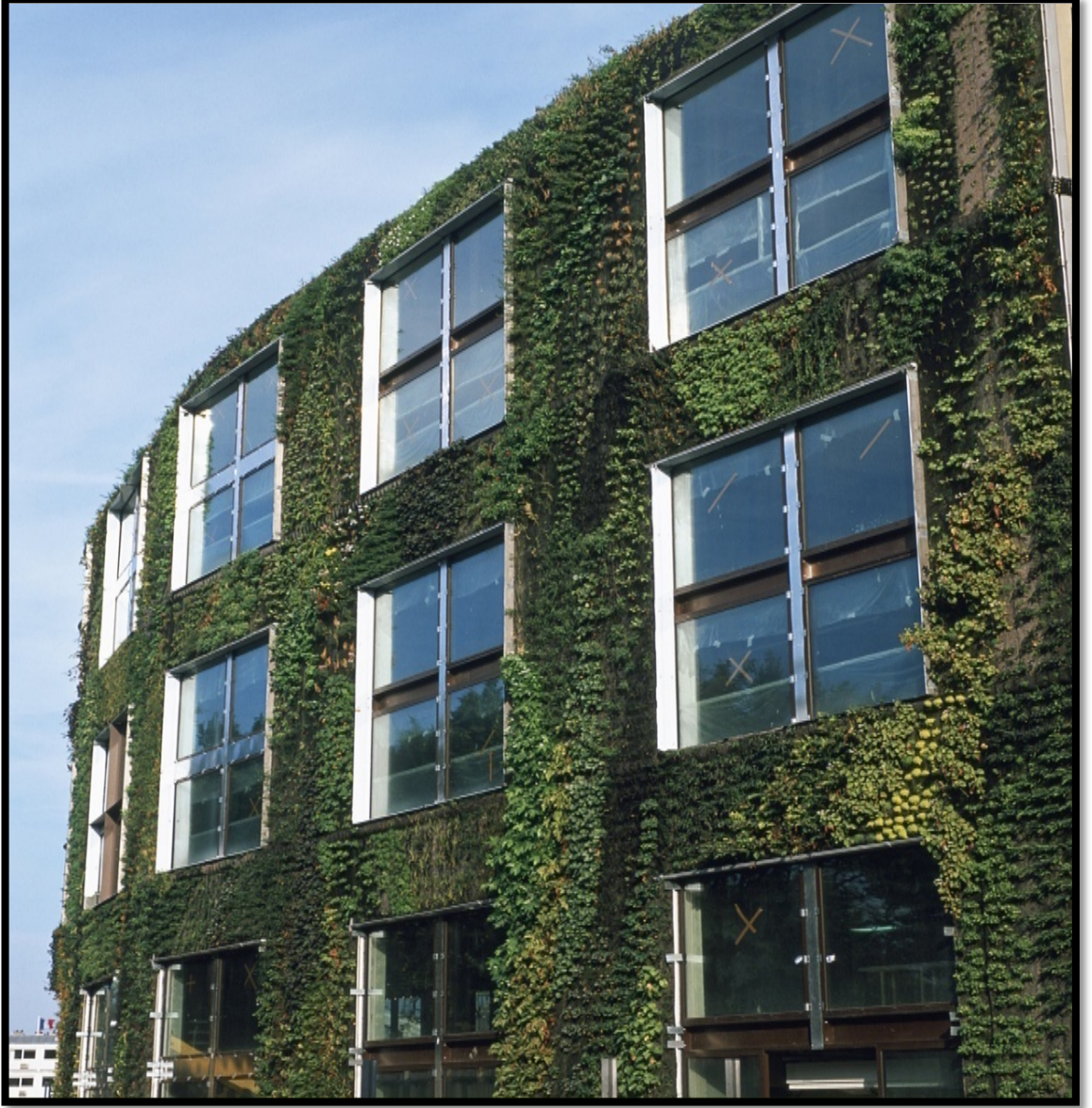
Şekil 4.38: Quai Branly Müzesi Dış Mekan Dikey Bahçe Uygulamasının bitkilendirilmesi tamamlandıktan 2 ay sonrası Eylül 2005 59 .
