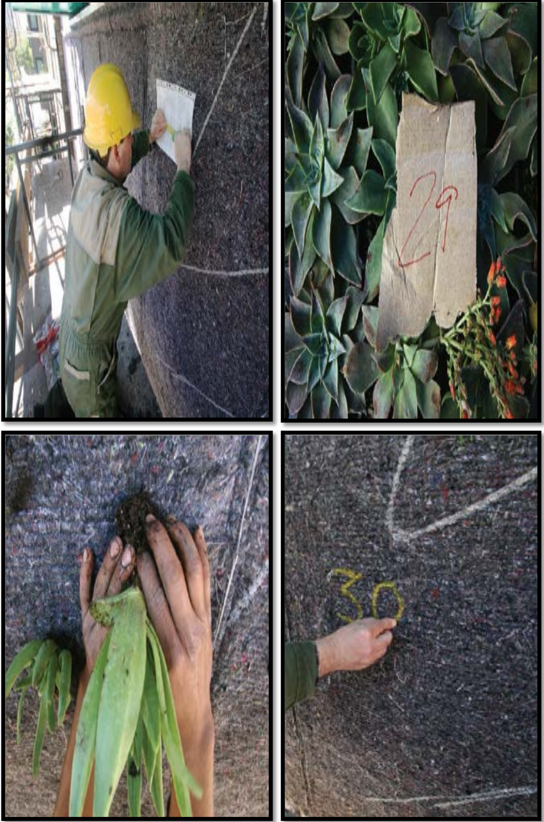
Şekil 3.39: San Fransisco Drew Okulu Dış Mekan Dikey Bahçe Uygulamasında bitkilerin keçe katmanına dikimi (Furio, 2011).
