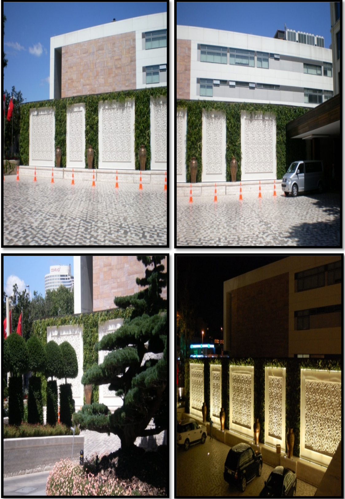
Şekil 3.87: Shangri-La Bosphorus Otel Dış Mekan Dikey Bahçe Uygulamasından çeşitli görüşler.
