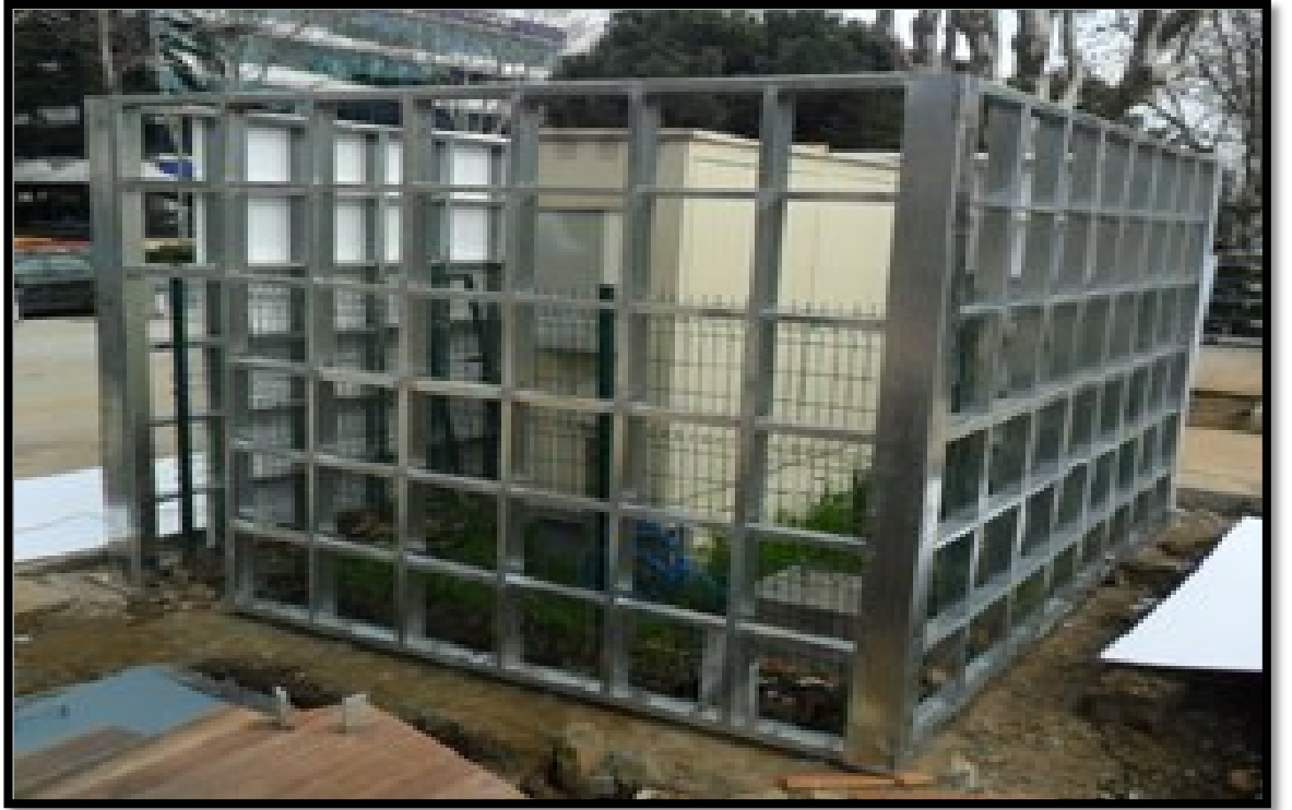
Şekil 3.69: Göztepe 60. Yıl Parkı Bağdat Caddesi Girişinde Dış Mekan Dikey Bahçenin tesisinden önce taşıyıcı profillerinin kurulumu 47 .
