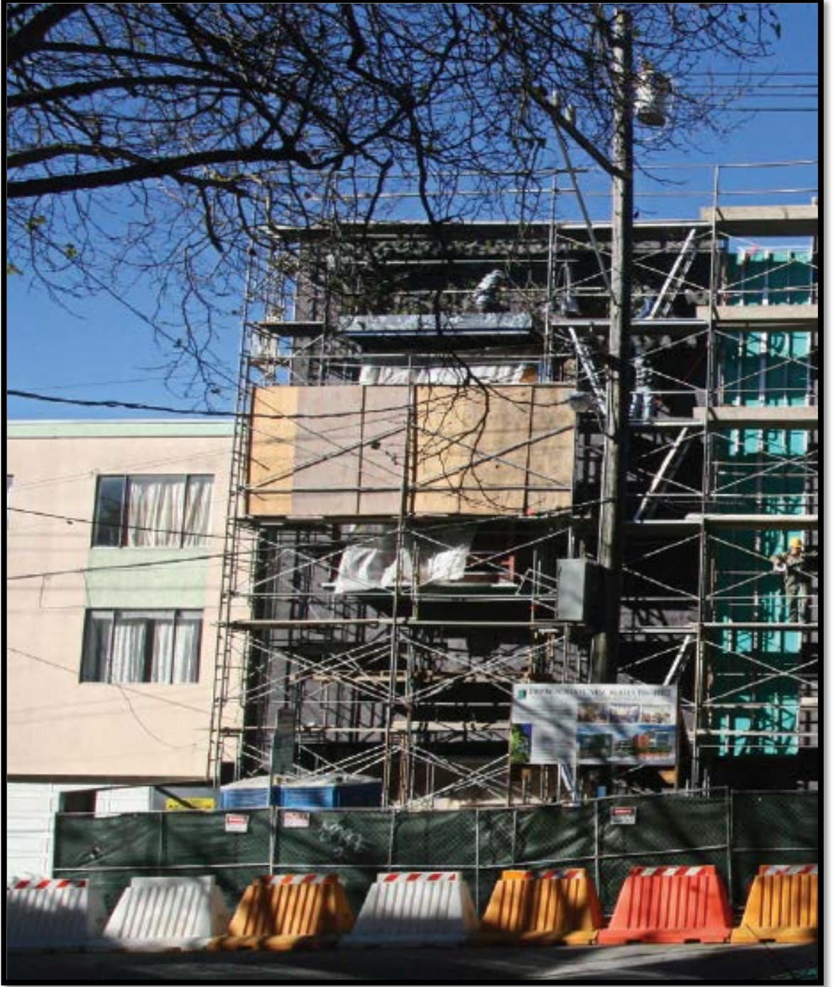
Şekil 3.38: San Fransisco Drew Okulu Dış Mekan Dikey Bahçe Uygulamasında taşıyıcı sistemin döşenmesi, PVC tabakaların taşıyıcı sisteme bağlanması ve keçe katmanlarının PVC tabakaya tutturulması (Furio, 2011).
