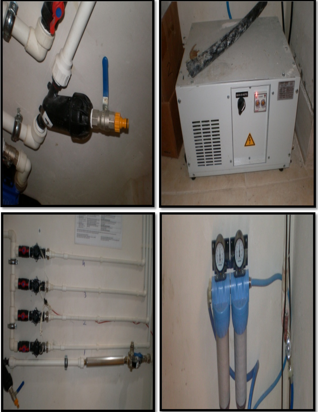
Şekil 4.26(devam): Körfez Belediyesi İç Mekan Dikey Bahçe Uygulamasında otomatik sulama ve gübreleme sistemi yukarıdan aşağıya soldan sağa sırayla; gübre tankı, dozatron, timer, basınç regülatörü, filtre, sisleme pompası, selenoid vanalar, kireç iyonozeri.
