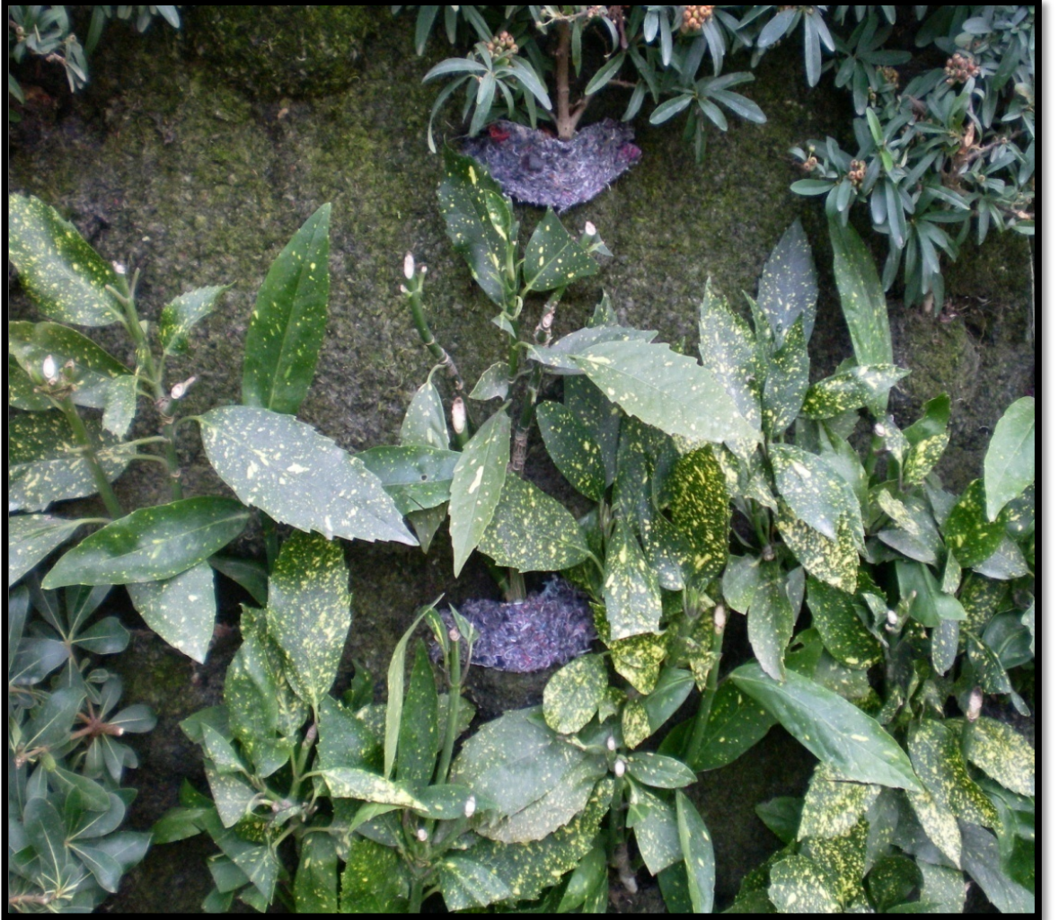
Şekil 4.74: Göztepe 60. Yıl Parkı Prof. Dr. Hulusi Behçet Caddesine bakan Dış Mekan Dikey Bahçe Uygulamasında deforme olan jeotekstil keçe örtüsünün yerine yenisi monte edilmiştir. Ayrıca bu dikey bahçede keçe örtüsü kayıpları kadar bitki türlerinde de kayıpların yaşandığı gözlenmektedir 15 Ekim 2013.
