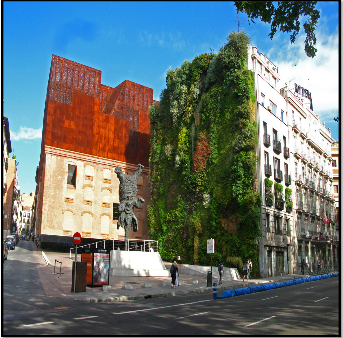
Şekil 3.19: Madrid Caixa Forum Dış Mekan Dikey Bahçe Uygulaması Mayıs 2010 34 .
