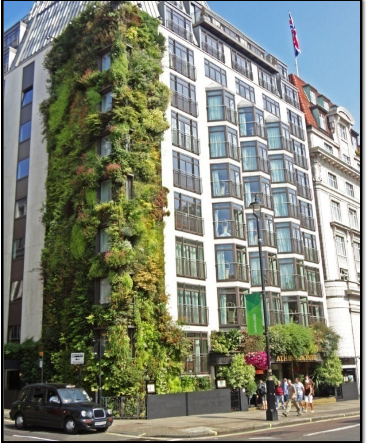
Şekil 3.23: Athenaeum Oteli Dış Mekan Dikey Bahçe Uygulaması Ağustos 2012 (üstte) 34 .
