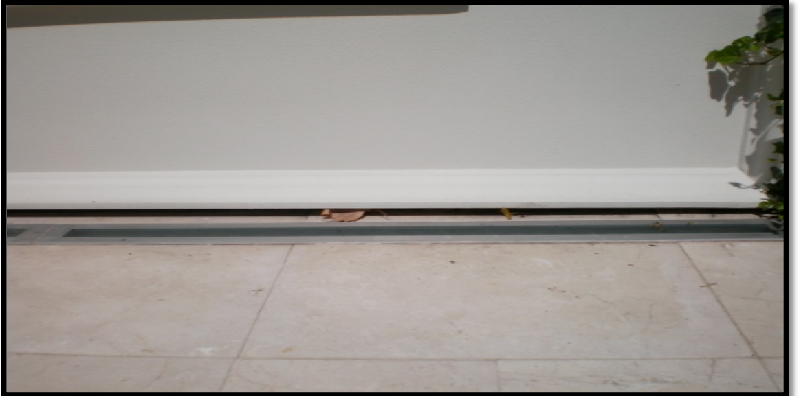
Şekil 3.85: Beşiktaş Shangri-La Bosphorus Otel Dış Mekan Dikey Bahçe Uygulaması'nın alt kısmındaki mermer yapı.
