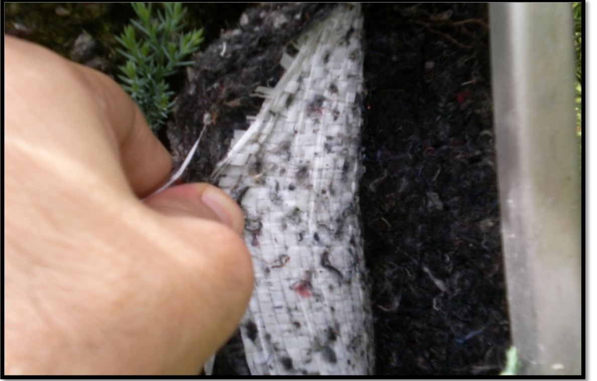
Şekil 3.74: Göztepe 60. Yıl Parkı Prof. Dr. Hulusi Behçet Caddesine bakan Dış Mekan Dikey Bahçe Uygulamasında jeotekstil keçe katmanları.
