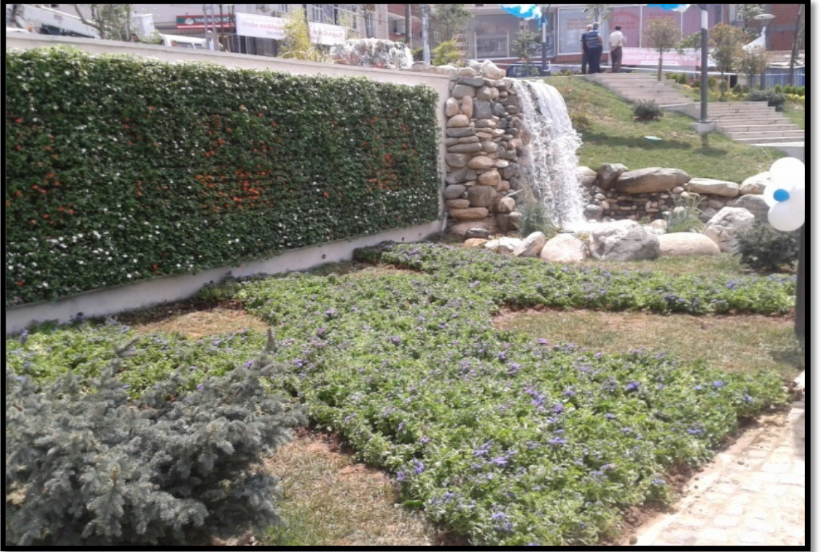
Şekil 2.81: Esenyurt'ta bir parkta Modüler Yaşayan Duvar Sistemi tesisi sonrası.
