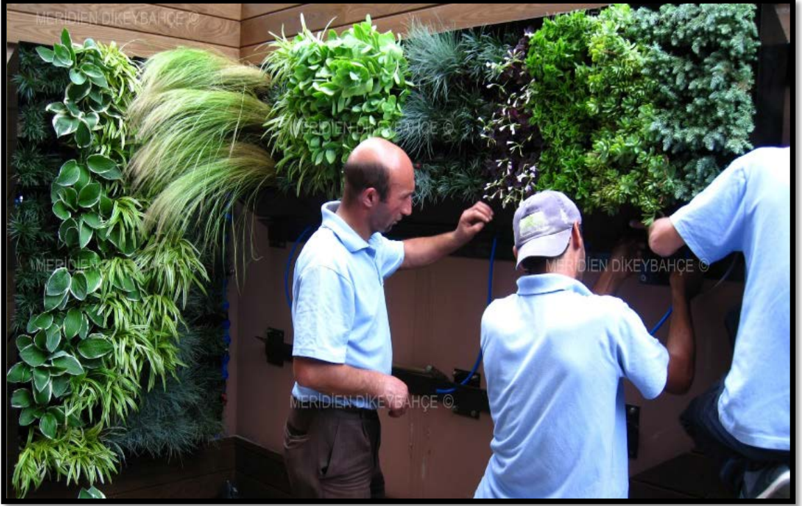
Şekil 2.47: Çubuklu Vadi Villa Bahçesi Modüler Yaşayan Duvar Sistemlerinde sulama borularının döşenmesi 13 .
