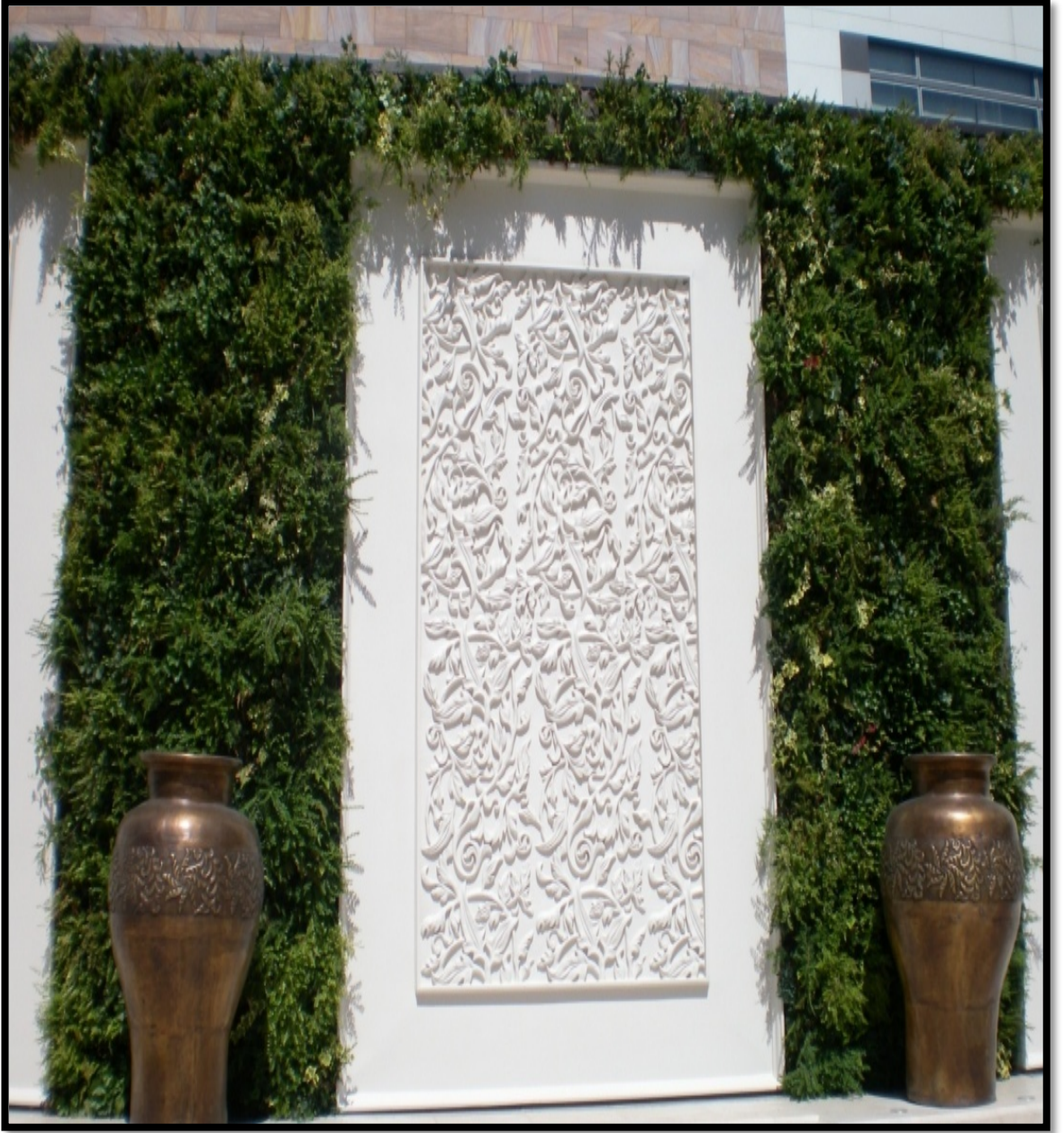
Şekil 3.83: Beşiktaş Shangri-La Bosphorus Otel Dış Mekan Dikey Bahçe Uygulaması'ndaki cam takviyeli polyster pano.
