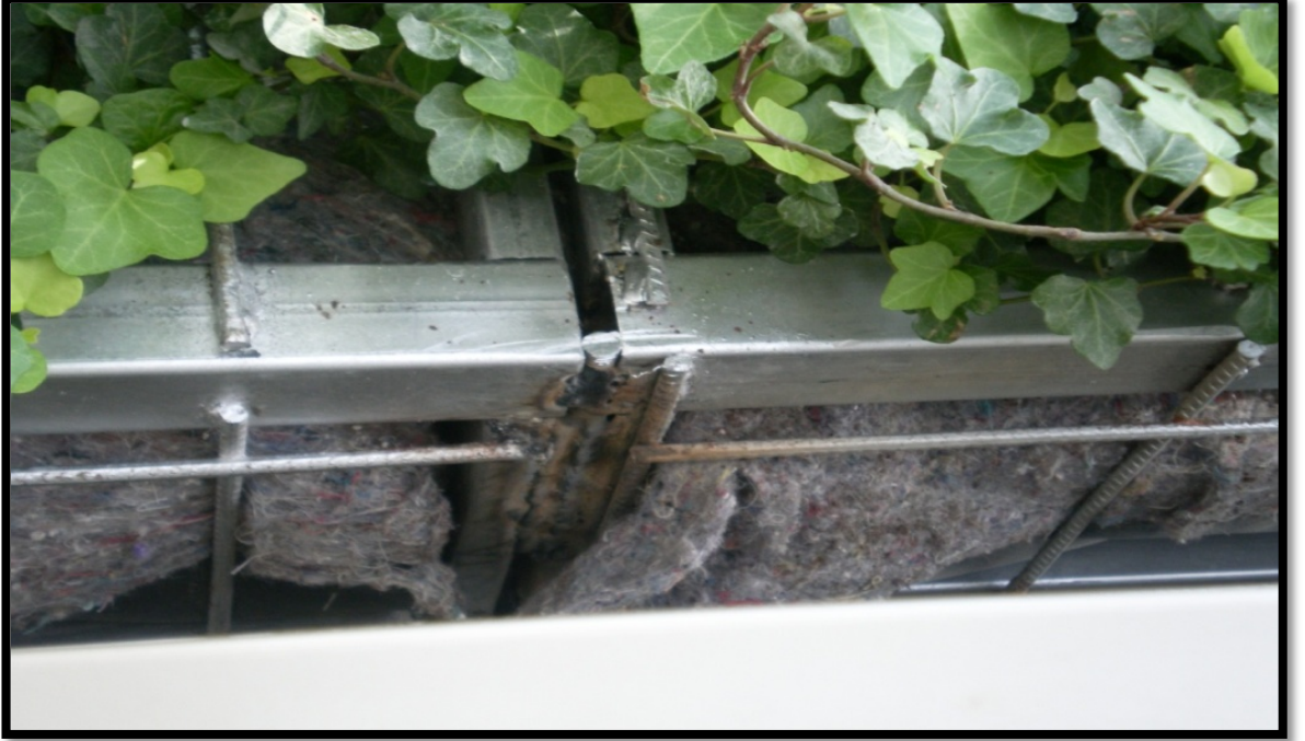
Şekil 3.90: Brandium Alish Veriş Merkezi İç Mekan Dikey Bahçe Uygulamasında kullanılan 15 cm X 15 cm X 6 mm ölçülerinde çeşan demiri, 40 X 40 demir profiller.
