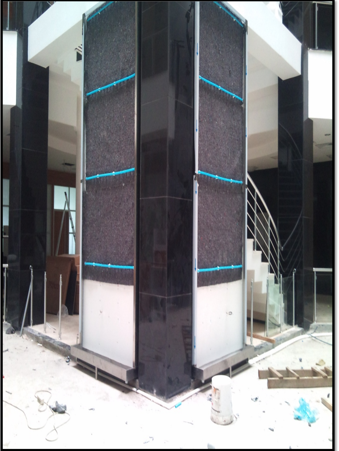
Şekil 3.54: Körfez Belediyesi İç Mekan Dikey Bahçe Uygulamasında 1. kat keçe katmanının döşenmesi ve üzerine 20 lik sulama borularının yerleştirilmesi, profillerin önüne duvarın suyla temasını önlemek amacıyla ve dikey bahçeye zemin oluşturması amacıyla su geçirmez PVC panellerin monte edilmesi, drenaj ve yönlendirici kanalların monte edilmesi.
