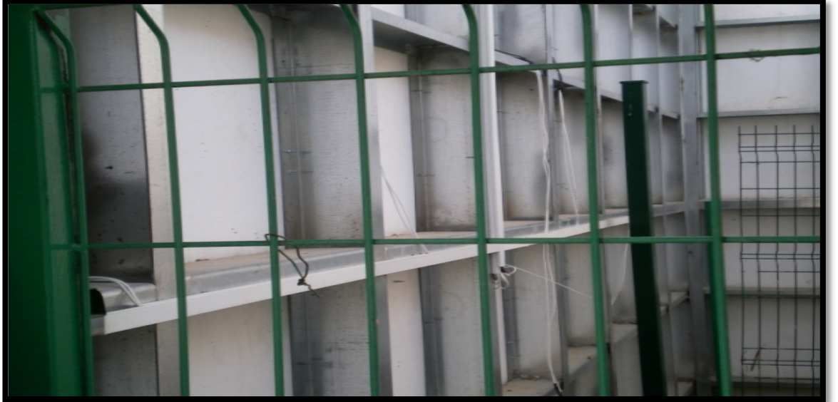
Şekil 3.73: Göztepe 60. Yıl Parkı Prof. Dr. Hulusi Behçet Caddesine bakan Dış Mekan Dikey Bahçe Uygulamasında (solda) ve Bağdat Caddesi Girişindeki Dış Mekan Dikey Bahçe Uygulamasında (sağda) metal taşıyıcı konstrüksiyon malzemeye su geçirmez Polivinil Klorür (PVC) paneller vidalar yardımıyla tutturulmuştur.
