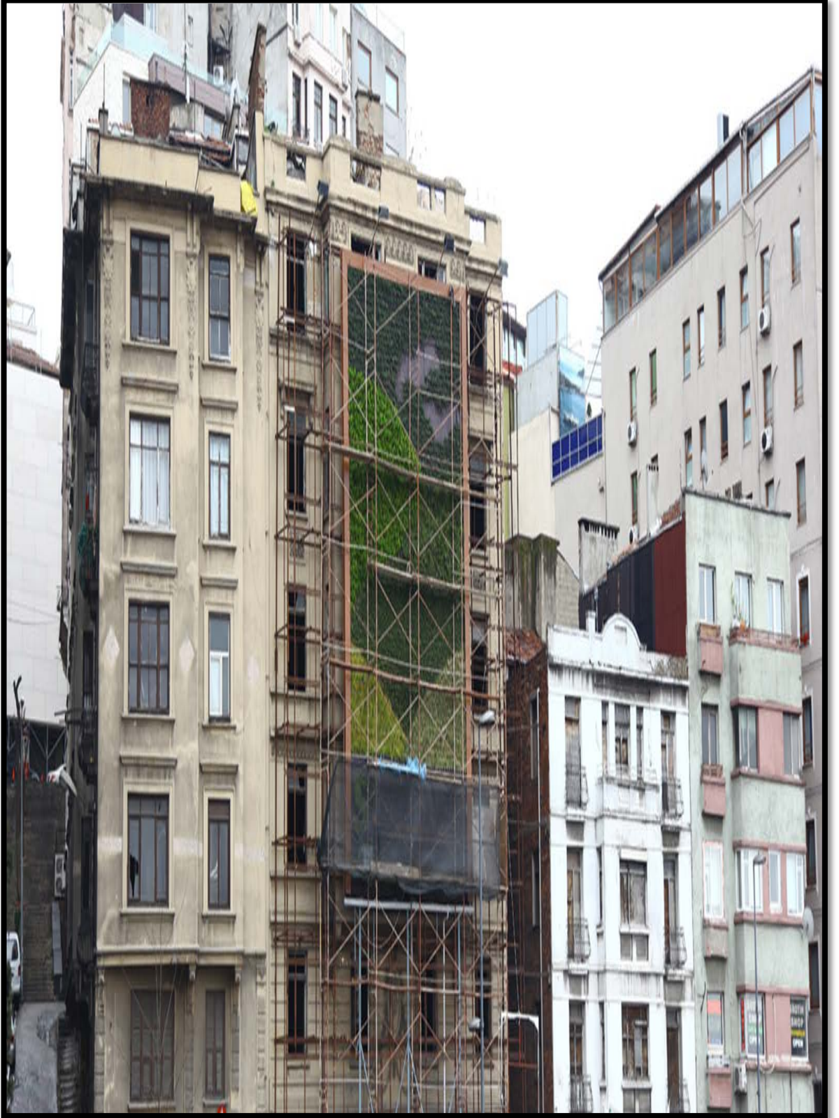
Şekil 3.98: Tarlabası Dış Mekan Dikey Bahçe Uygulamasında bitki dikimine devam edilmesi 10.04.2012 50 .
