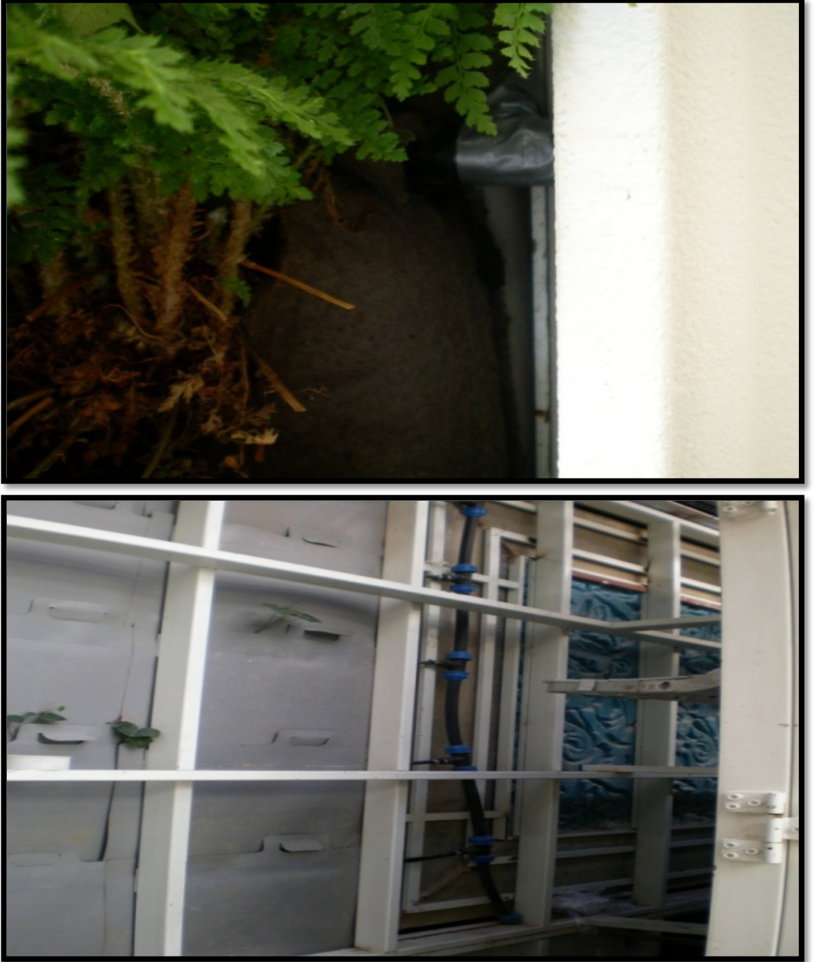
Şekil 3.84: Beşiktaş Shangri-La Bosphorus Otel Dış Mekan Dikey Bahçe Uygulaması'nda 20 lik delikli damlama sulama borusu (solda), 32 lik delikli damlama sulama borusu (sağda). İlk başlarda kurulan sistem zamanla karşılaşılan bazı problemlerden dolayı değişikliğe uğramıştır. Bitkileri besleyen 20 lik delikli damlama sulama borularının bazı delikleri bitkinin köküne değil de boşluğa denk gelmesinden dolayı eriyen bantla bu delikler kapatılmıştır ve bitkinin köklerini besleyecek şekilde yeni delikler açılmıştır. Dikey bahçenin üst kısmındaki deliklerin sayısı alttakilere nispeten daha az sayıda tutulmuştur.
