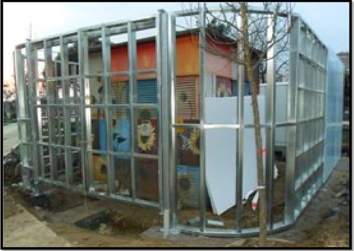
Şekil 3.70: Göztepe 60. Yıl Parkı Prof. Dr. Hulusi Behçet Caddesine bakan Dış Mekan Dikey Bahçenin tesisinden önce taşıyıcı profillerinin kurulumu ve PVC paneller.
