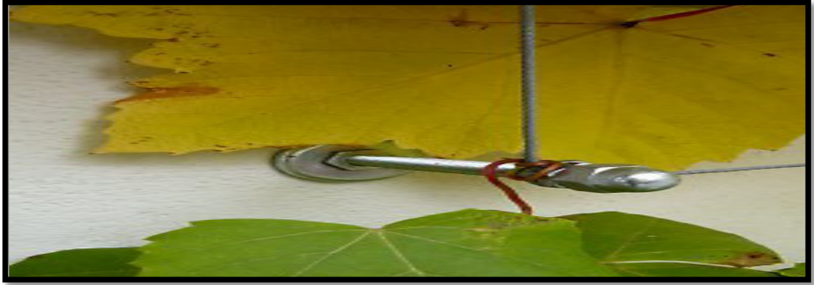
Şekil 2.31: Kablo ve Tel Örgü Ağ Sistemi Yeşil Cephelerde rüzgarın zayıf olduğu yerlerde sıra kablo sistemi 12 .
