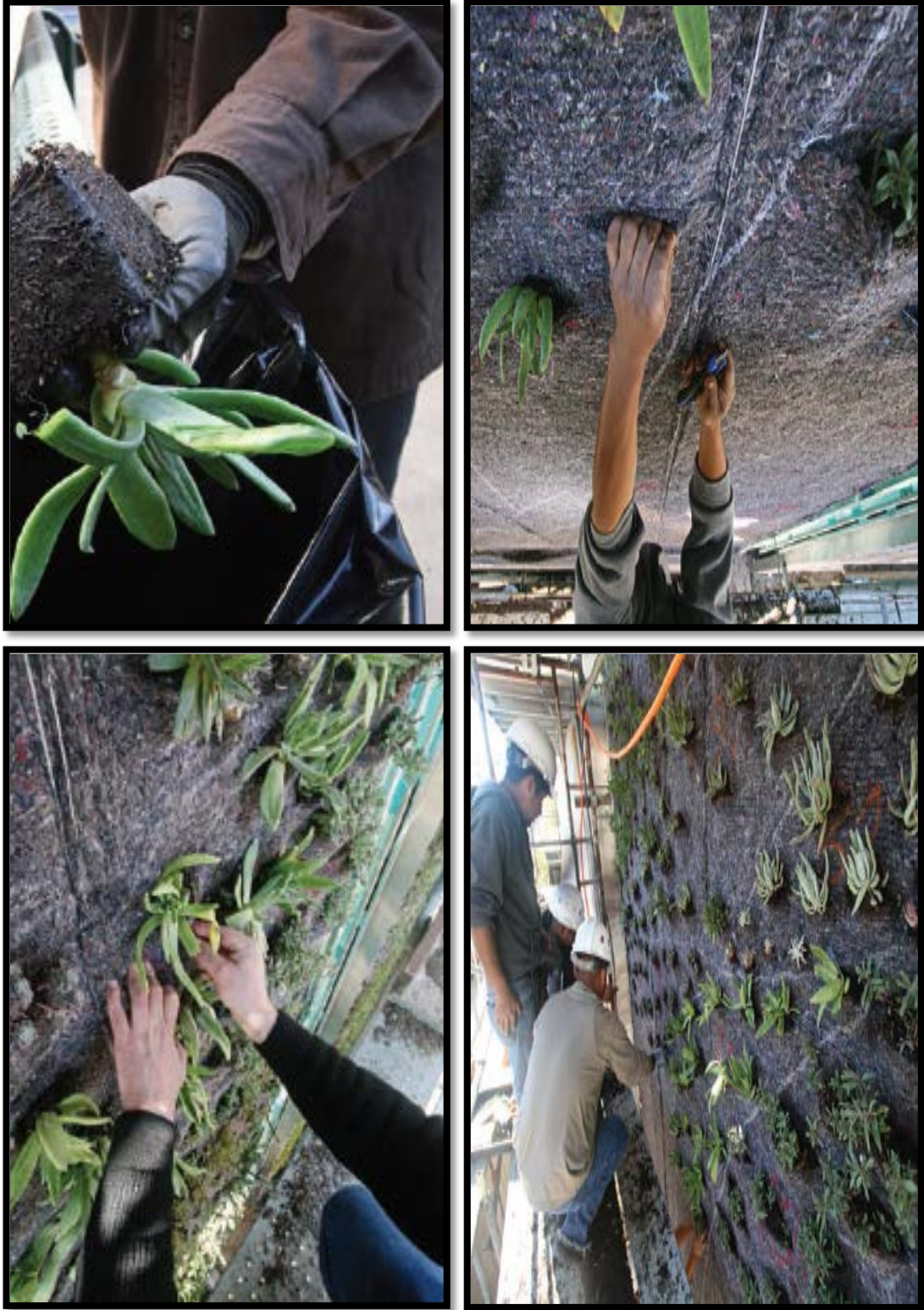
Şekil 3.39 (devam): San Fransisco Drew Okulu Dış Mekan Dikey Bahçe Uygulamasında Bitkilerin keçe katmanına dikimi (Furio, 2011).
