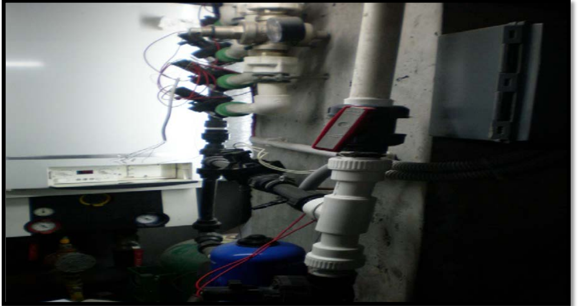
Şekil 3.48: Galata Art House Eczacıbaşı Malikanesi İç Mekan Dikey Bahçe Uygulamasının otomatik sulama ve gübreleme sistemi.
