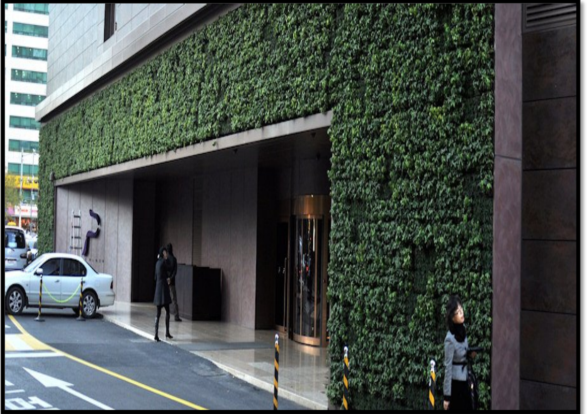
Şekil 2.56: Modüler yaşayan duvar sistemi örnekleri 14 .
