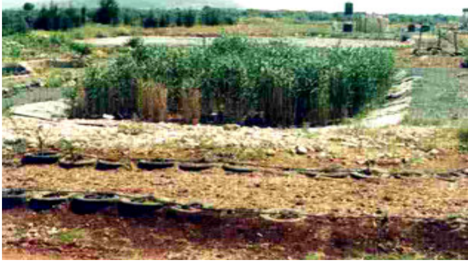
Şekil 1.8. Bitkilendirilmiş bir yapay sulak alan
