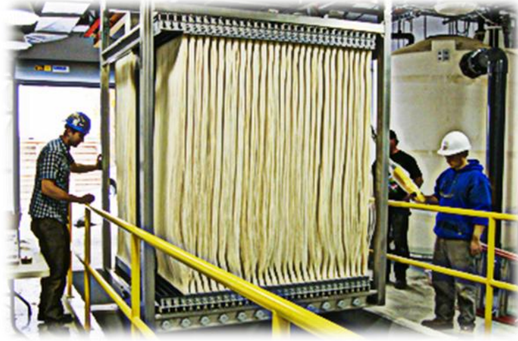
Şekil 2.4: Bir membran kasetinin tank içine konumlanması
