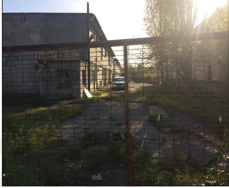
Fotoğraf 19: Atıl vaziyette duran Ersöz Sanayi Üretim Tesisleri
