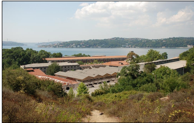
Fotoğraf 25: Beykoz Deri ve Kundura Fabrikası'nın Güncel Görünümü.
