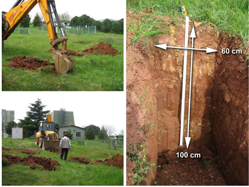
Şekil 3.11: Gebze istasyonları için seçilen alanda iş makinası vasıtası ile 4 adet çukurun açılması işlemi. Her bir çukur 60 cm genişliğinde ve 100 cm derinliğinde açılmıştır.
