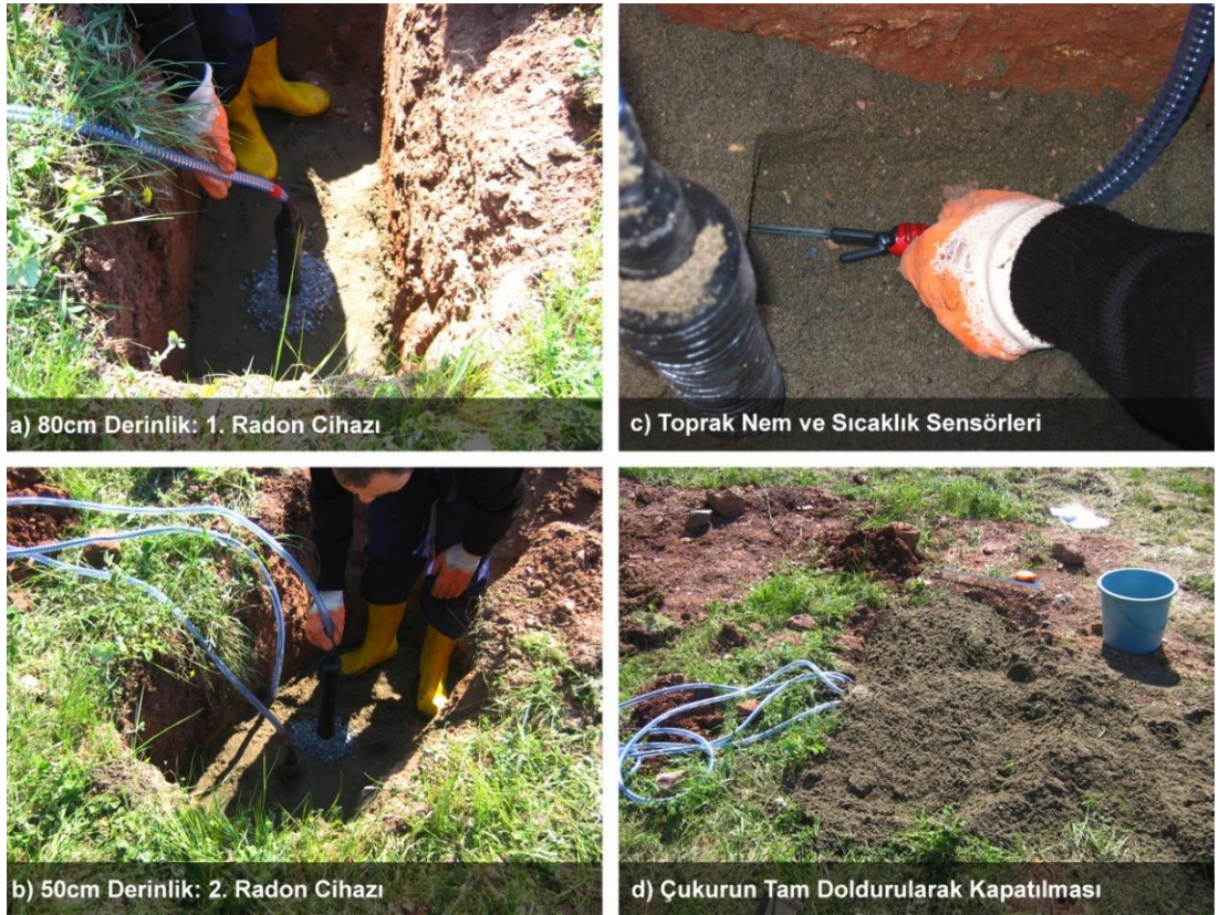
Şekil 3.12: Açılan çukurlara yüzeyden 80 cm ve 50 cm seviyelerine radon, toprak nem-sıcaklık sensörlerinin yerleştirilmesi.
