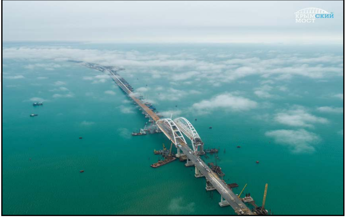
Resim 2.1. Kerch köprüsü fotoğrafı
