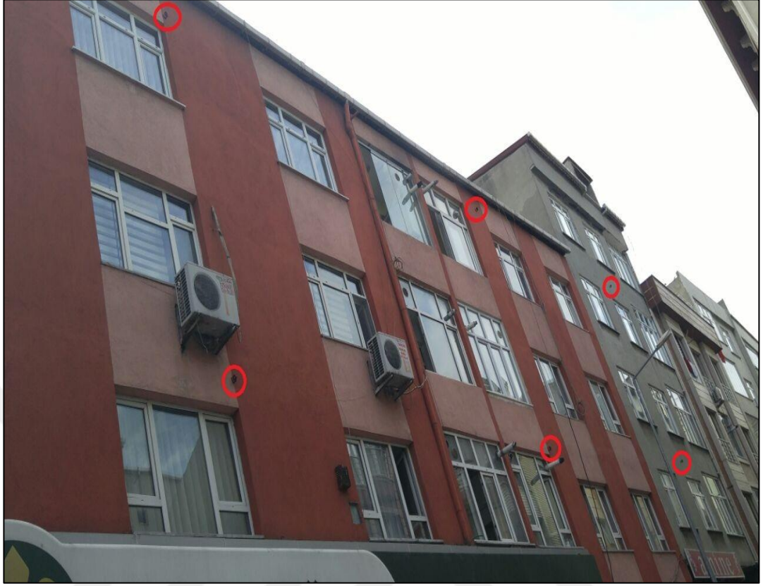
Şekil 3.7: Güzergah üzerinde bulunan binalara ait bina yatay deplasman reflektörü ölçüm noktalarının konumu.
