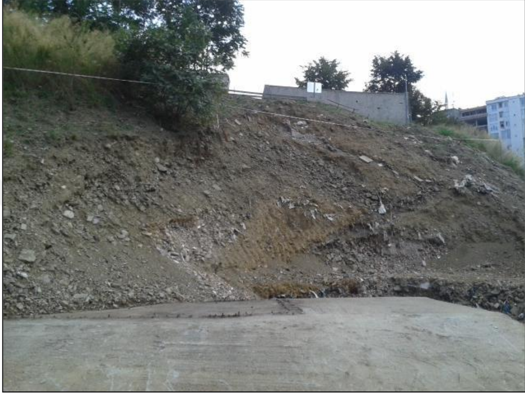
Őekil 4.9: Mecidiyeköy-Mahmutbey metro alıřmasında gözlenen yapay dolgu (yamaç molozu, akıl, kum).
