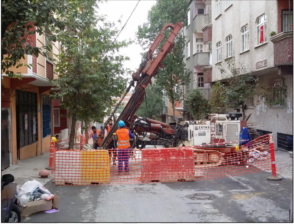
Şekil 4.71: Km 16+250 civarında gerçekleştirilen bina altı enjeksiyon çalışmaları.
