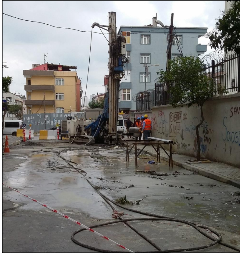
Şekil 4.71: Km 16+250 civarında gerçekleştirilen bina altı enjeksiyon çalışmaları.
