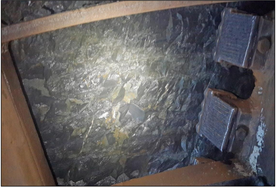
Şekil 4.3: Yenimahalle-Karadeniz İstasyonları arası Trakya Formasyonu'na ait km 15+507,526 ayna görüntüsü.
