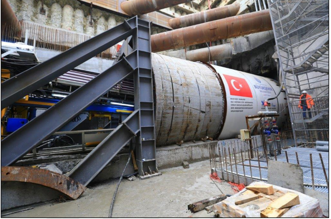
Şekil 2.6: Sol hattın açımında kullanılan Lovat marka TBM.
