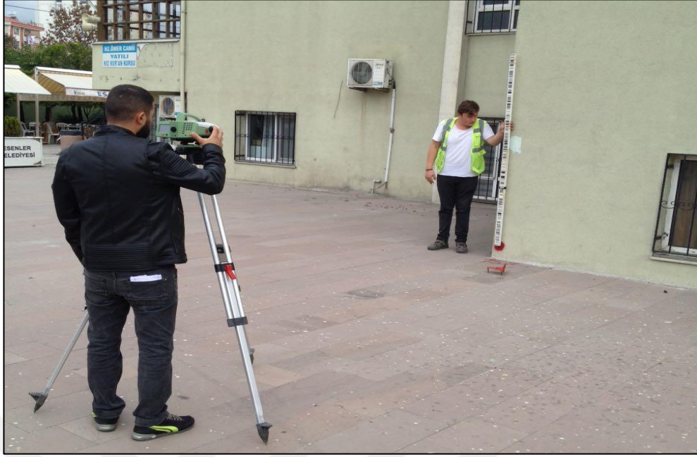
Şekil 3.4: Güzergah üzerinde bulunan bina oturma bulonu (BB) ölçümü.
