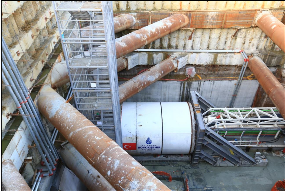
Şekil 2.6: Sol hattın açımında kullanılan Lovat marka TBM.
