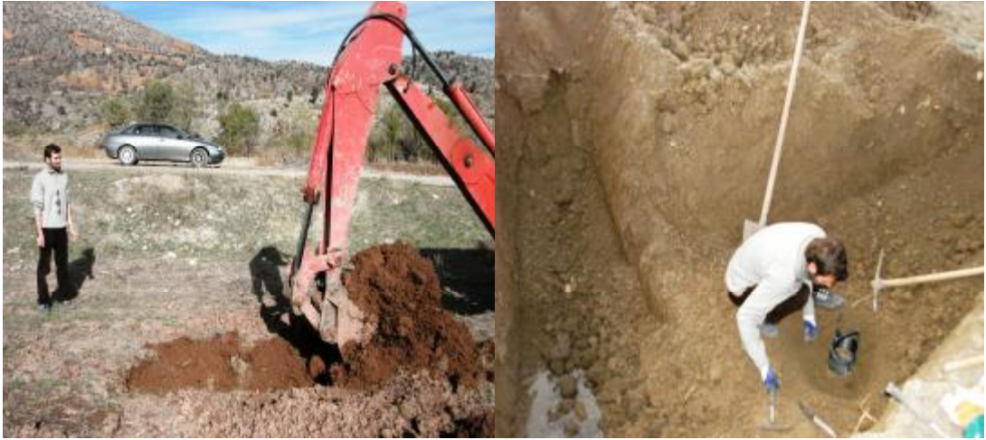
Şekil 3.1. Araştırma çukuru açılması
