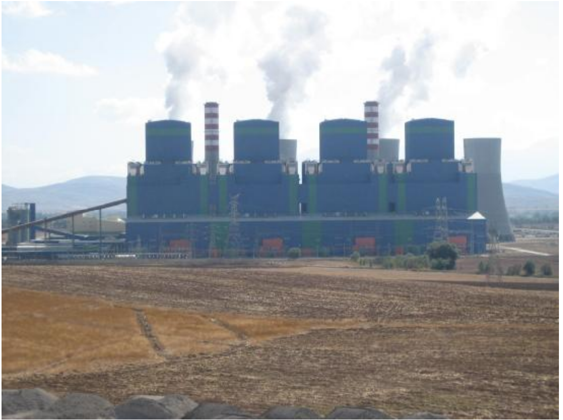
Şekil 3.1. Afşin-Elbistan-B Termik Santrali
