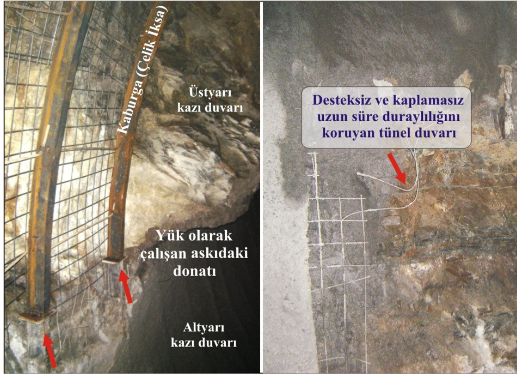
Şekil 4.32. Negatif destek sistemine rağmen sorunsuz açılan 8-Ağustos Tüneli.
