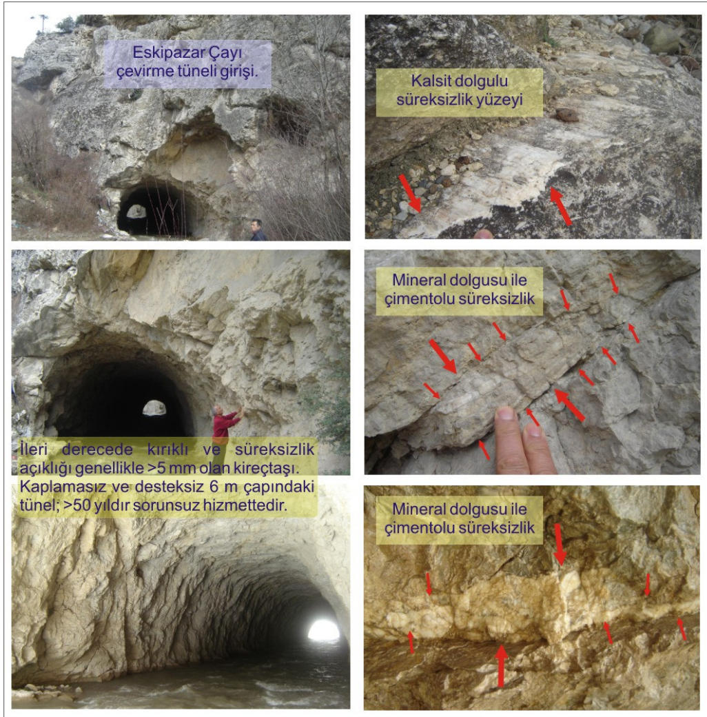
Şekil 4.33. “Ek” içerisinde 55 yıl önce açılmış desteksiz çevirme tüneli.
