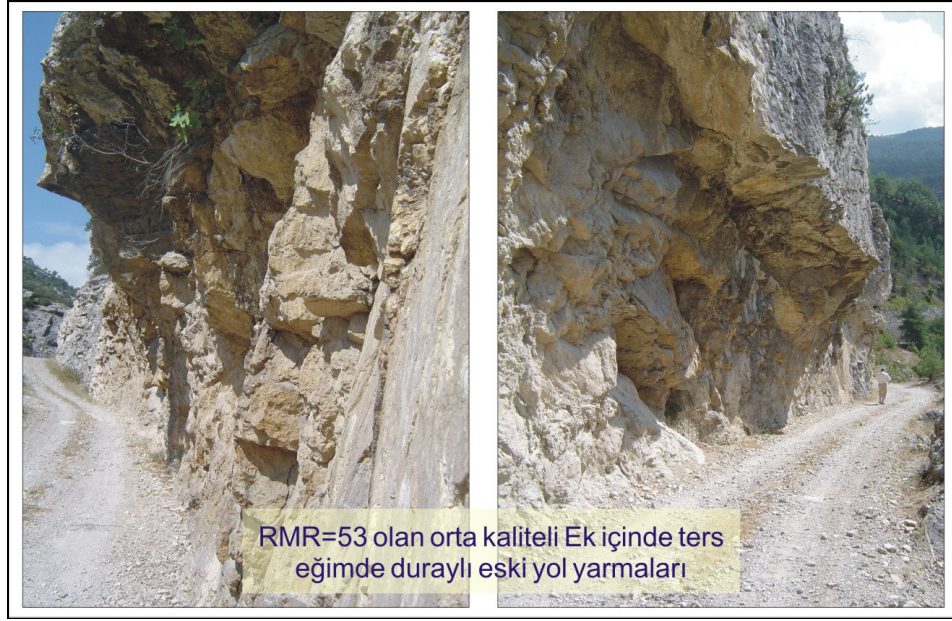
Şekil 4.34. “Ek” içerisinde ters eğimde duraylı eski yol yarmaları.
