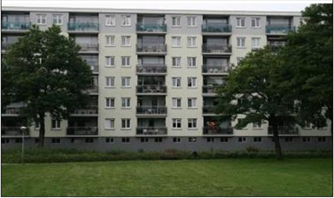
FOTO 8: Rotterdam Pendrecht Bölgesinde Yapılan Sosyal Konutlar
