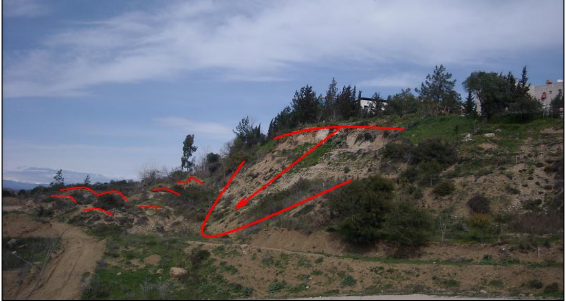
Şekil 4.52. İnceleme alanı heyelanlı kesimde bulunan 100. Yıl Mahallesi'nin batısında yer alan heyelanlı kesimde gelişmiş heyelan aynası
