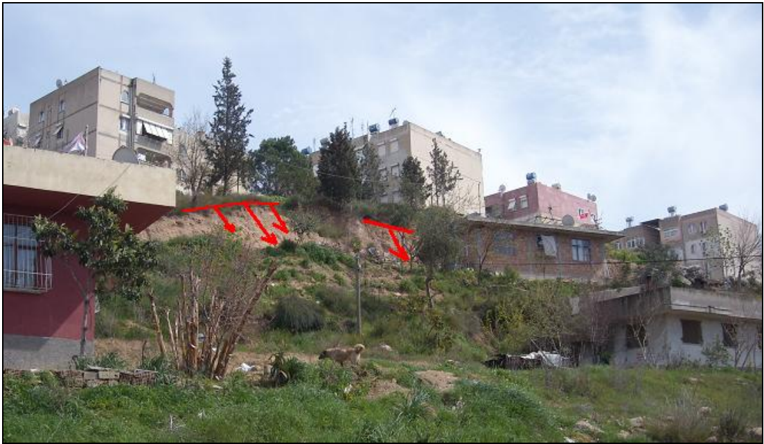
Şekil 4.53. İnceleme alanı içindeki heyelanlı kesimde, gelişmiş heyelan aynası ve yarım bırakılmış bazı konut inşaatları
