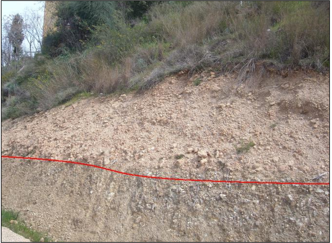
Şekil 4.54. Heyelanlı kesimin eğim yukarısında bulunan kaliçi birimi ve Handere Formasyonu dokanağı
