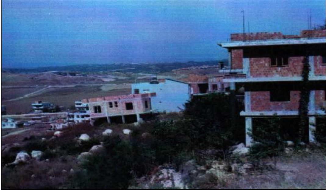
Şekil 4.8. İnceleme alanında Handere Formasyonu'nda oluşan heyelanlı kesimden bir görünüm
