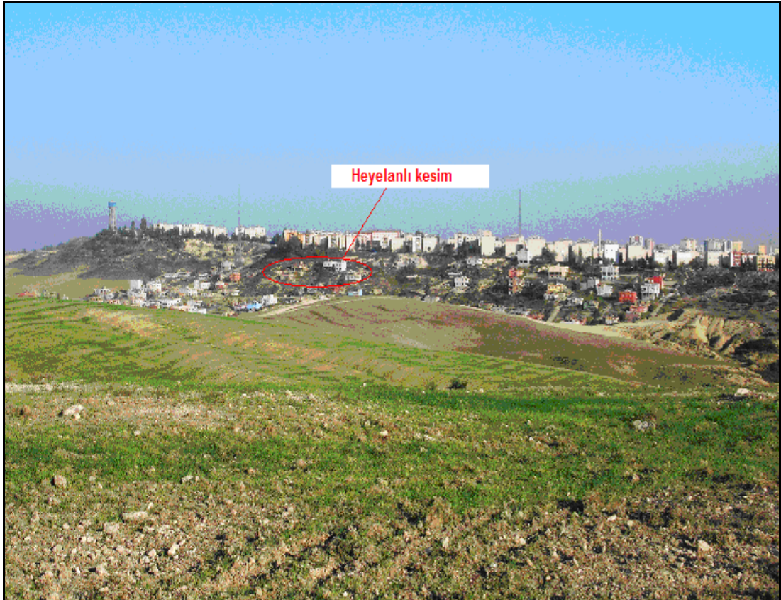
Şekil 1.1. İnceleme alanı içerisinde bulunan heyelanlı kesimin görünümü
