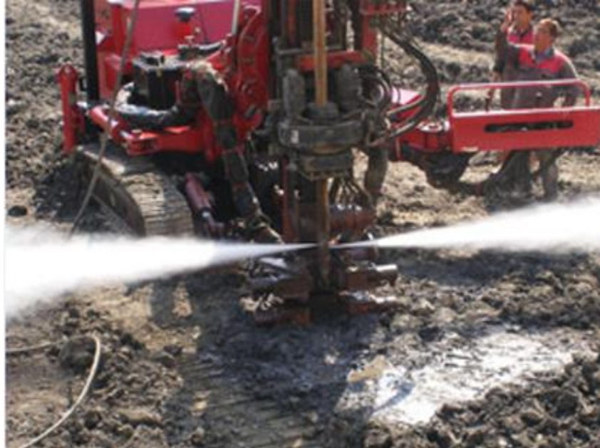
Şekil 3.5. Enjeksiyon Aşaması (Nozzlelerden Grout Çıkışı)
