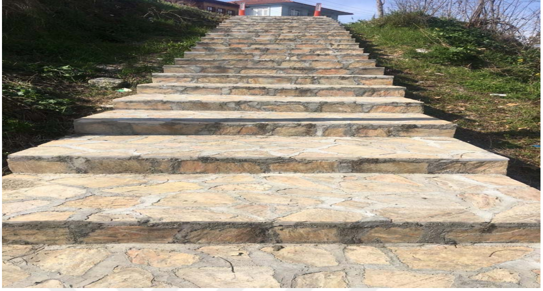
Resim 2.1: Bartın Çayı Kenarında Kayrak Taşı İle Kaplanmış Yürüyüş Yolundan Görünüm.
