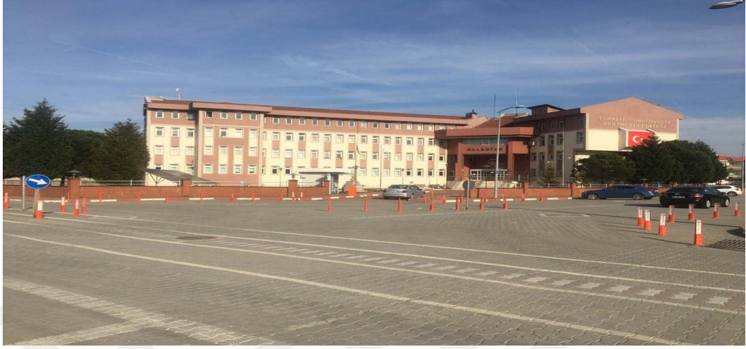
Resim 4.4 : Kemerköprü Mahallesi’nde Belediye Binasından Bir Görünüm.
