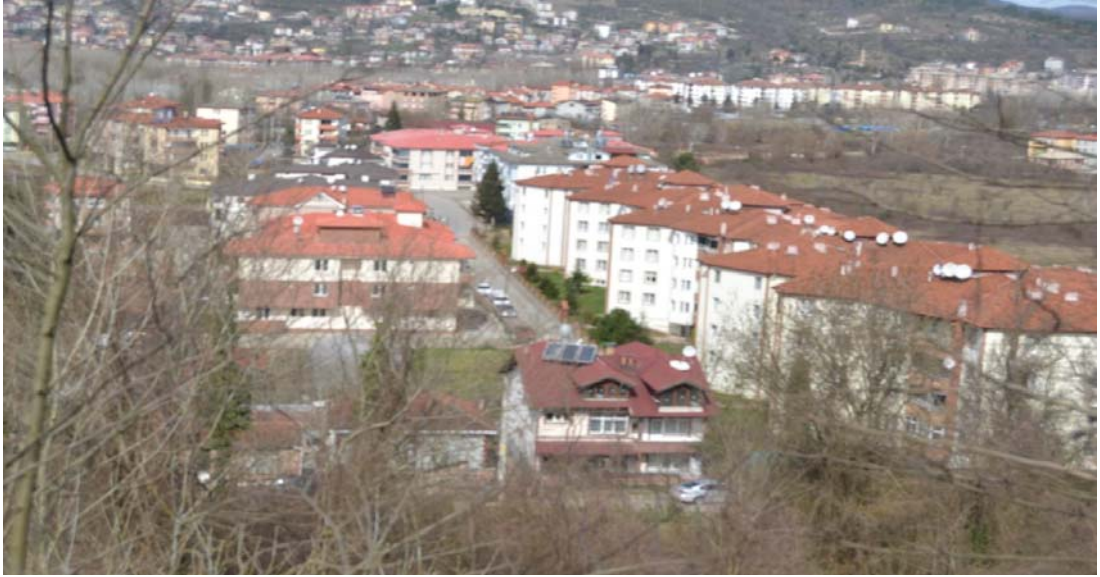
Resim 4.22 : Orduyeri Mahallesi'nde Sitelerden ve Müstakil Binalardan Görünüm.
