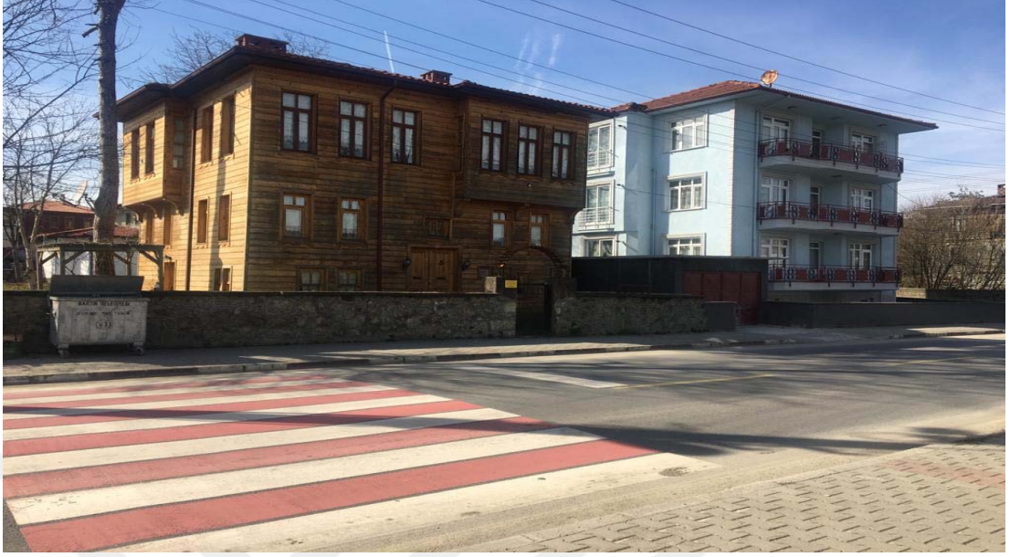
Resim 4.20 : Okulak Mahallesi’nde Farklı Tarzda Yapılmış Mesken Tiplerinden Bir Görünüm.
