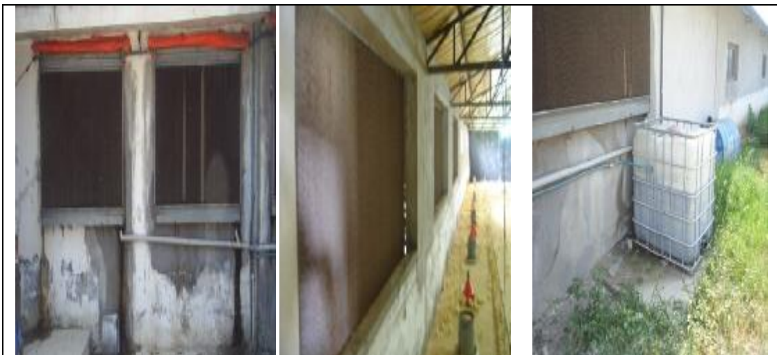
Şekil 3.16. Islak pad ve su deposu
