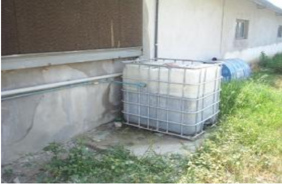
Şekil 2.9. Islak Pad ve Su Deposu
