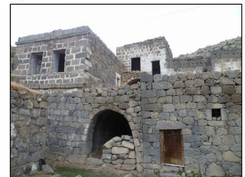
Niğde Murtaza Köyü Batı Yakası Yerleşmesi Yapı Grubu 4
