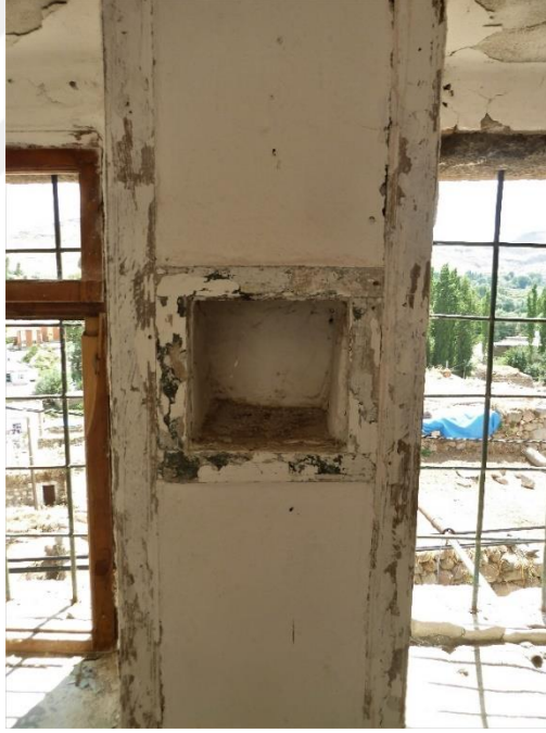
Fotoğraf 5.30: Yapının inşası sırasında duvar yüzeylerine bırakılan bu küçük boşluklara farklı kullanım senaryolarına göre niş, yemlik, tavukluk, erzak dolabı gibi farklı işlevler yüklenir.
