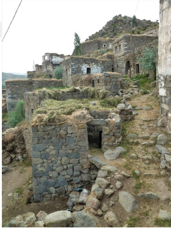
Fotoğraf 5.19: Arazinin eğimli ve engebeli yapısı nedeniyle yapılar girişten tek, arka cepheden ise, iki katlıdır
