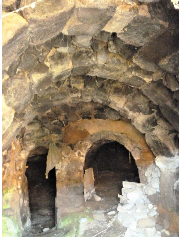
Fotoğraf 5.16: Kayaoyma+Yığma bir yapı. Bu yapı bir yaşam birimiyken bir süre sonra hayvanların tutulduğu bir ahıra dönüştürülmüştür (Burak Falay Arşiv).
