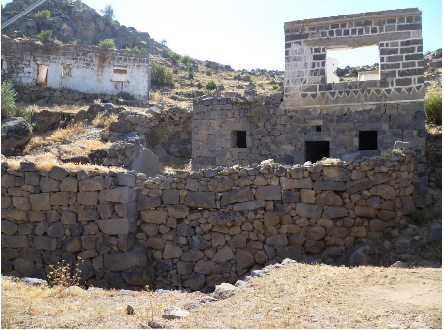
Fotoğraf 5.38: Moloz ve kaba yonu taş duvar örgü sistemi. Her iki örgü tekniğinde de yapı köşelerinin dik açılı ve düzgün kesme taşlar ile örüldüğü görülmektedir (Burak Falay Arşiv).
