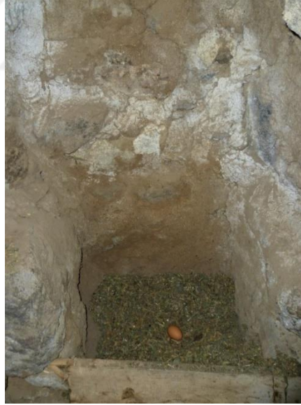
Fotoğraf 5.22: Yaşam alanı olan bir birimin ahıra dönüştürülmesi nişlerin bir tahta parçası ile yemliğe çevrilmesi ile gerçekleşir. Aynı biçimde, tavukluk adı verilen mekânlarda, yemliklerin tavukların yumurtladıkları alanlar olarak kullanılmaya başlamasıyla üretilir
