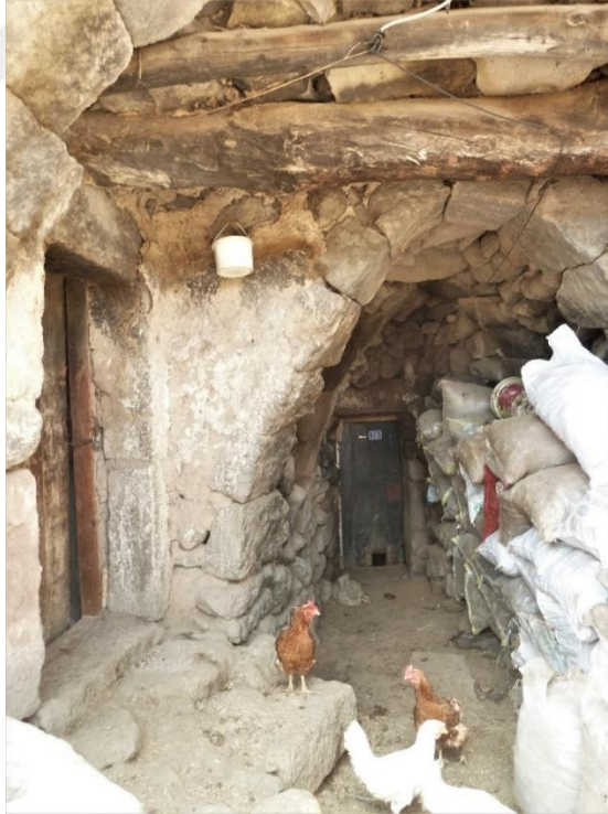
Fotoğraf 5.27: Yapının dışarı ile bağlantısını sağlayan ve günlük işlerinde yapılabildiği eyvanlı bir yapı örneği
