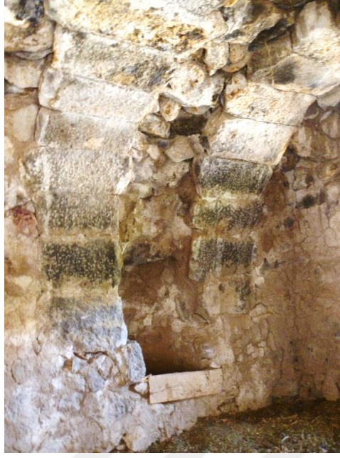
Fotoğraf 5.23: Daha önce yaşam alanı olarak kullanılan bir oda zaman içinde ahıra dönüştürülmüştür. Bu dönüşüm, duvar yüzeyinde niş olarak kullanılan bir boşluğun bir tahta ile yemliğe çevrilmesi kadar hızlı ve pratiktir
