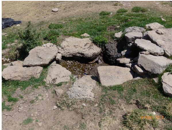
Fotoğraf 5.52: Serinlikler dere yatakları üzerinde inşa edilen, bozulabilecek gıdaları dereden akan suyun içinde taze tutmayı amaçlayan yiyecek saklama depolarıdır (Burak Falay Arşiv).
