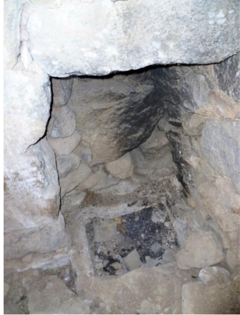
Fotoğraf: 5.15: Kayaoyma+yığma sistemli yapıların kayalardan oluşan duvarlarının yüzeylerine açılmış iki ocak örneği. Ocaktan türen dumanın yapı dışına tahliyesi için duvarın içinden açılan ve üst örtüye ulaşan gizli boşluklar vardır
