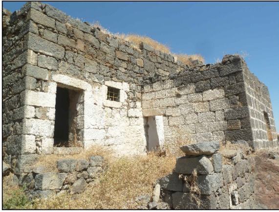
Niğde Murtaza Köyü Batı Yakası Yerleşmesi Yapı Grubu 8
