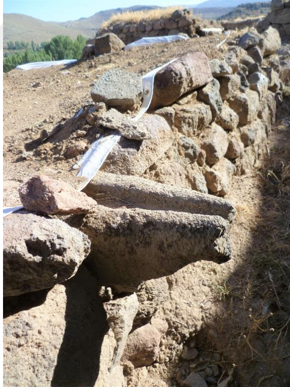
Fotoğraf 5.34: Saçağın altından yapı duvarlarının dışına doğru çıkıntı yapan cephe ögeleri çörtener, yakın çevreden temin edilen volkanik taşların işlenmesi ile oluşturulmuştur
