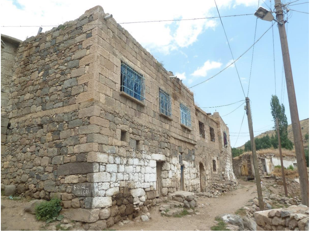
Fotoğraf 5.18: Yığma sistemle inşa edilmiş iki katlı bir yapı. Alt katı moloz taş duvar örgü sistemi ile inşa edilmiştir. Üst kata geçildiğinde ön cephesi yonu taş duvar örgü ile örülürken, yan cephe moloz taş duvar örgü sistemi ile tamamlanmıştır (Burak Falay Arşiv).
