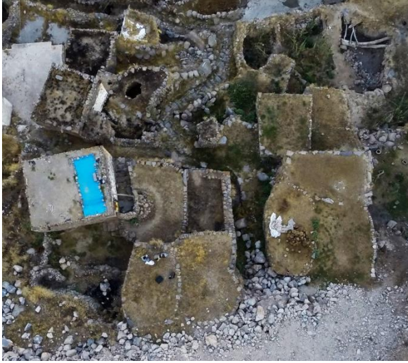
Fotoğraf 5.42: Şırlaz adı verilen toprakla karışık malzeme örtü sistemini ve yapının içini dış koşullara karşı izole eder. Bu malzeme yuvağ adı verilen silindir bir taşla sertleşene kadar ezilerek dama yayılır
