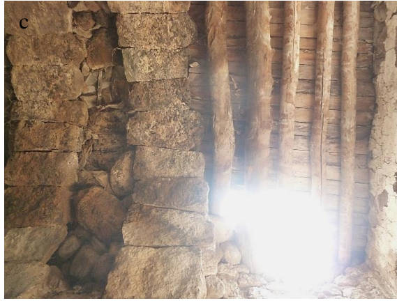
Fotoğraf 5.41: Duvar içine yaklaşık 20 cm gömülerek yerleştirilmiş olan hezenlerin daire biçimli izleri ve üzerine örten kalın toprak dolgunun kesiti (a). Hezenlerin aralarındaki boşlukları kapatmak amacıyla kalın dallar kullanılmıştır (b). Ayrıca kemer ve hezen sisteminin birlikte uygulandığı örneklerde bulunur (c) (Burak Falay Arşiv).
