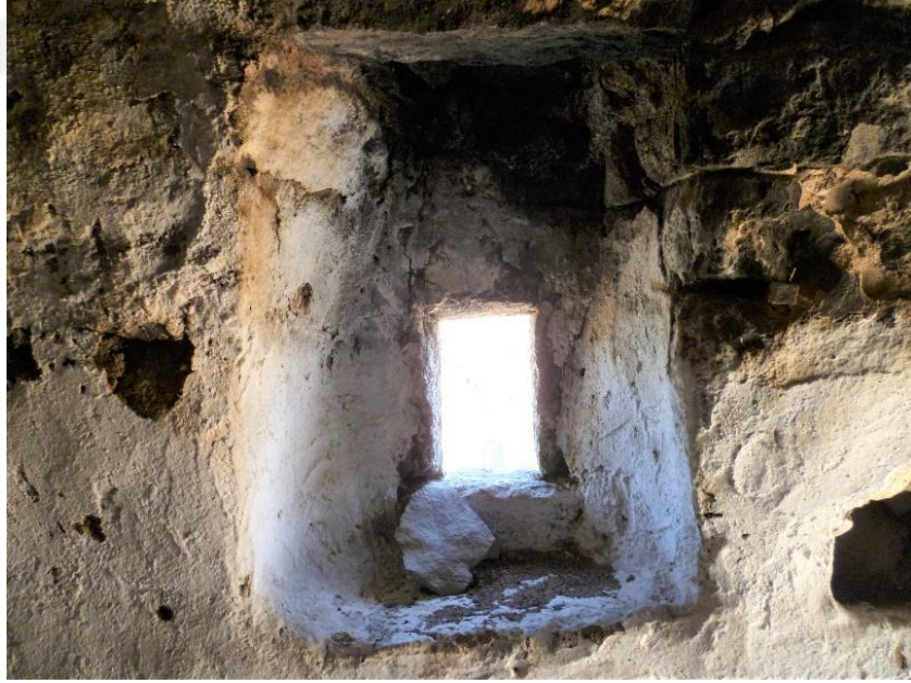
Fotoğraf 5.33: Pencere açıklıkları ufak tutulmuş kasaları ise, ahşap ya da taş malzeme ile oluşturulmuştur
