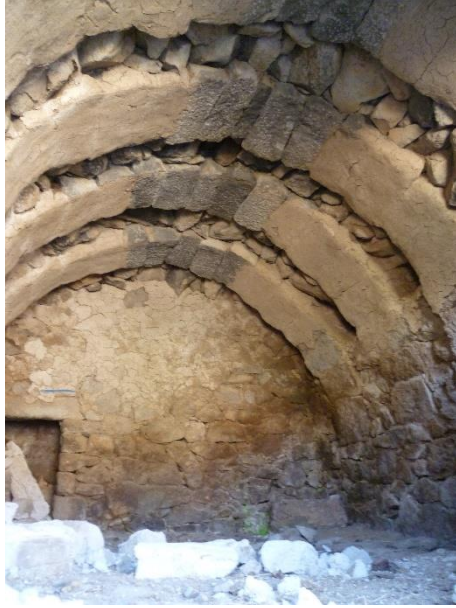
Fotoğraf 5.40: Kemer ayaklarının dayanak duvarından başlayarak yükseldiği görülmektedir. Kaburga kemerleri olarak adlandırılan ana taşıyıcı kemerler düzgün kesilmiş taşlardan oluşturulmuştur. Kaburga kemerlerinin aralarını dolduran moloz taşlar ise, kapak kemerlerini meydana getirmektedir. Niş, pencere ve kapı gibi boşluklar ise, ana kemere değil, kapak kemerlerini oluşturan ara kemerlere açılmıştır (Burak Falay Arşiv).
