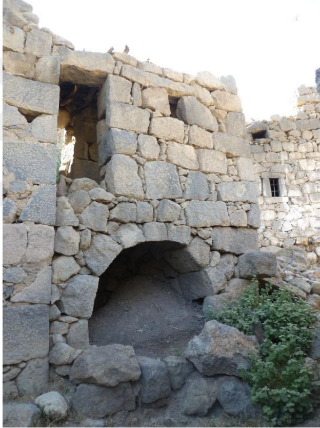
Fotoğraf 5.29: Hela yaşam alanlarından ayrı tutulan bir yapı birimidir. Atıklar tuvalet taşının altına açılan derin bir çukurun içine dolmaktadır. Bu çukurun içi ocaklardan alınan küllerle doldurularak atıkların zararlı etkilerinden korunulmaya çalışılır. Atıkların küllerle karıştıktan bir süre sonra çukurlar boşaltılır (Burak Falay Arşiv).
