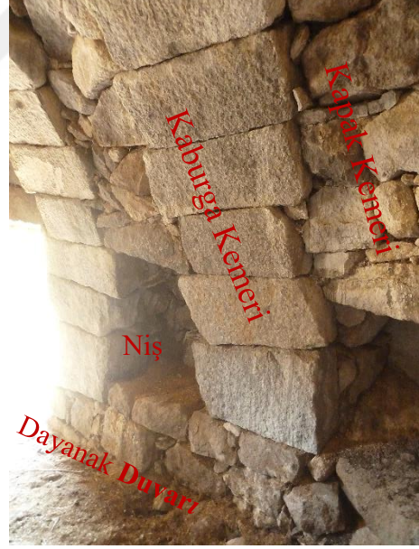
Fotoğraf 5.40: Kemer ayaklarının dayanak duvarından başlayarak yükseldiği görülmektedir. Kaburga kemerleri olarak adlandırılan ana taşıyıcı kemerler düzgün kesilmiş taşlardan oluşturulmuştur. Kaburga kemerlerinin aralarını dolduran moloz taşlar ise, kapak kemerlerini meydana getirmektedir. Niş, pencere ve kapı gibi boşluklar ise, ana kemere değil, kapak kemerlerini oluşturan ara kemerlere açılmıştır (Burak Falay Arşiv).
