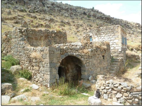
Niğde Murtaza Köyü Batı Yakası Yerleşmesi Yapı Grubu 1
