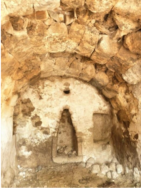
Fotoğraf: 5.15: Kayaoyma+yığma sistemli yapıların kayalardan oluşan duvarlarının yüzeylerine açılmış iki ocak örneği. Ocaktan türen dumanın yapı dışına tahliyesi için duvarın içinden açılan ve üst örtüye ulaşan gizli boşluklar vardır
