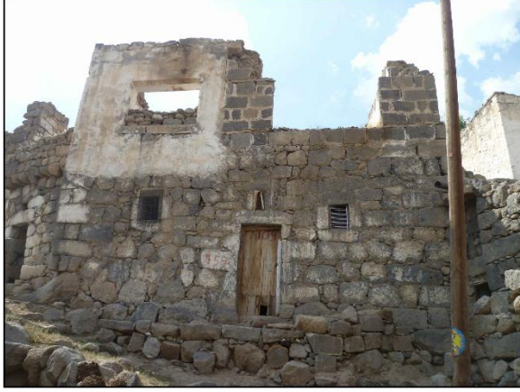
Niğde Murtaza Köyü Batı Yakası Yerleşmesi Yapı Grubu 3
