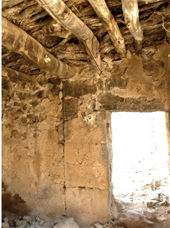
Fotoğraf 5.26: Yapıların örtü sistemi, atkı kemerli tonoz ile hezen adı verilen ağaç hatılların kullanıldığı iki ayrı sisteme dayanır
