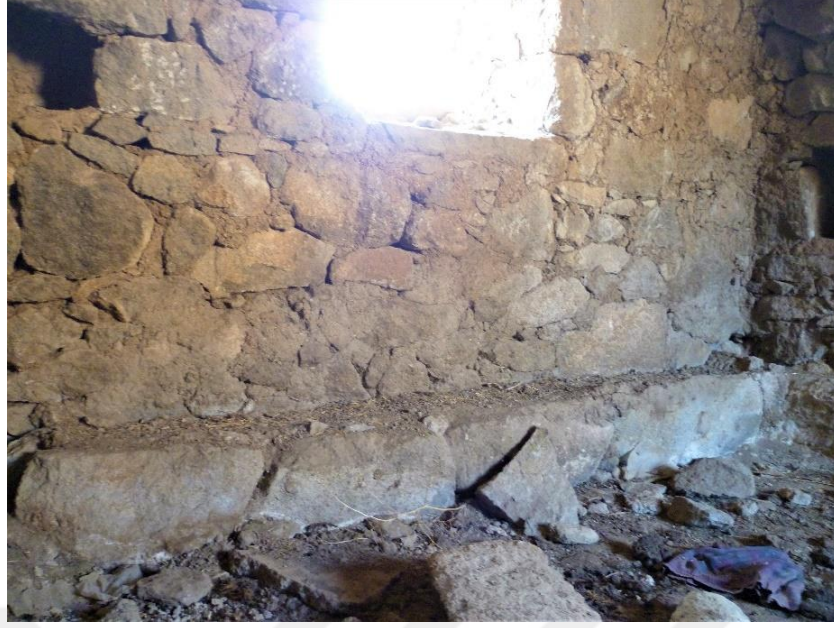
Fotoğraf 5.21: Yapının iki duvarı arasında uzanan 25-30 cm yükseklikteki sıralı taş dizisi bir sekiyi oluşturmaktadır. Seki üzerine atılan bir döşekle oda içinde oturma ve dinlenme faaliyetleri gerçekleştirilir
