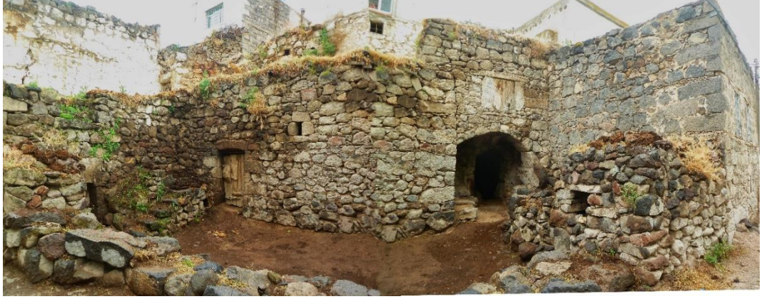
Fotoğraf 5.17: Yığma sistemle inşa edilmiş tek katlı bir yapı
