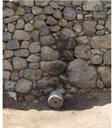
Fotoğraf 5.42: Şırlaz adı verilen toprakla karışık malzeme örtü sistemini ve yapının içini dış koşullara karşı izole eder. Bu malzeme yuvağ adı verilen silindir bir taşla sertleşene kadar ezilerek dama yayılır
