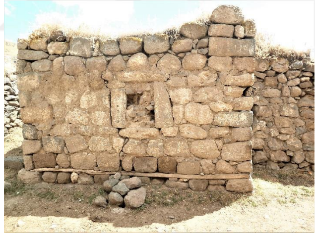
Fotoğraf 5.37: Yapıların beden duvarları kaya yüzelerine ya da subasman duvarların üzerine oturmaktadır
