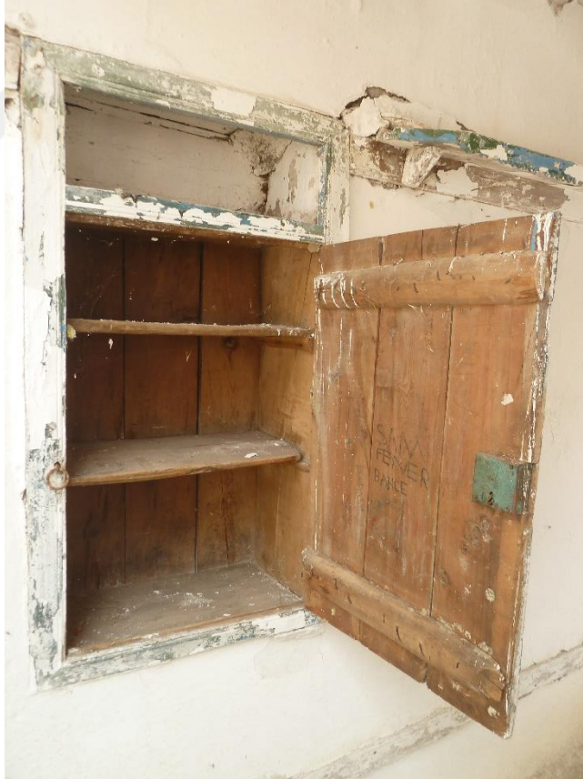
Fotoğraf 5.31: Ahşap kapak ve raflarla yüklük olarak işlevlendirilen bir niş (Burak Falay Arşiv).
