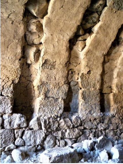
Fotoğraf 5.37: Yapıların beden duvarları kaya yüzelerine ya da subasman duvarların üzerine oturmaktadır
