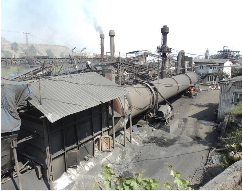
Şekil 4.32: Kurutma tesisi genel görünüm.
