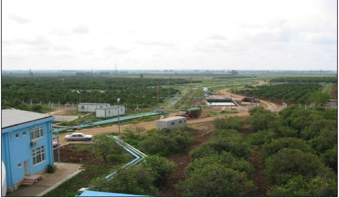
Şekil 3.1. Çalışma alanı Arabali Tuz İşletmesi'nin genel görünümü
