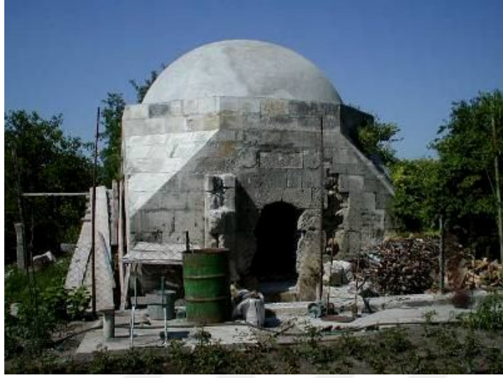
F. 62 Kırım (Eskiyurt) Beyhude Sultan Türbesi (Uçar, 2009)
